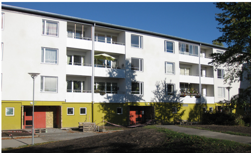
Figur 7. Lagrådsgatan i Eskilstuna
