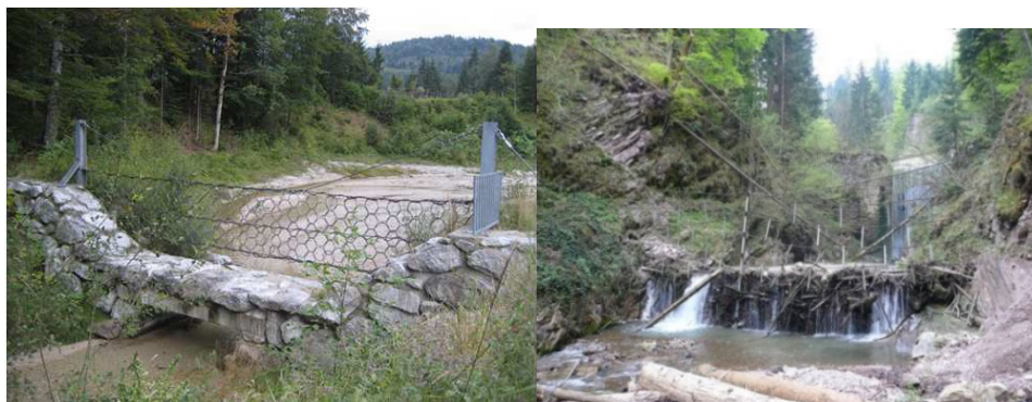
Figur 8 Till vänster i figuren en fälla i form av nät vid mynningen av mindre tillflöde, Österrike 2007 [1]. Till höger ses Seilnetzsperre över Geschiebesperre (Kranzbach, Oberbayern, Foto: Asenkerschbaumer) [14].
