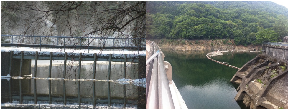
Figur 4 Nät – Till vänster vertikalt implementerat nät på balkar i Granö HPP, Sverige, samt till höger hängnät implementerat på pontoner i Kisenyama HPP, Japan [19].
