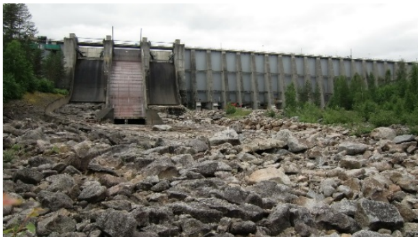
Figur 12 Bottenutskov i Ramsel dam placerade till vänster om ytutskov nr 1 i strömningsriktningen.
