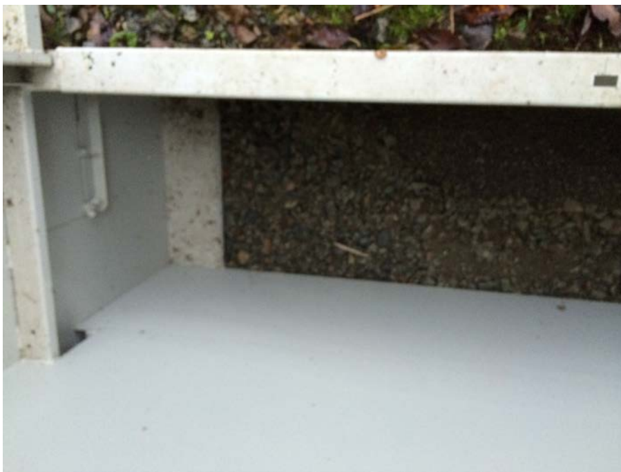
Foto 4 Nummer 10. Ingen korrosion.
