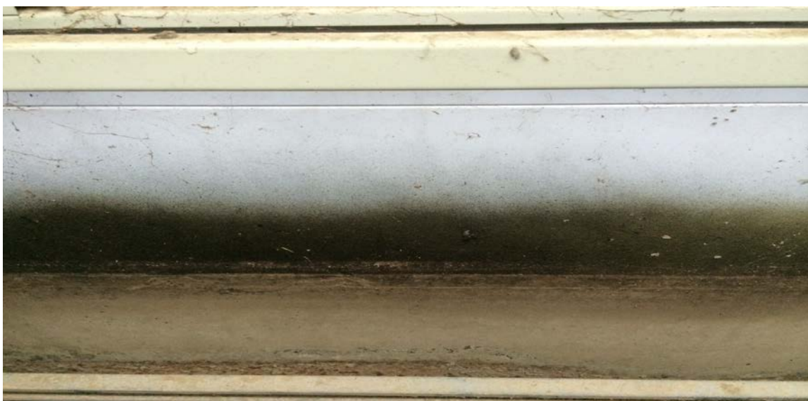
Foto 8 Nummer 25. Ingen korrosion på insidan trots hög ålder. Målad och tjärad.
