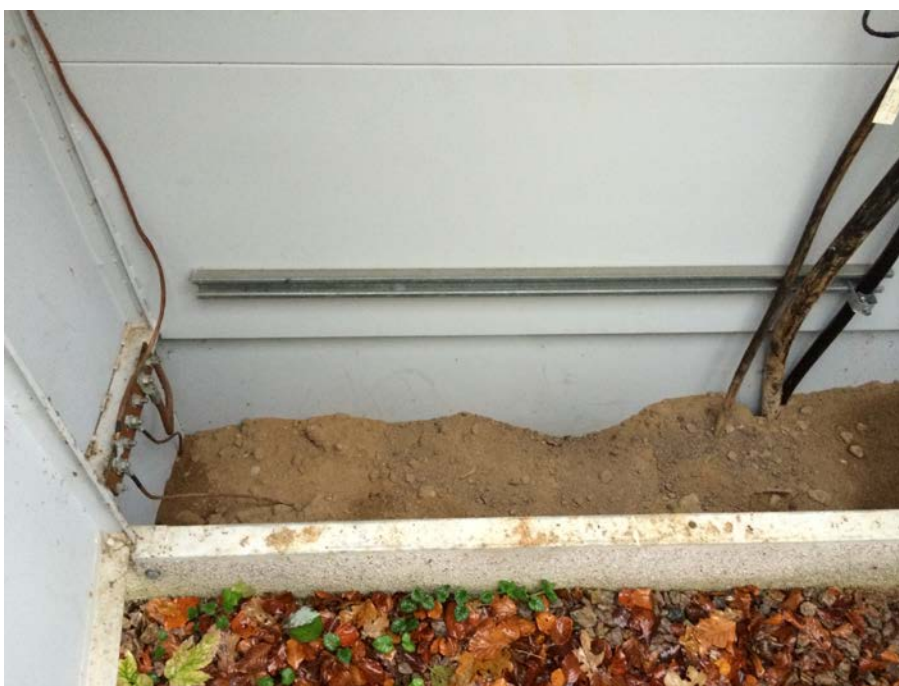
Foto 5 Nummer 18. Ingen korrosion.
