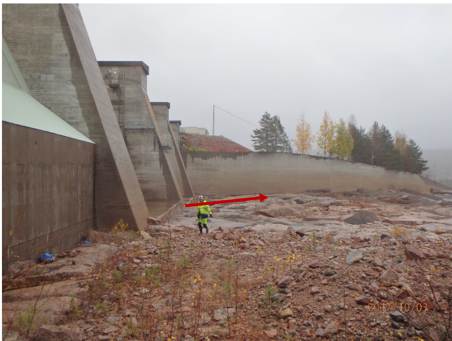
Figur 37: Harsprångets utskovsparti och kanal, från höger sida. Motlut i kanalen markerat med röd pil. Foto: Norconsult, 2017.
