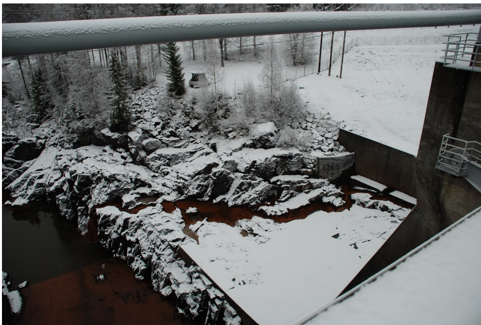
Figur 77 Krångfors. Översiktsbild över höger och mittenutskovet. Berggrundens linsiga form syns väl avslöjat av snötäcket. Notera även den dominerande sprickgruppen tvärs kanalen. Bergytan direkt nedströms utskoven är delvis övergjuten.
