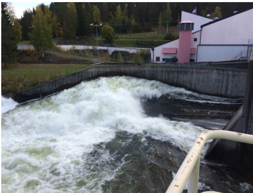
Figur 65: Full tappning genom höger utskov i Finnfors. Vattensprång och komprimering av vattenstrålen längs den högra ledmuren. (Källa: Skellefteå Kraft, FDU 2014).
