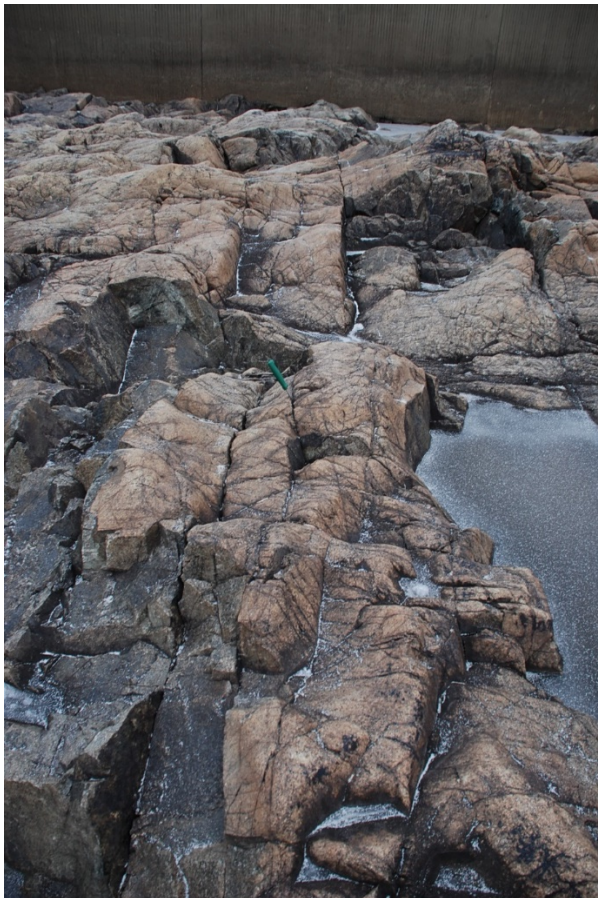
Figur 74 Rengård. Dominerande spricksystem tvärs kanalen med ställvis öppna sprickor. Notera även rissen samt färskta brottytor längs rissen. Notera även det bortslitna blocket till höger om knivskäftet.
