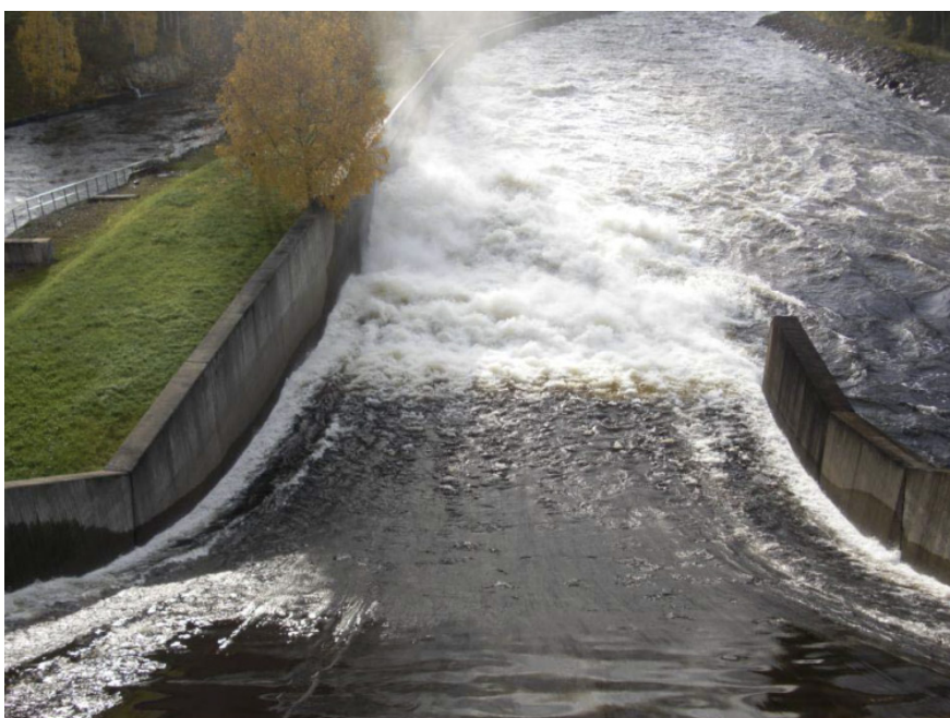
Figur 58: Avbördning genom vänster utskov i Båtfors, oklart vilken tappning. Vattensprång bildas vid övergång till torrfåra ca 20 m nedströms skibordet. Källa: Vattenfall R&D.
