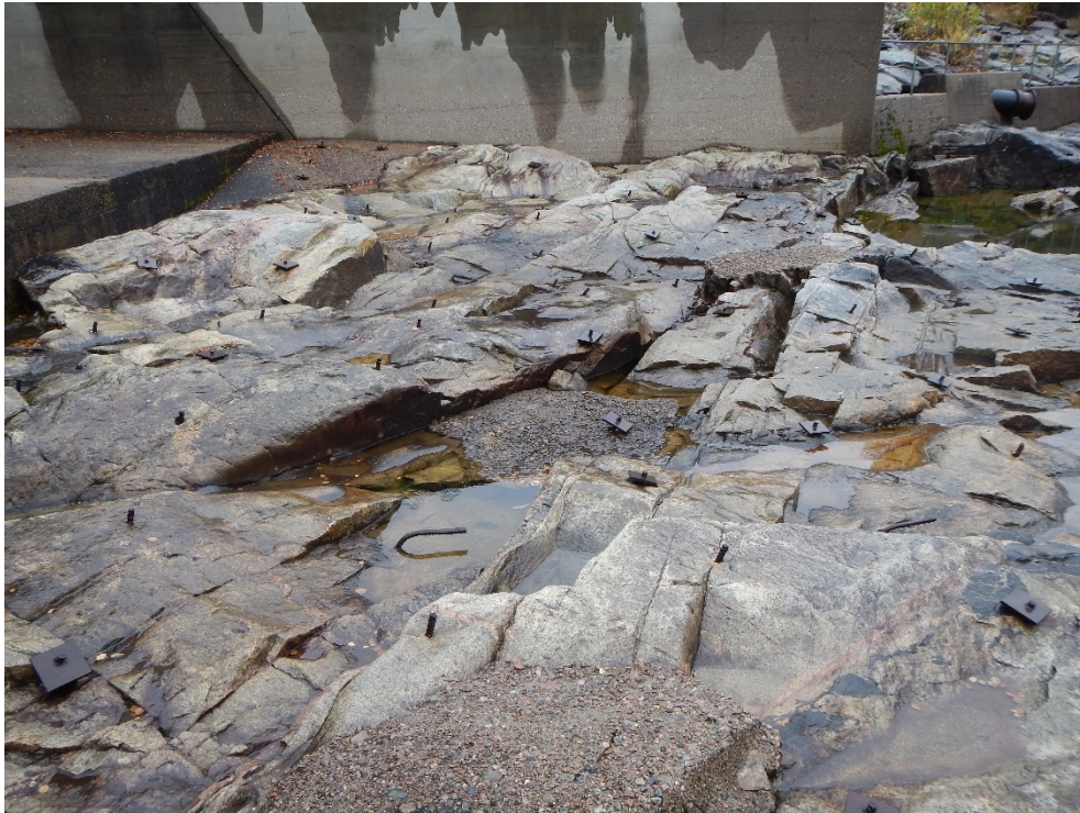
Figur 45 Akkats. Detalj av bergytan direkt nedströms vänster utskov. Flödesriktning från vänster i bild.
