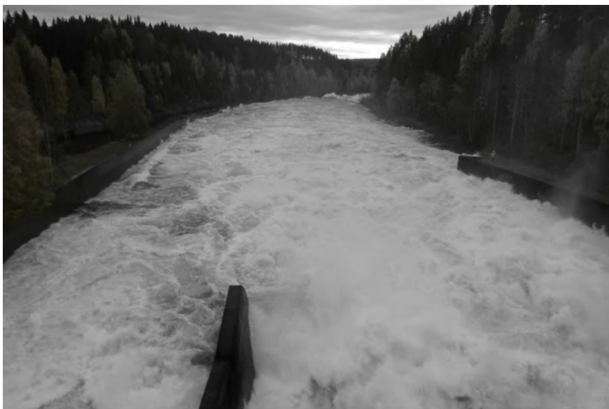
Figur 59: Avbördning genom alla tre utskov i Båtfors, uppskattad tappning 700 m 3 /s. Källa: Skellefteå Kraft AB.
