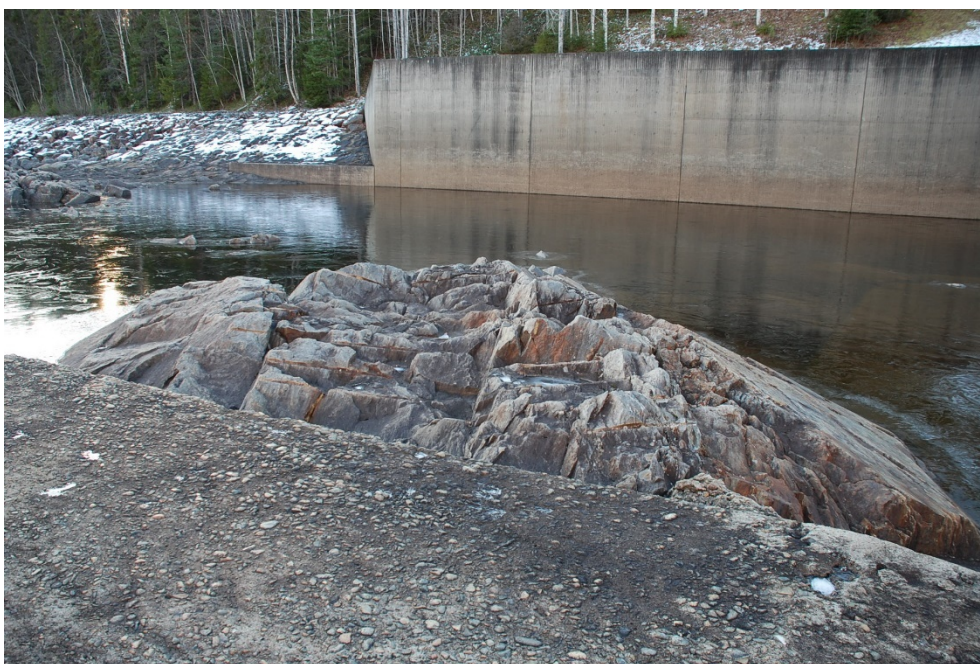
Figur 54 Båtfors. Detalj av berggrunden direkt till höger om vänster utskovs skibordsläpp. Notera den dominanta sprickgruppen som skär kanalen, de flacka sprickplanen på höger sida av berghällen.
