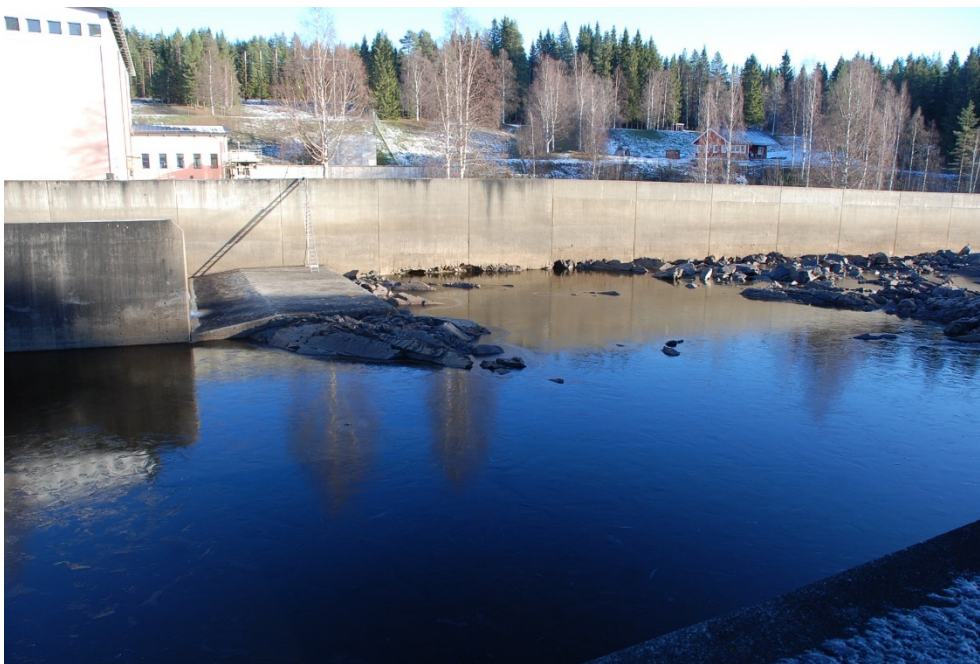
Figur 55 Båtfors. Vy mot vänster utskov. Notera bortslitna flacka block under ledmuren samt den dominerande sprickgruppen som bildar ryggar i vattenspegeln.
