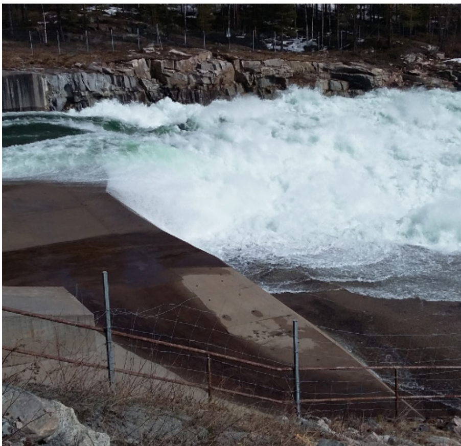
Figur 52: Tappning i vänster utskov i Ligga, okänd tappning. Ett vattensprång bildas nedströms skibordsförlängningen. Källa: Vattenfall (2017)
