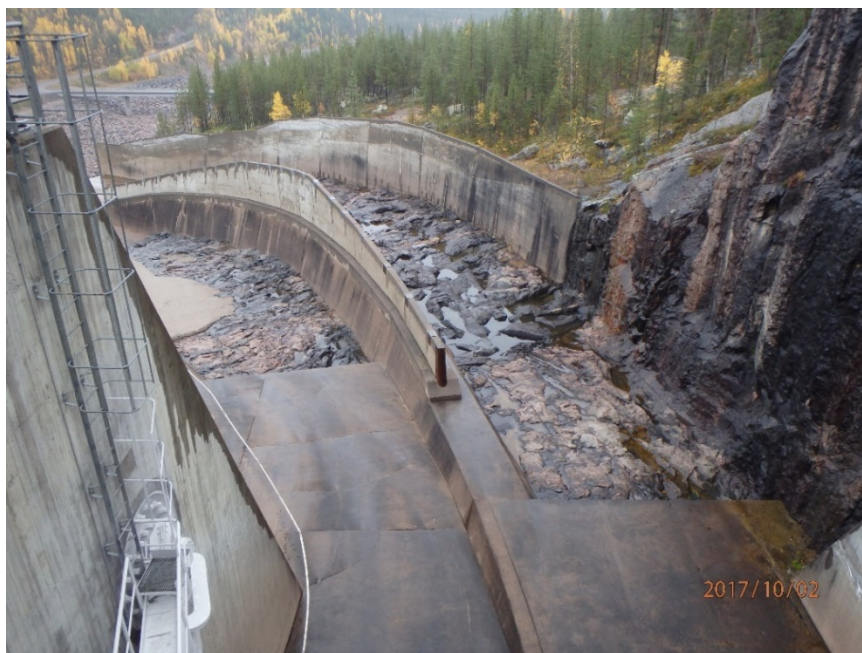
Figur 20: Letsi utskovskanal. Notera att kanalen lutar och kröker påtagligt. Foto: Norconsult (2017).
