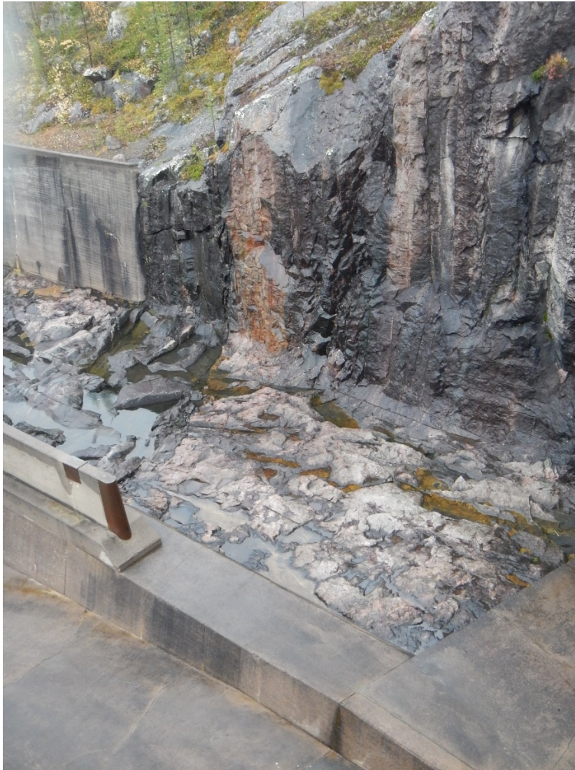
Figur 17 Letsi. Fotografi över utskovskanalen. Notera den röda granitiska bergarten, den mörka mafiska. Avsaknaden av horisontella bankningsplan. Den relativt korta spårlängden av sprickor som inte utgör bergartsgränser.
