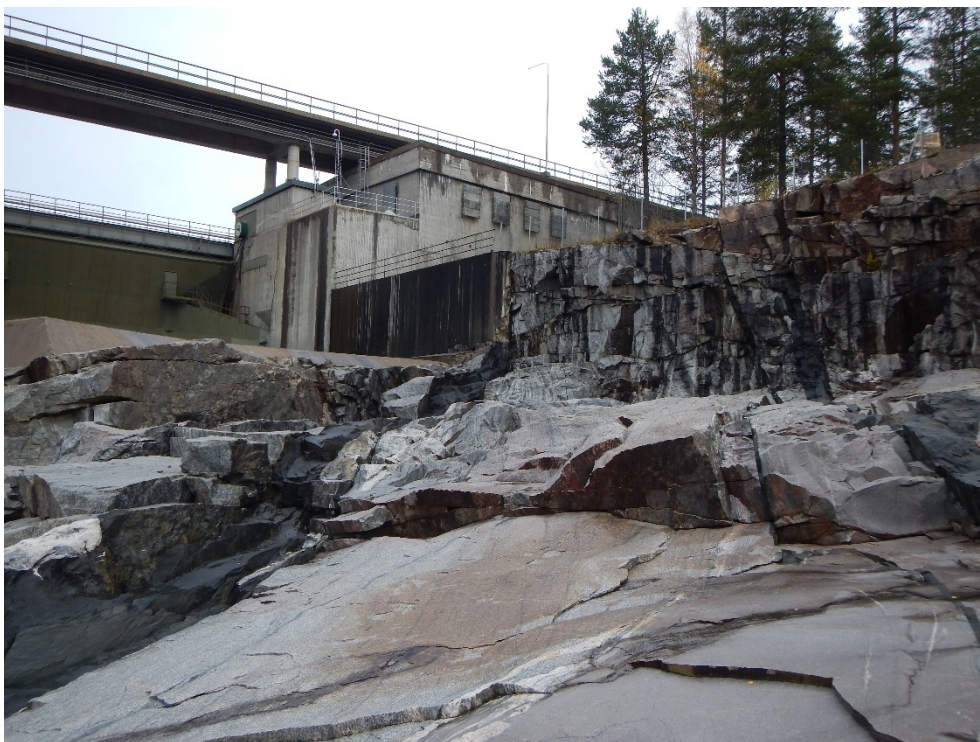
Figur 49 Ligga. Uppström vy över vänster utskov. Notera de flacka bankningsplanen som sträcker sig ned till botten av den sprängda kanalen samt bankningsplanens relativa tunnhet.
