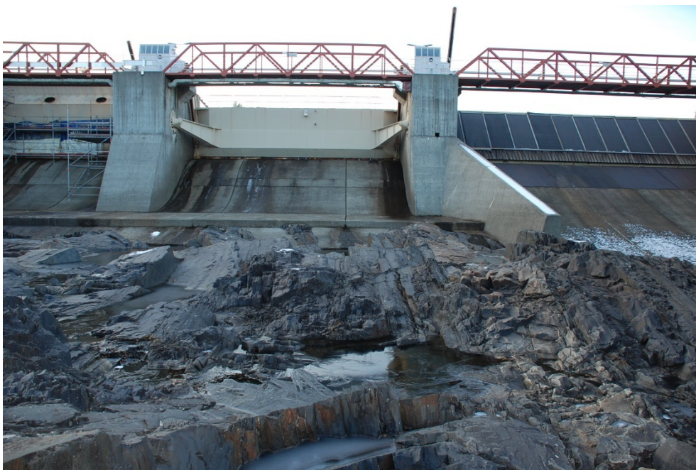
Figur 63 Finnfors. Uppströms vy över mittenutskovet. Notera den ställvis i plan tätt uppspruckna karaktären hos bergmassan.
