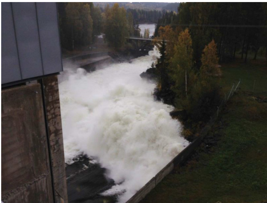
Figur 83: Provtappning i höger utskov i Krångfors, i samband med FDU (2015). Källa: Skellefteå Kraft.
