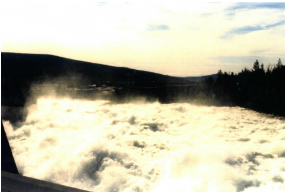
Figur 38: Foto från provtappning 1997, 1400 m 3 /s, som antas vara jämnt fördelat mellan de tre utskoven. Källa: Vattenfall.
