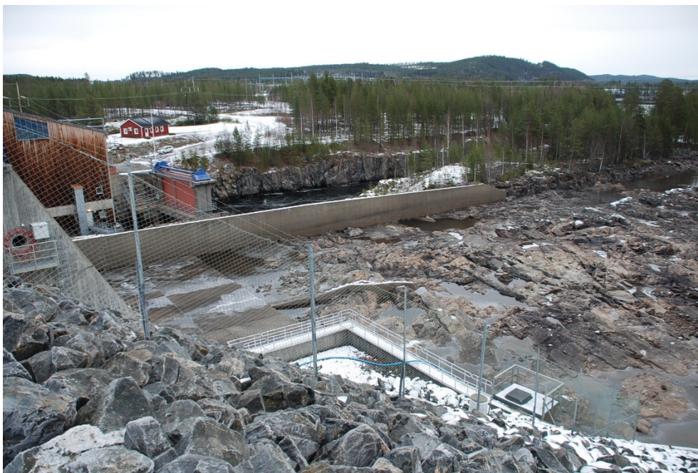
Figur 72 Rengård. Översikt över utskovskanalen inklusive schaktad kanal som tar vid ungefär vid ledmurens slut. Notera den dominerande strukturen tvärs kanalen.
