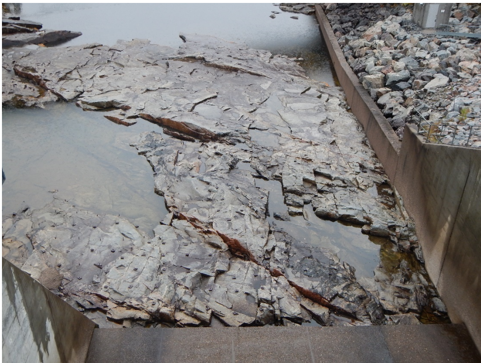
Figur 44 Akkats. Detalj över bergytan direkt nedströms höger utskov. Notera den rikliga bergförstärkningen samt de flacka sprickplanen.
