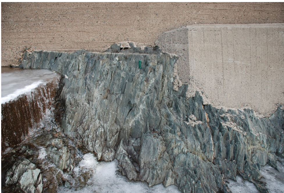
Figur 68 Grytfors. Detalj av förskiffrad berggrund vid vänster skibords tungas slut.
