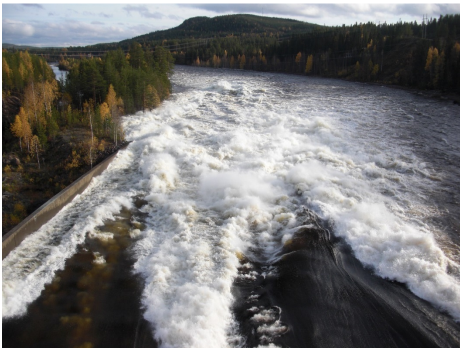
Figur 76: Provtappning i Rengård, med fri avbördning genom båda utskoven (Foto: Skellefteå Kraft).
