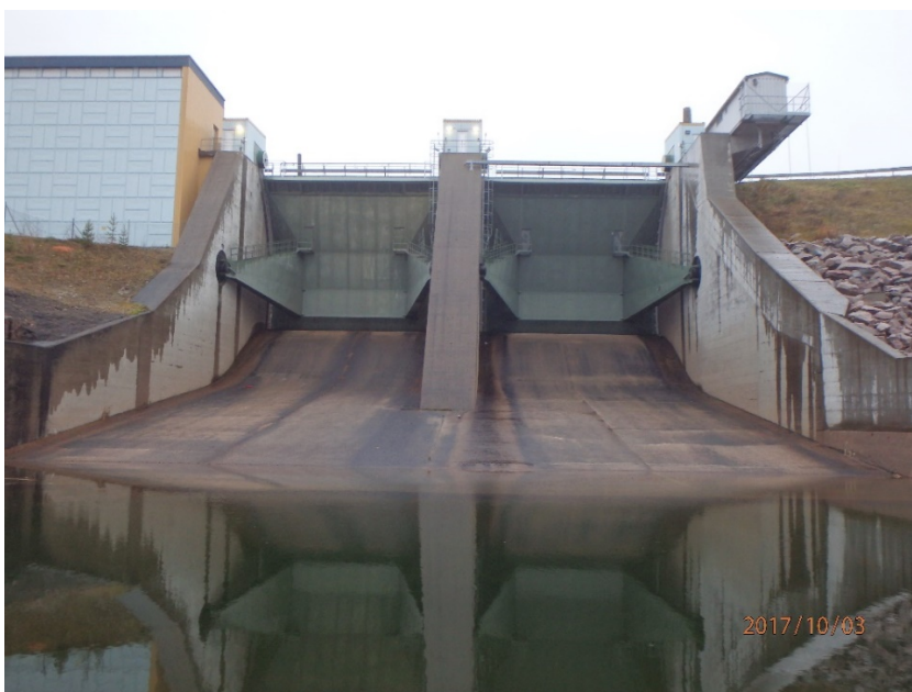
Figur 31: Porjus utskovsparti. Skibordsförlängning ner i bassäng med stötvägg. Foto: Norconsult, 2017.
