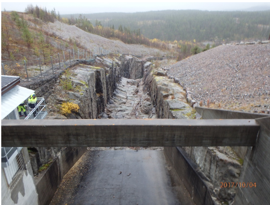
Figur 41: Seitevare utskovskanal, skibordet för ytutskovet och övre delen av kanalen. Foto: Norsoncult, 2017.
