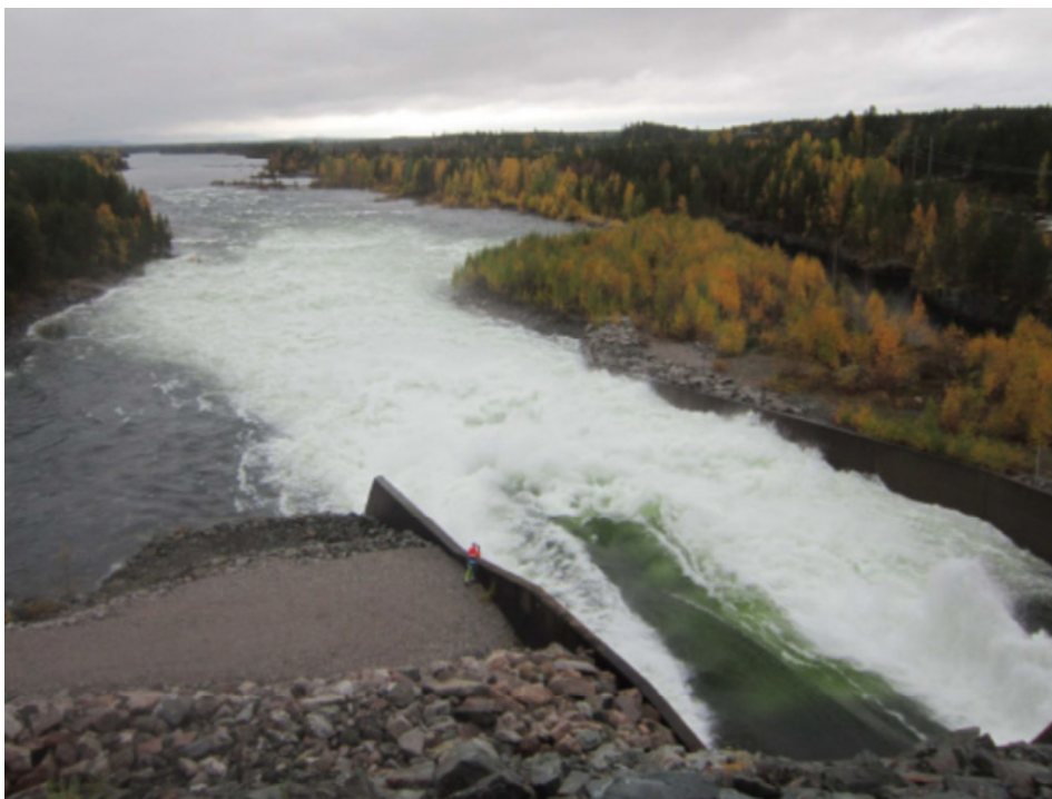
Figur 70: Provtappning i Grytfors vid inspektion 2013, vänster utskov. Källa: Skellefteå Kraft.
