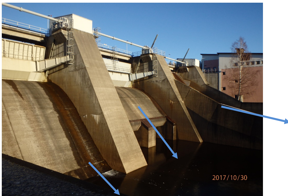
Figur 57: Utskovspartiet i Båtfors. Ungefärliga angreppsvinklar för vattnet, mot kanalen visas med blå pilar. Foto: Norconsult, 2017.
