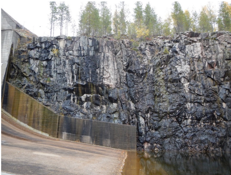
Figur 23 Detalj av vänster vägg. Notera sprickzonen, bergmassans oregelbundna karaktär, de flacka bankningsplanen mot bergets överyta.
