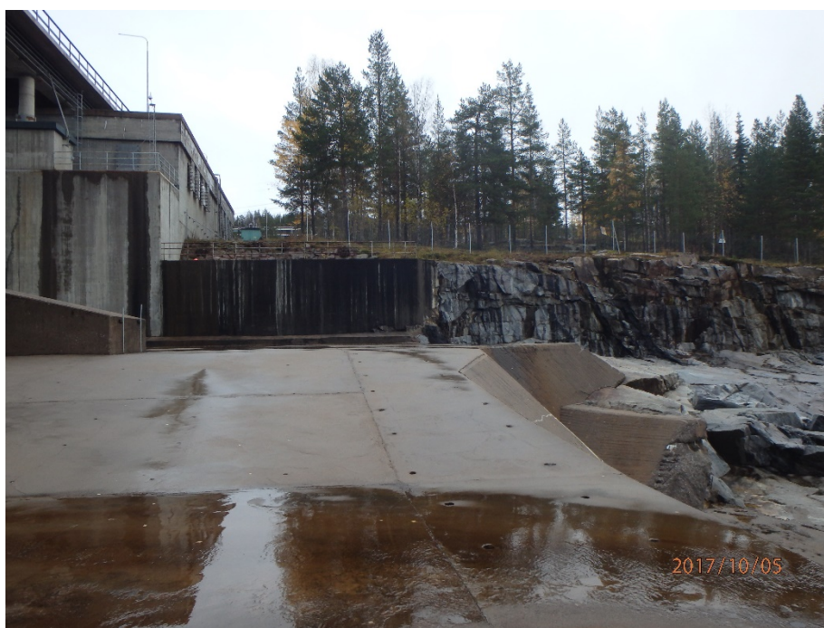
Figur 51: Ligga skibordsförlängning, foto från höger sida. Foto: Norconsult, 2107.
