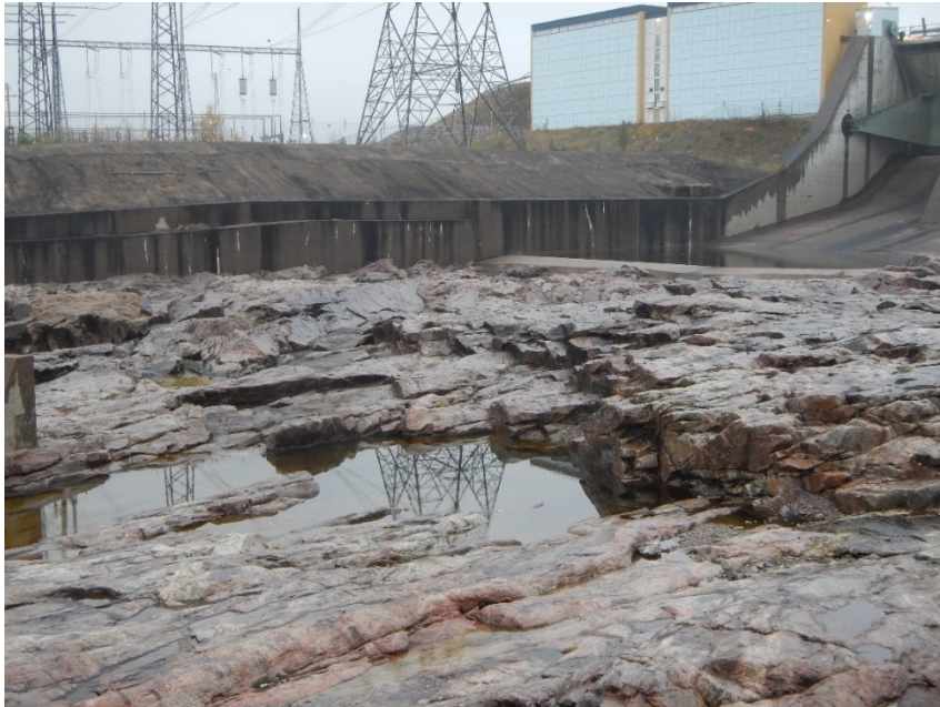
Figur 28 Porjus. Detalj av berggrunden nedströms utskovet. Notera de flacka tunna bankningsplanen och den storskaliga stängliga strukturen parallell med strömriktningen.
