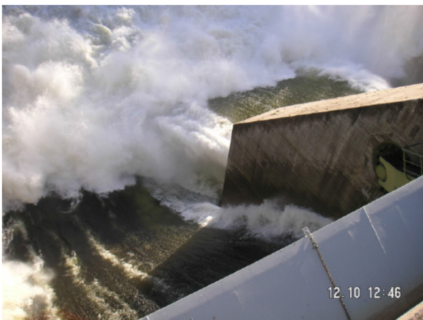
Figur 26: Provtappning i Messaure. Aktuell tappning är 1280 m 3 /s, jämfört mot maxavbördning 1790 m 3 /s vid DG. Källa: Vattenfall
