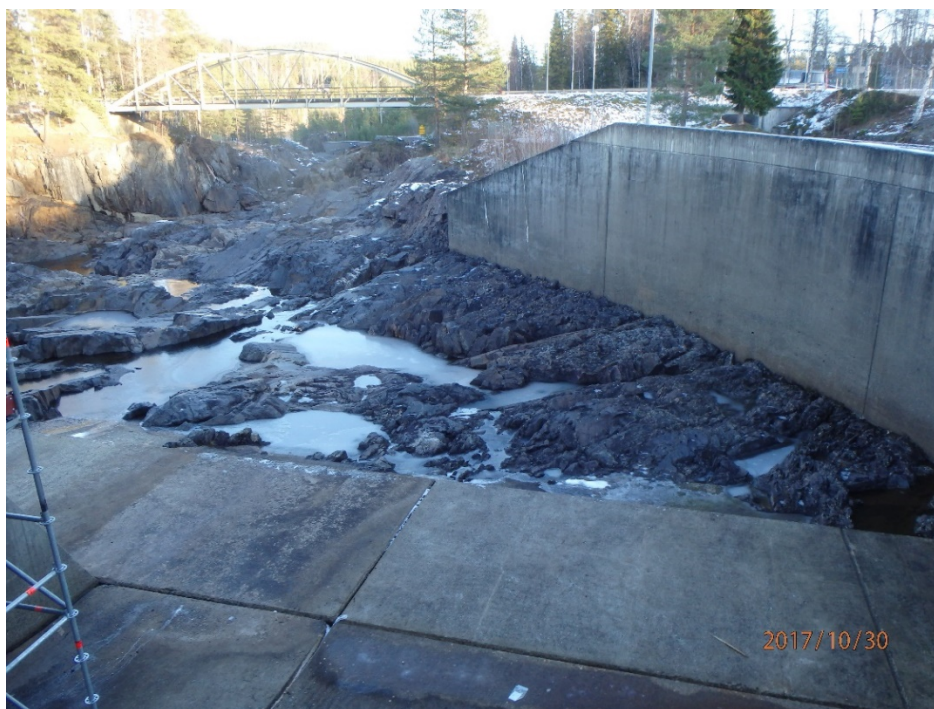
Figur 64: Utskovskanalen i Finnfors, området närmast nedströms höger utskov, med en kraftigt krökande ledmur. Foto: Norconsult, 2017.
