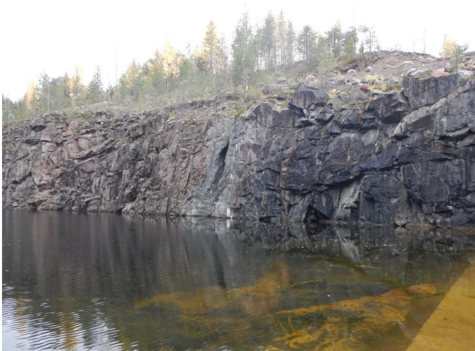
Figur 24 Messaure. Översikt över höger vägg. Notera sprickzonen med betonglagning. Den relativa avsaknaden av branta sprickor till höger om sprickzonen. Samt de flacka sprickorna.
