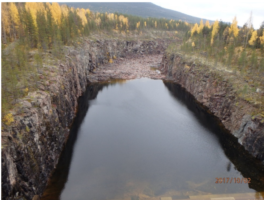
Figur 25: Utskovskanalen i Messaure, uppströmsdelen närmast utskoven. Utsprängd bassäng närmast. Foto: Norconsult, 2017.
