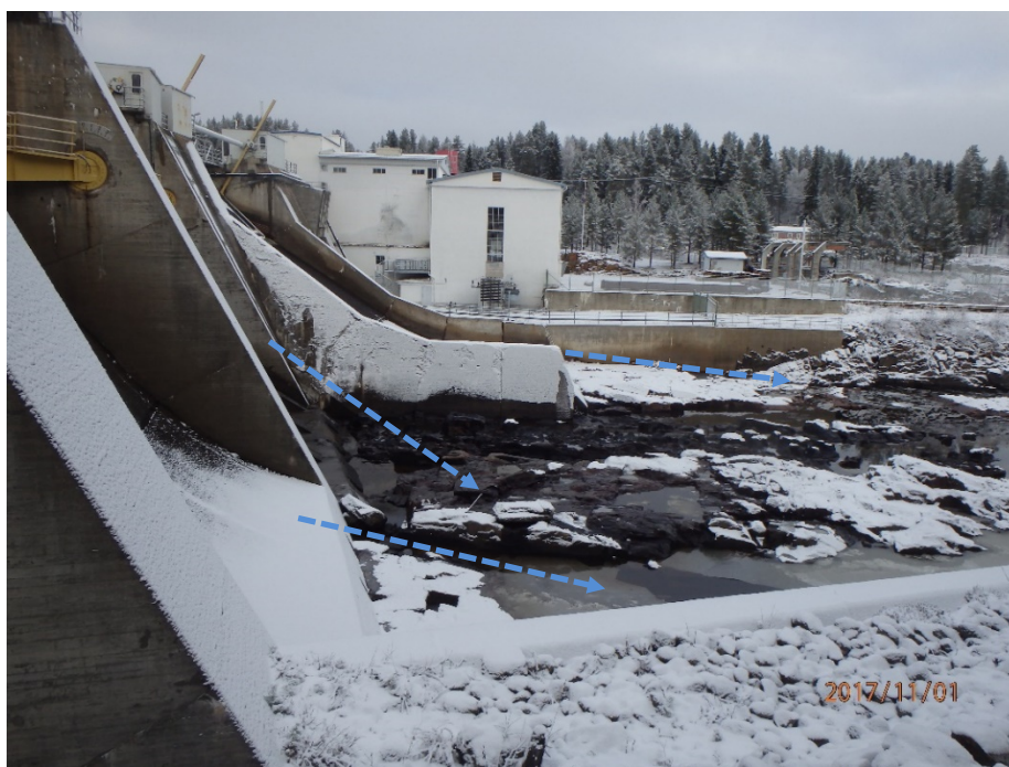
Figur 89: Selsfors utskovsparti, foto från höger strand nedströms. Blå pil visar angreppsvinkel för vattnet för mittenutskovet. Foto: Norconsult, 2017.
