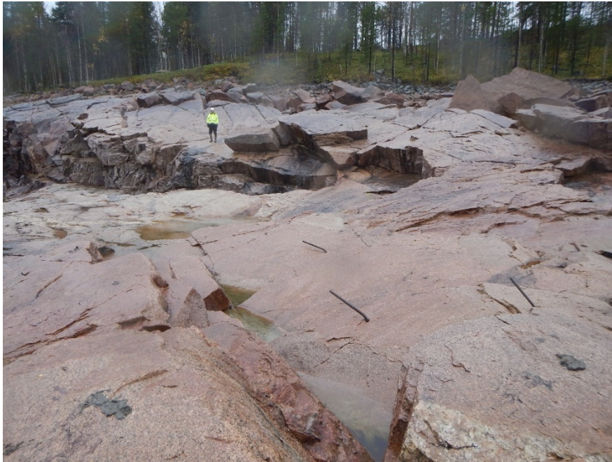
Figur 34 Harsprånget. Höger strandkant. Rektangulärt uppsprucken bergmassa samt bergförstärkning.
