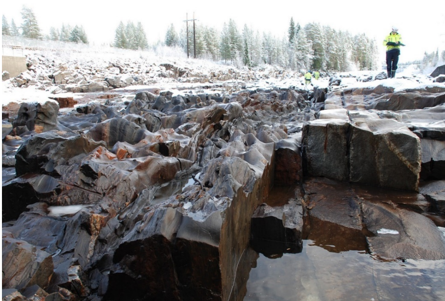
Figur 86 Selsfors. Detalj av berggrunden direkt nedströms mittenutskovet. Notera den mjuka karaktären hos de branta sprickytorna, bankningsplanen och jättegrytorna.
