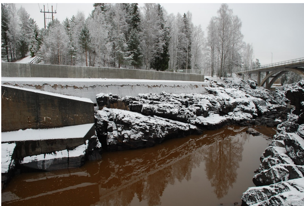
Figur 78 Krångfors. Översiktsbild över vänster sida av utskovsfåran för mittutskovet. Notera speciellt linsformerna som accentueras väl av snötäcket.
