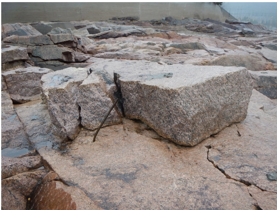
Figur 36 Harsprånget. Detalj över rektangulärt block samt bergförstärkning. Notera även vittringen på de bortslitna sidorna av blocket.
