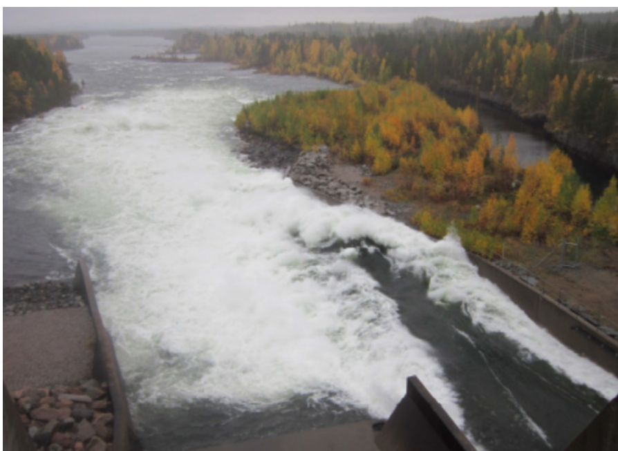
Figur 71: Provtappning i Grytfors vid inspektion 2013, höger utskov. Källa: Skellefteå Kraft.
