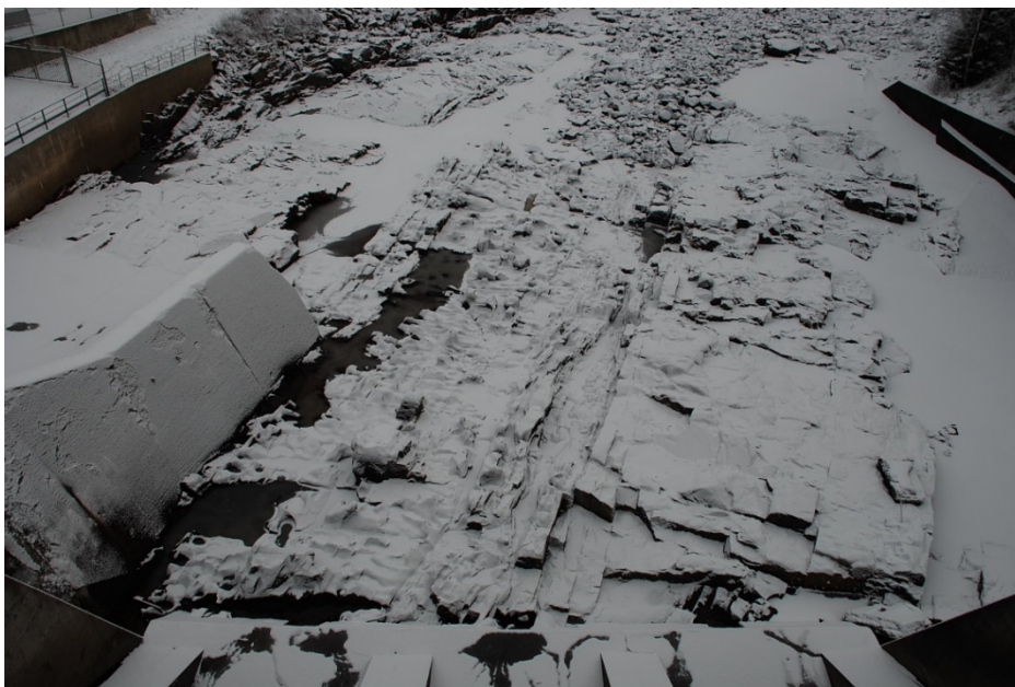
Figur 84 Selsfors. Berggrunden under snötäcke som accentuerar landformerna. Notera den långsträcka bandningen längs utskovskanalen nedströms mittenutskovet samt den storblockiga karaktären nedströms höger utskov.
