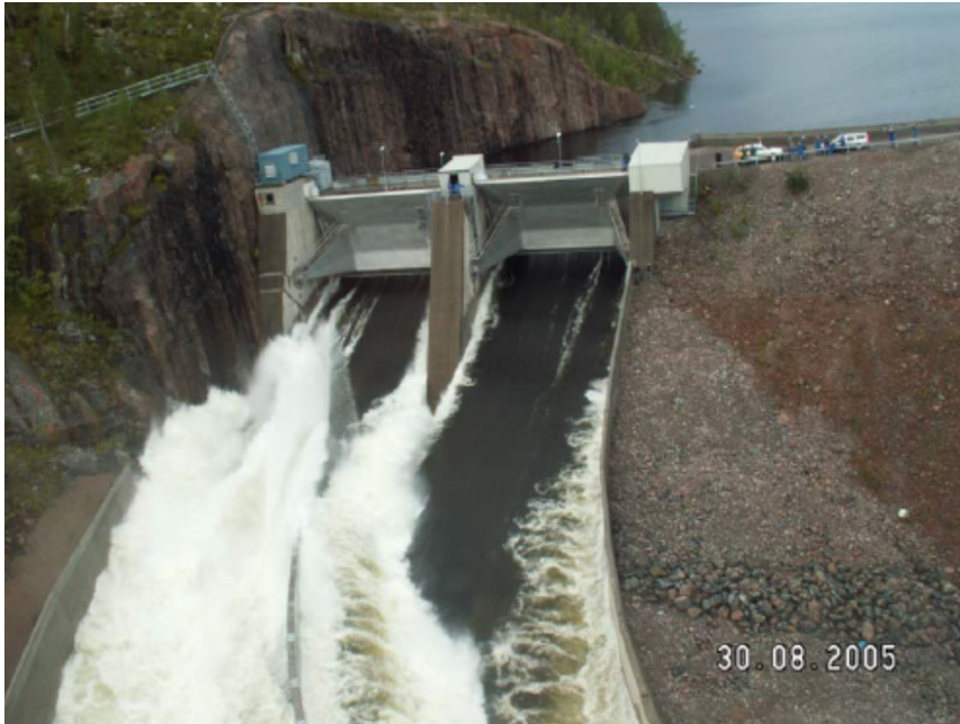
Figur 21: Provtappning i Letsi 2005, genom båda två utskoven, totalt 1045 m 3 /s. Notera uppspolningen längs de högra ledmurarna (t.v. i bild). Foto: WSP (2005).
