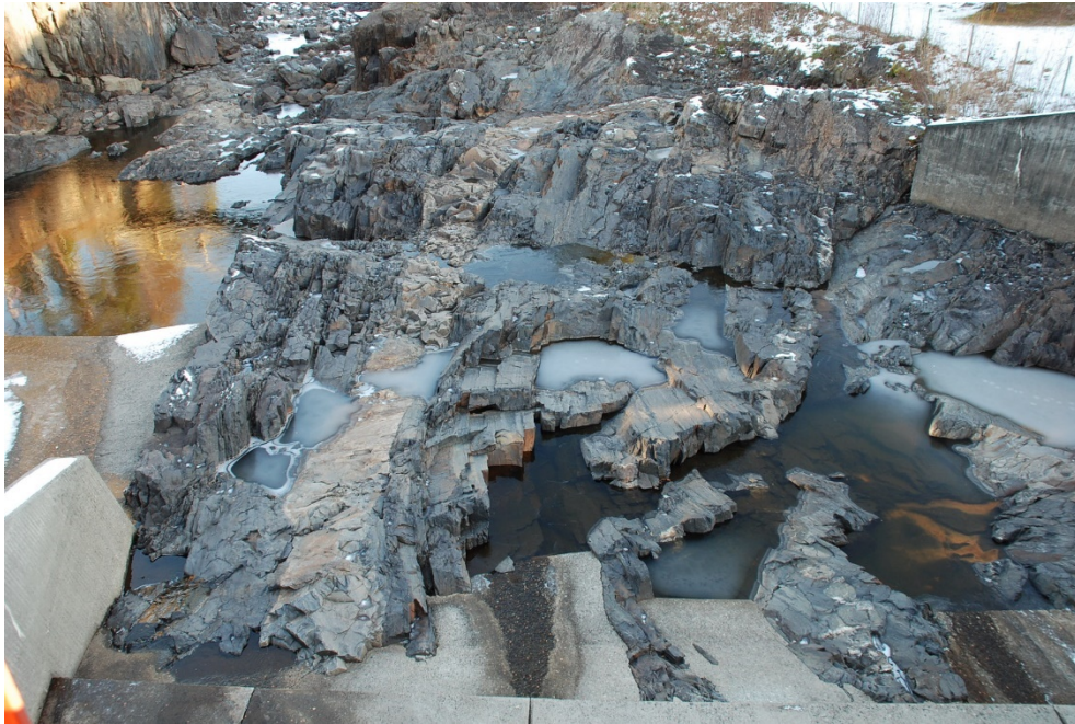
Figur 60 Finnfors. Översikt från vänster utskov. Notera planfoliationen hos bergarten samt det ljusa bandet.
