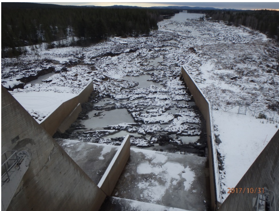
Figur 69: Grytfors utskovskanal. Höger ledmur kröker åt vänster. Foto: Norconsult, 2017.
