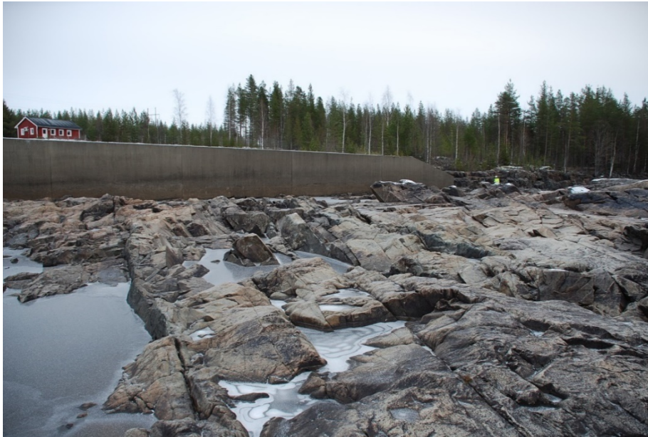
Figur 73 Rengård. Notera den dominerande strukturen tvärs kanalen samt lokalt försvunna block (avslöjas av isspeglarna)
