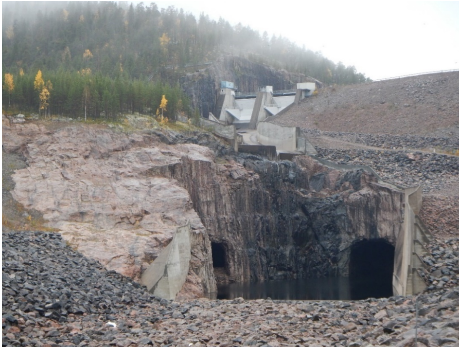
Figur 18 Letsi. Översiktsbild över utskov och lägre energiomvandlarbassäng.
