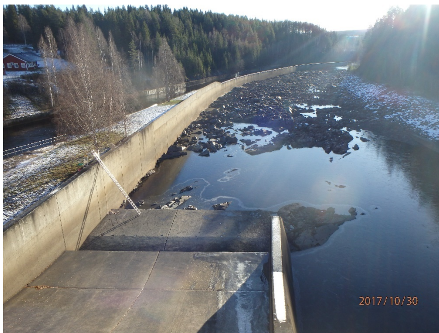
Figur 56: Båtfors utskovskanal, foto från dammen, vid vänster utskov. Kanalen är först rak och kröker sedan åt höger. Vattenspiegel uppstår i uppströmsdelen p.g.a. högre nivåer ca 20 m nedströms. Foto: Norconsult (2017).
