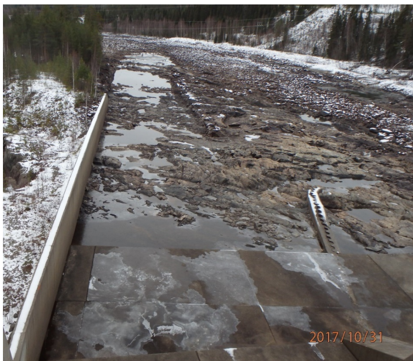
Figur 75: Utskovskanalen i Rengård, foto från vänster utskov. Foto: Norconsult, 2017.
