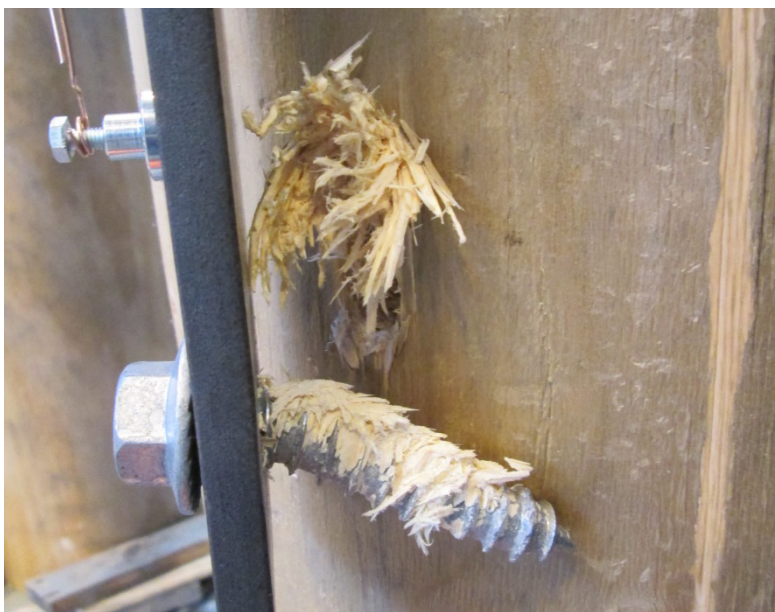
Figur 35: Utfall av provning - utdragen skruv med lokal skada på stolpen.
