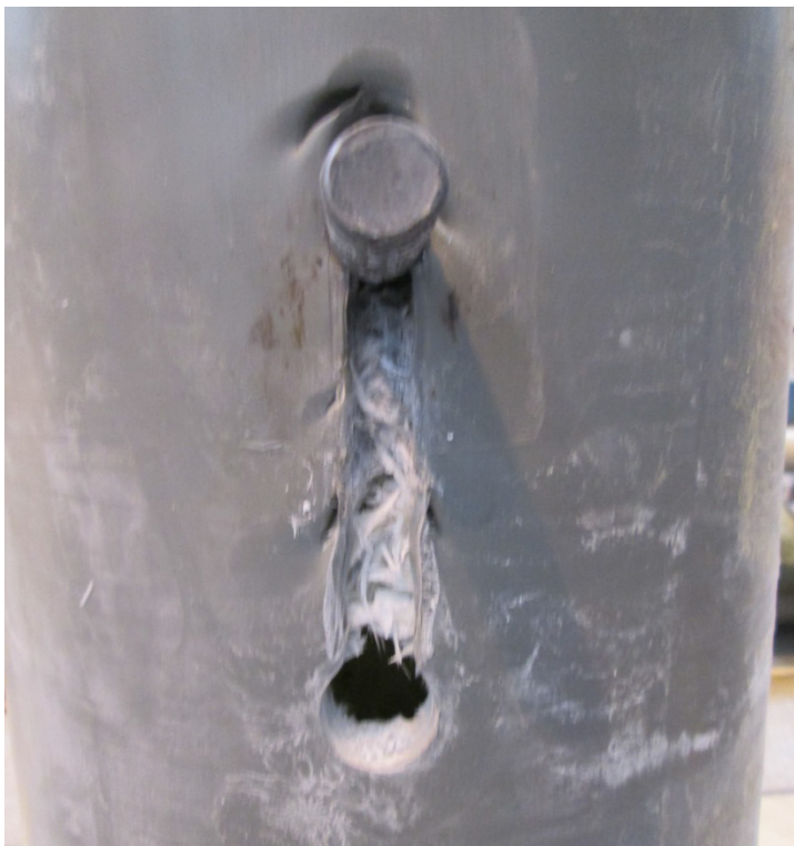
Figur 25: Utfall av provning - pinnbulten skär igenom stolpen.
