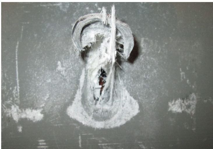
Figur 57: Utfall av provning - utdragning av skruv med tillhörande lokal skada på stolpen.
