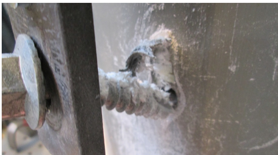
Figur 33: Utfall av provning - utdragen skruv med tillhörande lokal skada på stolpen.
