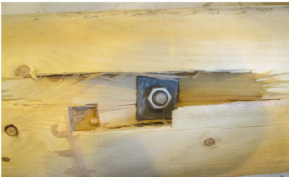
Figur 11: Utfall av provning - stansning samt lokal krossning av stolpe.
