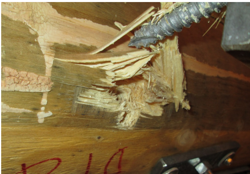
Figur 59: Utfall av provning - utdragning av skruv samt lokal skada.
