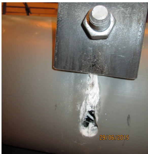
Figur 49: Utfall av provning - pinnbulten skär igenom stolpens gods.
