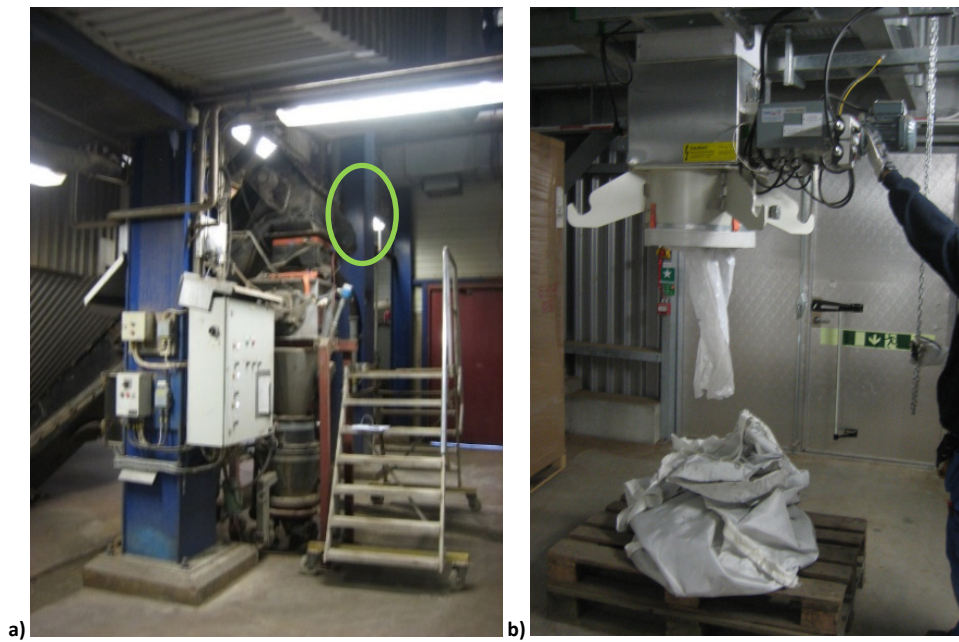
Figur 51. Provtagningspunkter för a) aska andra draget, b) spärrfilteraska.
