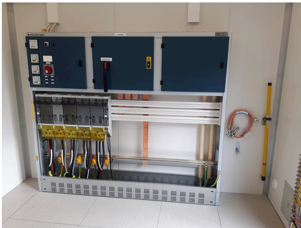
Figur 8. Fotografi av aktuell nätstation
