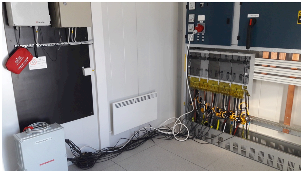
Figur 9. Fotografi av aktuell nätstation med mätning applicerad
