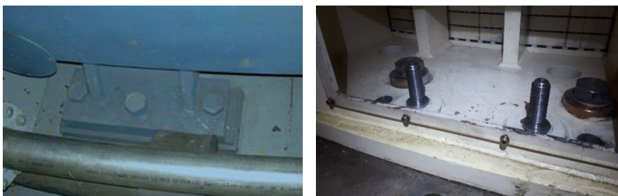
Figur 10 - Fast statorfot. Ger större radiella krafter pga termisk utvidgning
