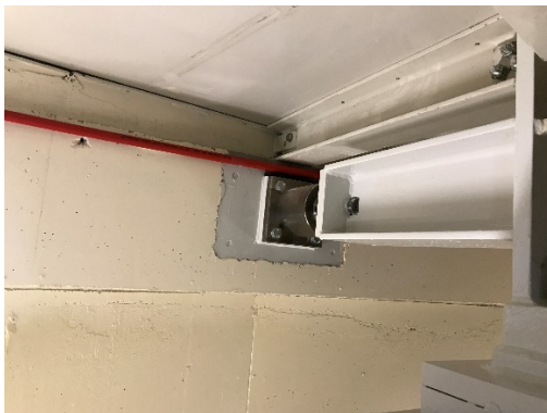
Figur 14 - Fast och dämpad ger låga radiella krafter och dämpning av vibrationer
