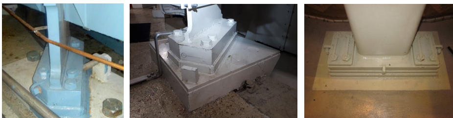
Figur 11 – Fast men flexande statorfot (första två bilder till vänster visar en oblik pelare)
