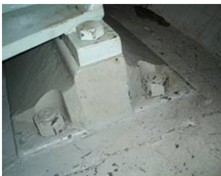
Figur 16 - Fast - ger stora radiella krafter från termisk utvidgning
