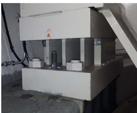
Figur 17 - Fast men flexibel i radiell led som ger lägre laster på grund av termisk utvidgning.
