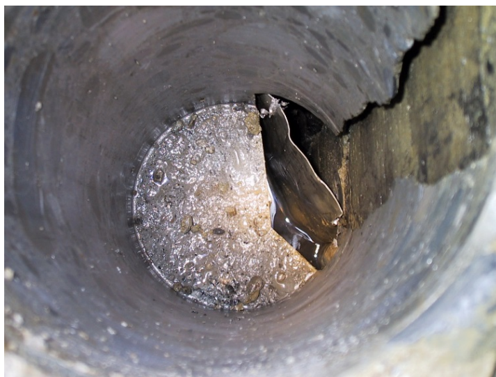
Figur 6 – 15 Plan över framborrat bleck i anslutning. Borrning har utförts i betongskärm. Sidopelaren syns till höger i bild. Blecket är i princip helt utnyttjat och utsträckt. Anslutningspunkten där blecket är ingjutet i sidopelarens syns till höger. Magasinets vattenyta syns mot blecket nederst i bild.
