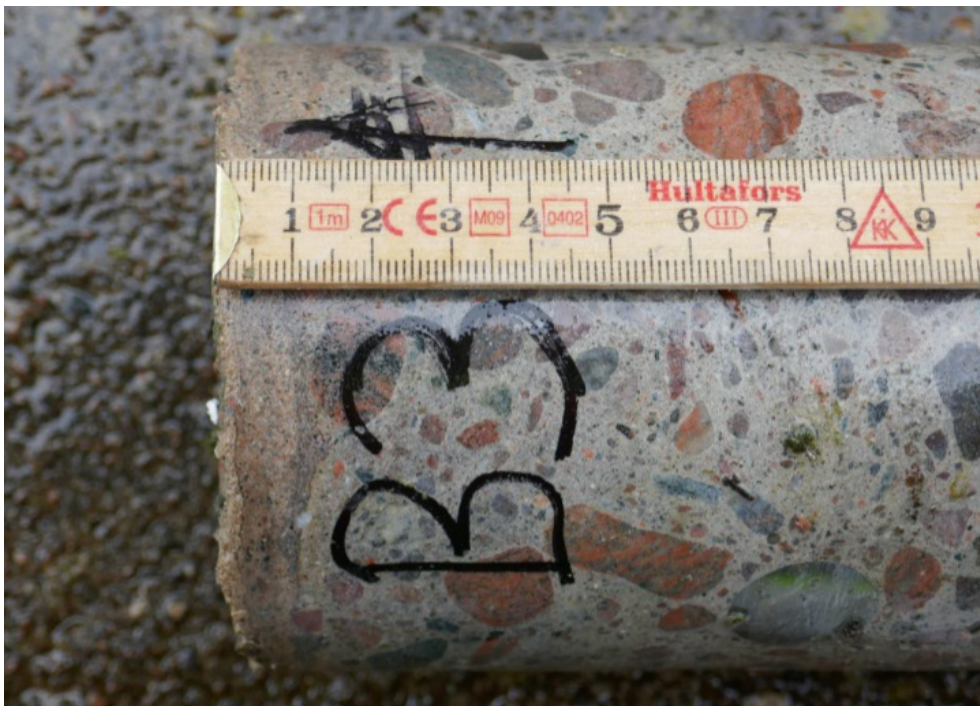
Figur 13. Sprutbetonglagningens tjocklek var i medeltal 10 mm med enstaka djupare partier.
