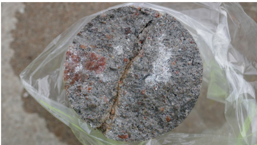
Figur 23. Betongkärnans brottyta nedtill som visar sprickans utseende i underliggande konstruktionsbetong.
