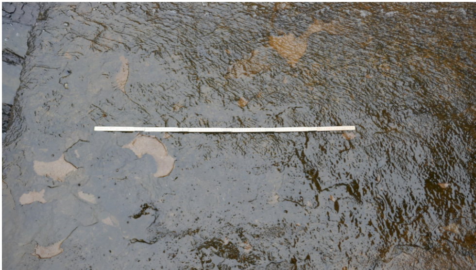
Figur 10. Skibord A vid kraftverk 1. Mindre släppor i Densit-lagningen. 1 m tumstock som referens.
