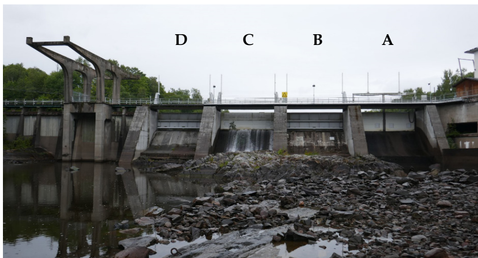
Figur 1. Nedströmsvy över utskovspartiet i regleringsdammen vid kraftverk 1. I denna rapport benämns de fyra utskoven A, B, C och D med A närmast kraftverket och D närmast timmertraversen.
