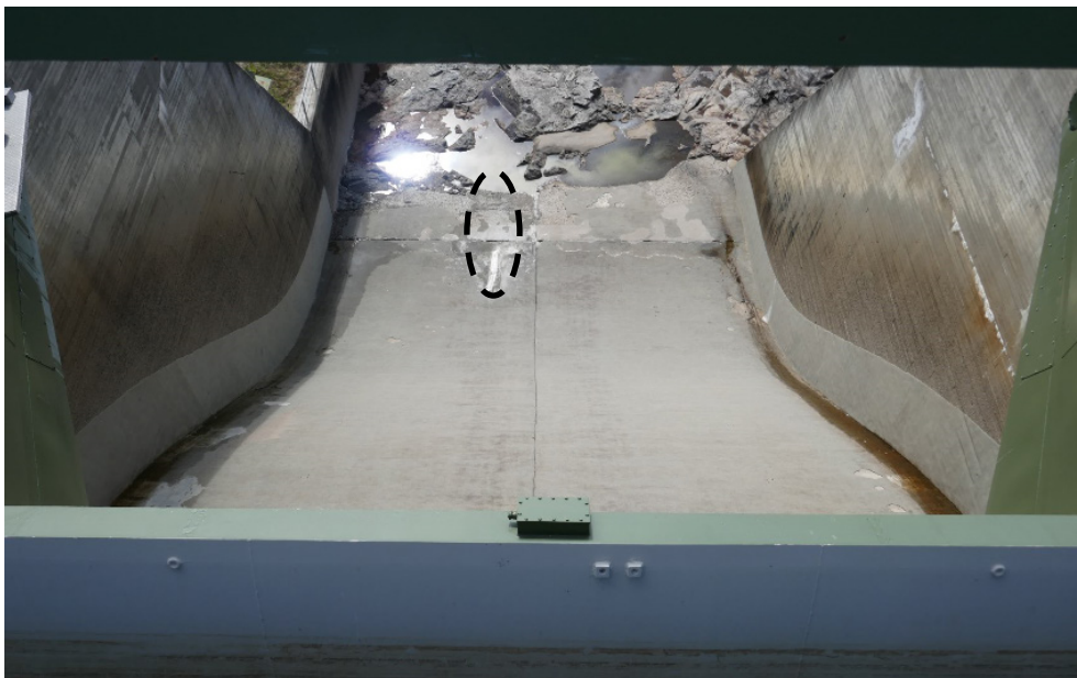
Figur 8. Plats för utborrning av sex betongkärnor från den nedre delen av skibord C vid kraftverk 3.
