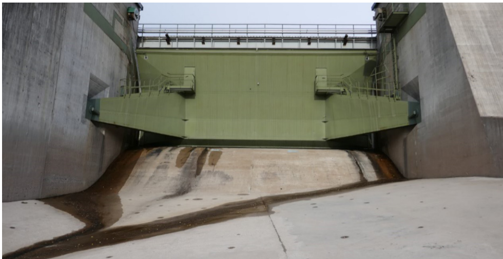
Figur 15. Nedströmsvy över skibord A vid kraftverk 2. Längsgående gjutfog syns mitt i bilden.
