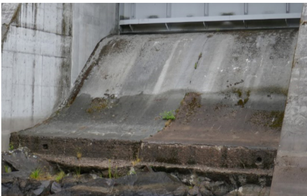
Figur 14. Nedströmsvy över skibord D vid kraftverk 1. Skibordet har lagats med sprutbetong.
