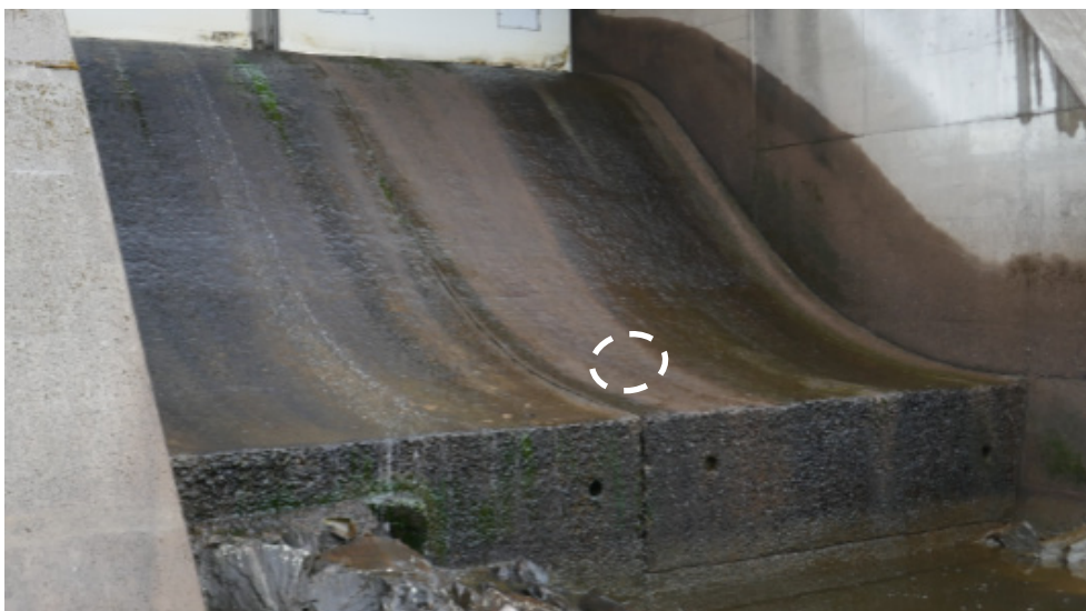
Figur 9. Nedströmsvy över skibord A vid kraftverk 1. Skibordet har reparerats med Densit-bruk. Området inom vilket betongkärnorna borrades ut är markerat av en ring.
