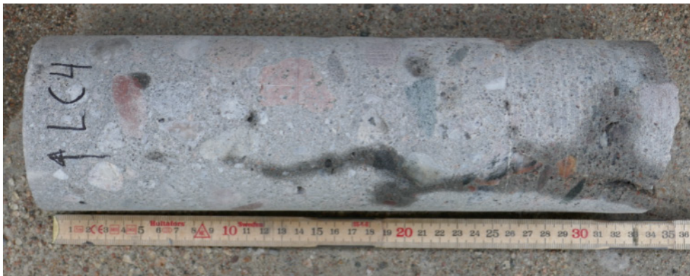
Figur 22. Längsgående spricka i betongkärnan markeras av det mörka stråket som uppkommer till följd av att det tar längre tid för vattnet att torka ut från sprickan än från kärnans mantel.
