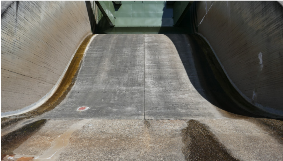
Figur 25. Nedströmsvy över skibord B vid kraftverk 3. Skibordet har lagats med Chesterton-bruk utmed kanterna mot pelarväggarna. Längsgående rörelsefog syns mitt i bilden.
