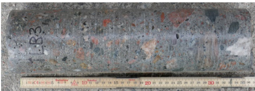
Figur 18. Betongkärna där övergång mellan pågjutning och konstruktionsbetong kan skimras vid 190 mm djup.
