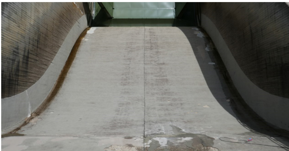
Figur 28. Nedströmsvy över skibord C vid kraftverk 3. Skibordet har lagats med Chesterton-bruk utmed hela dess längd och bredd. Uppkomna släppor i lagningen har fyllts i med nytt bruk (ljusa områden i bilden).
