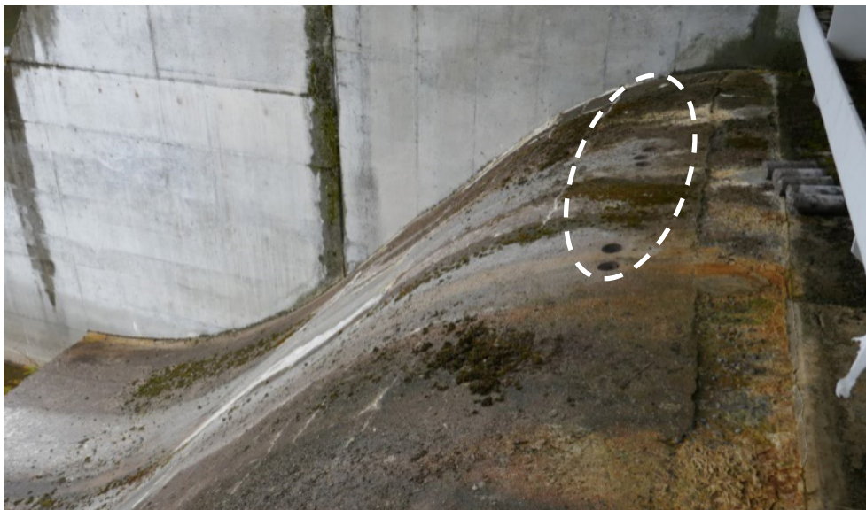
Figur 5. Plats för utborrning av betongkärnor från den övre delen av skibord B vid kraftverk 1.
