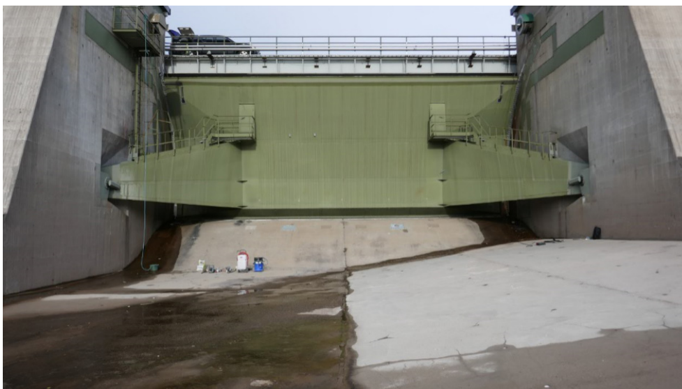
Figur 17. Nedströmsvy över skibord B vid kraftverk 2. Tre längsgående gjutfogar finns i skibordet.
