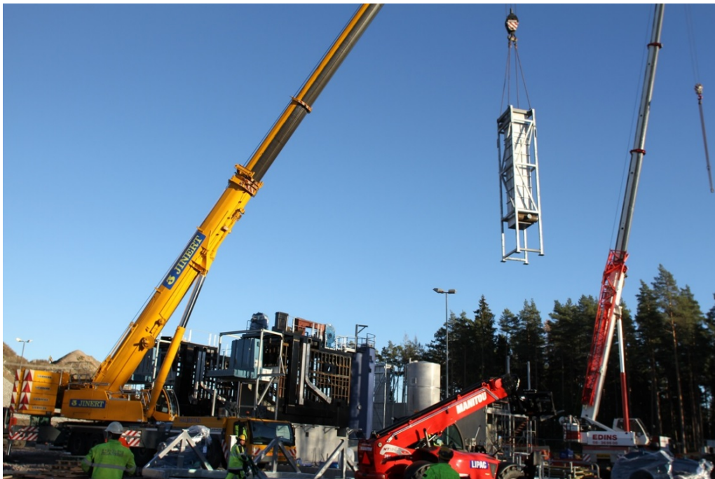
Figur 7 Täby Fjärrvärmeverk under uppförande i Arninge (Källa: Nyhetsbild från Jernforsen Energi)
