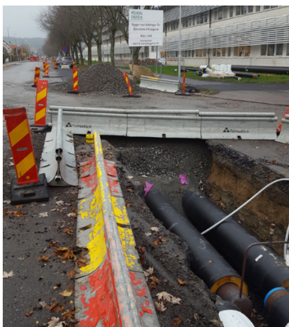
Figur 5. Schaktgropen vid Frejagatan med två enkelrör där fältförsöket utfördes på det ena röret. Den aktuella raksträckan där röret går 528m bort i djupet på fotot.
