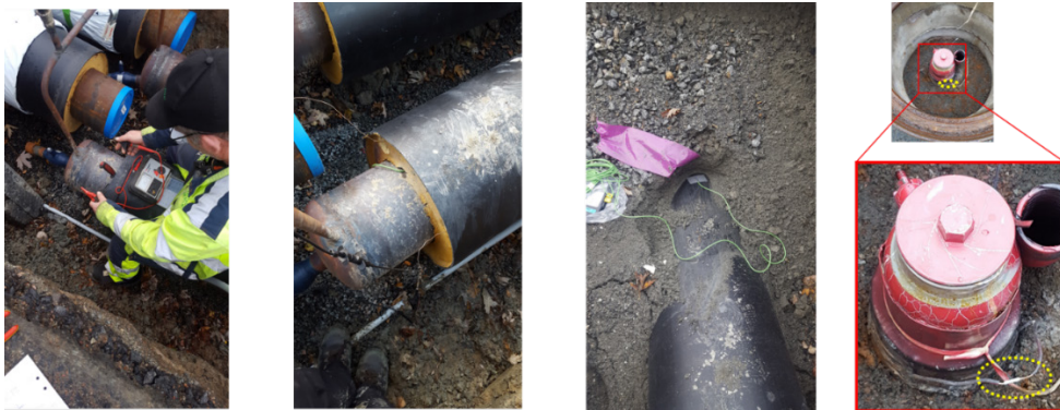
Figur 6. Från vänster sett visar foto 1 mätning av slingresistans, foto 2 visar sammankoppling av multimeter med koppartråd samt hur det ena TE är instuckat under isoleringen, foto 3 visar TE som tejpsats fast på manterröret innan fyllnadsmassor lades tillbaka och foto 4 visar med gul streckad cirkel att koppartrådarna har sammankopplats i ena änden av röret.
