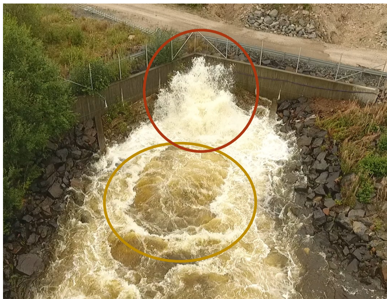
Figur 6. Bild av utloppet vid flöde på 25 m 3 /s där luftpulsationerna kastas upp överst i bilden, se röd markering, medan den dominerande utströmningen av vatten sker i förgrunden, se gul markering i bild.
