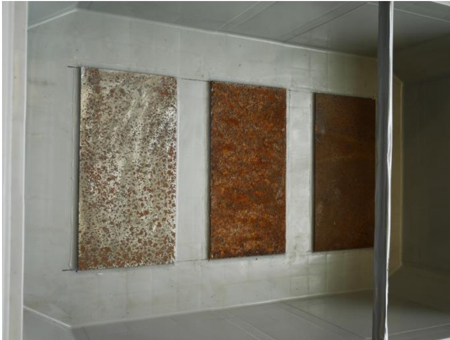
Figur 16. De tre fastlimmade stålplåtarna med olika nivå på rostangrepp. Skalarost i mitten. Plåtarna är tillskurna med sand/vattenskärning.
