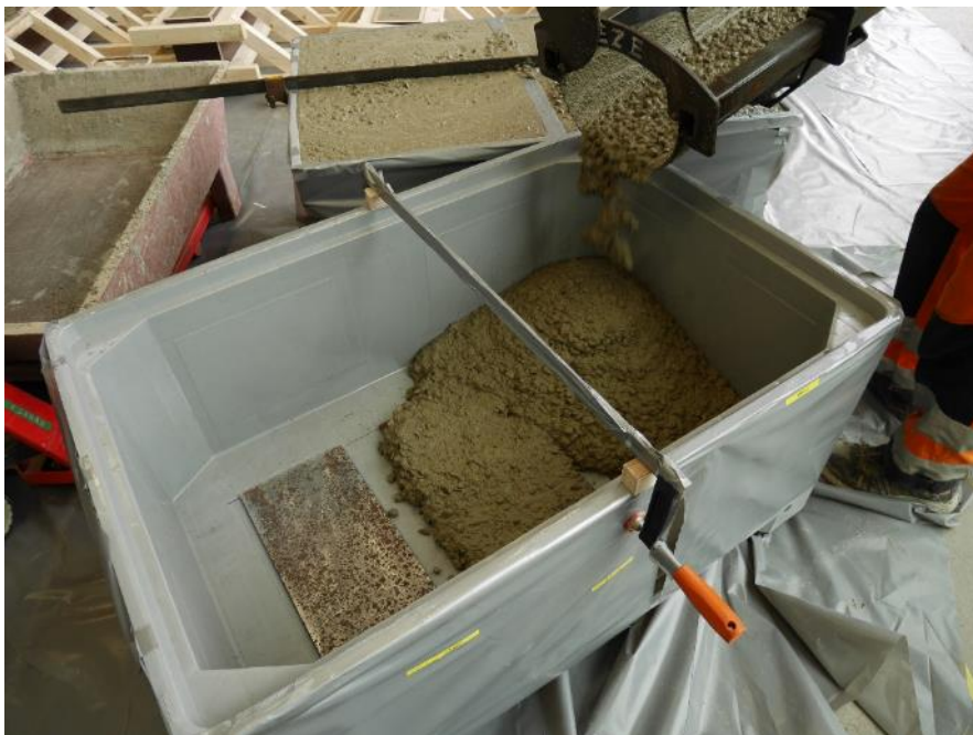
Figur 17. Betongen fylls i plastkaret från en betongbil. Limfogarna håller plåtskivorna på plats under gjutningen. All betong har vibrerats när formarna fyllts och ytan jämnats till på konventionellt sätt. Därefter har den slipats med diamantskiva.
