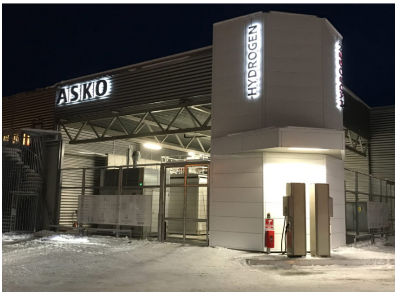
Figur 5: Tankstationen med bakomliggande kompressorer m m
