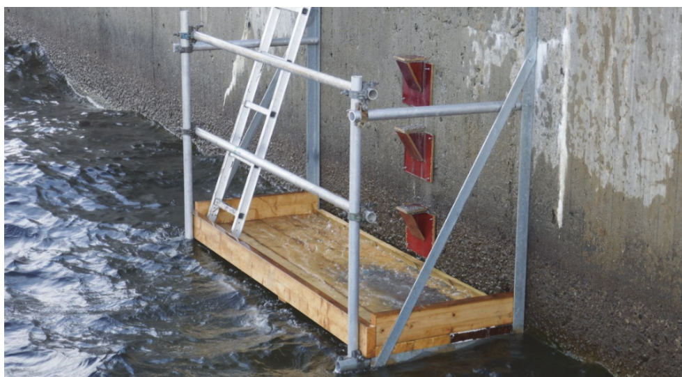
Figur 11. Borrhålen gjöts igen med reparationsbetong. Formar monterades för att hålla bruket på plats i hålen.
