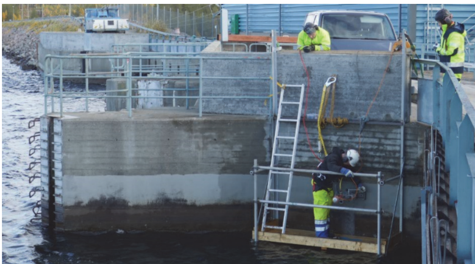
Figur 8. Borrhning utfördes från en provisorisk arbetsställning som flyttades mellan provtagningsplatserna.
