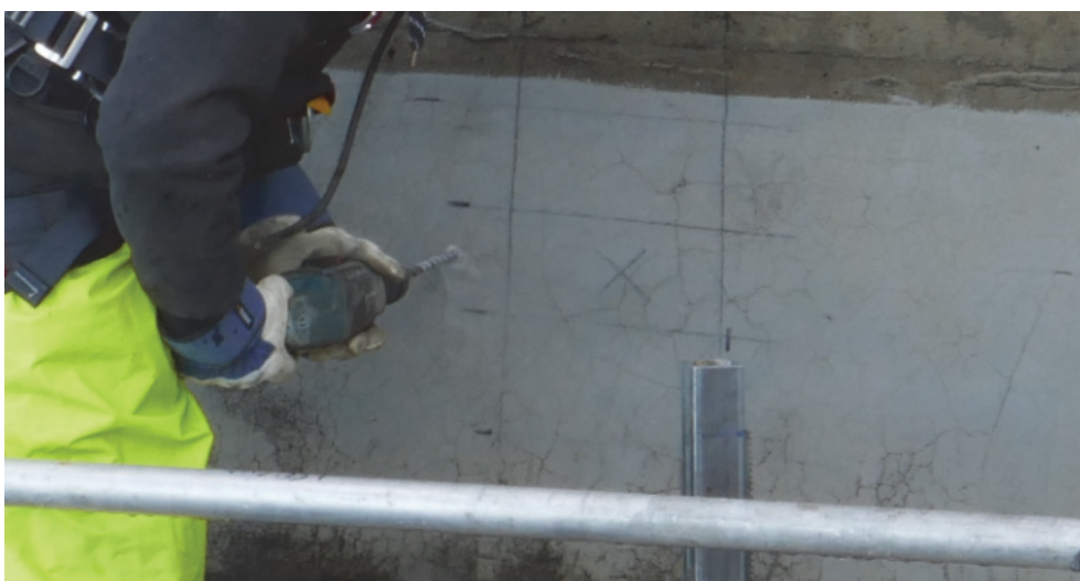
Figur 9. Läget för en betongkärna (X) anpassades så att den borrades ut mellan förekommande armeringsjärn.
