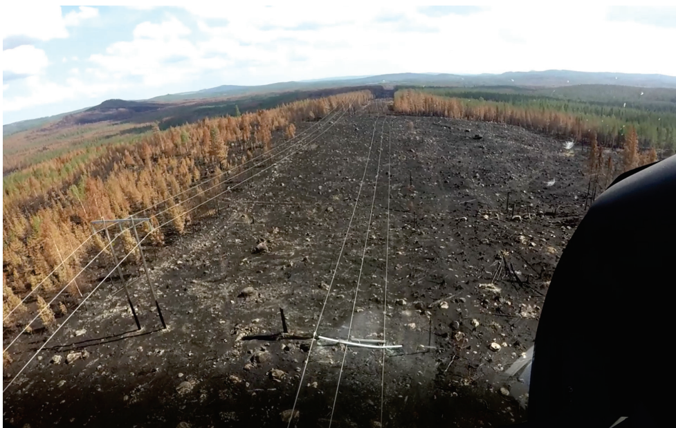
Figur 5: Cirka 80 av Ellevios stolpplatser skadades i branden mellan Laforsen och Kårböle. Foto: Ellevio.
