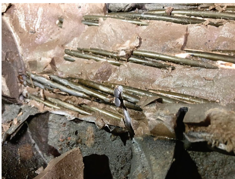
Figur 12 Skadade linor i samband med sömborring. Askurna trådar är synliga i bilden.
