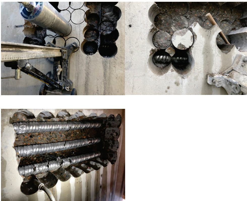
Figur 9 Sömborring med efterföljande vattenbilning.
