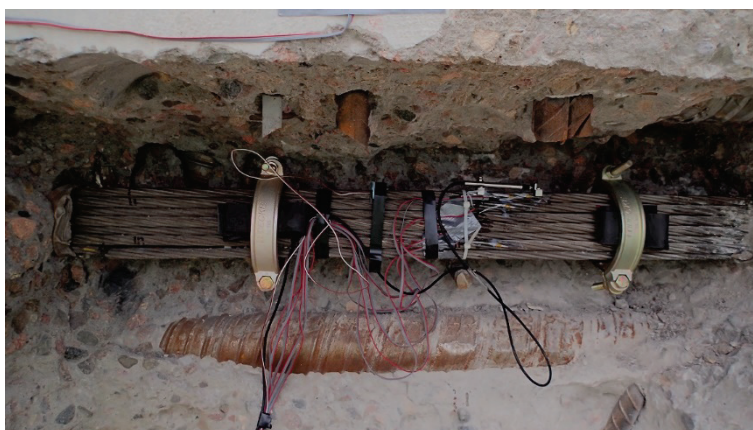
Figur 20 Fixering av linor i provningsställe III.
