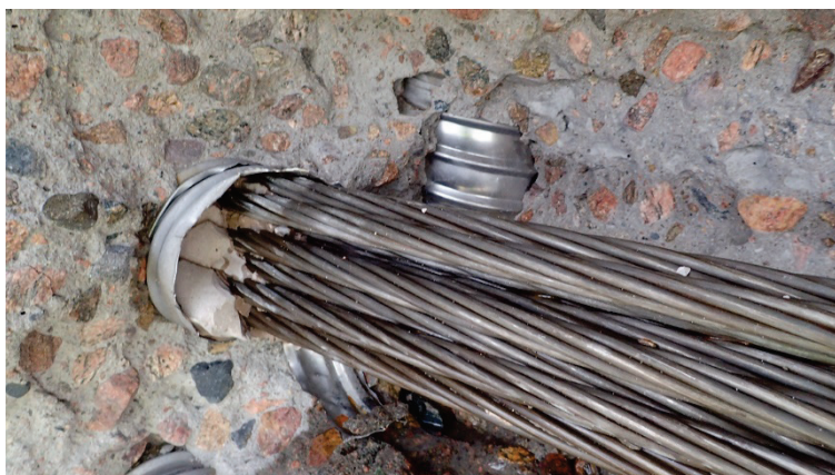
Figur 17 Horisontella linor och ett vertikalt foderrör.
