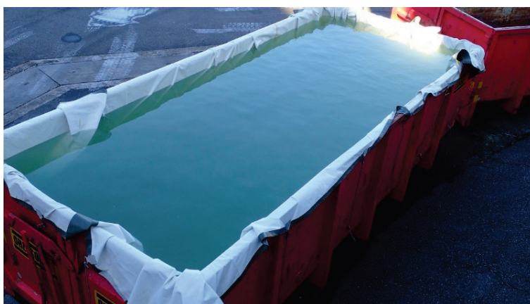
b) En container med vatten efter vattenbilning
