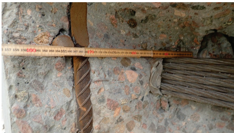
Figur 16 Avstånd mellan foderröret (linorna) och betongväggens utsida.
