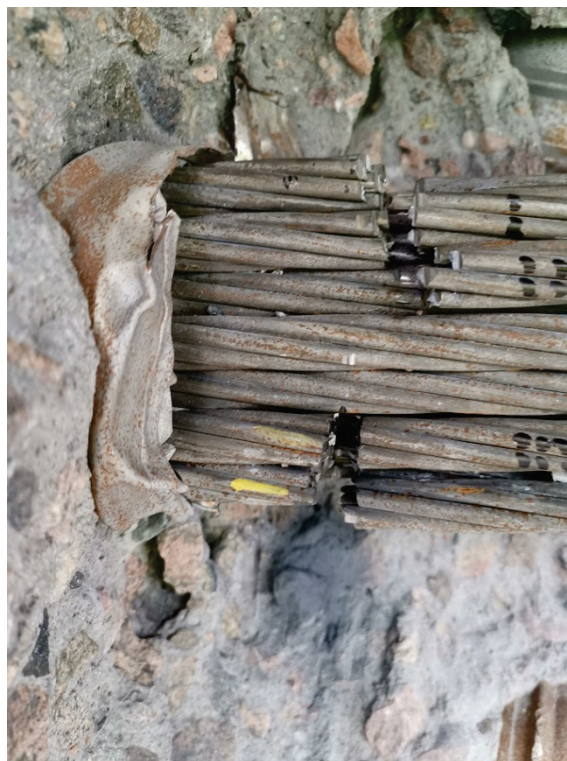
Figur 22 Kapning av linor med vinkelslip.
