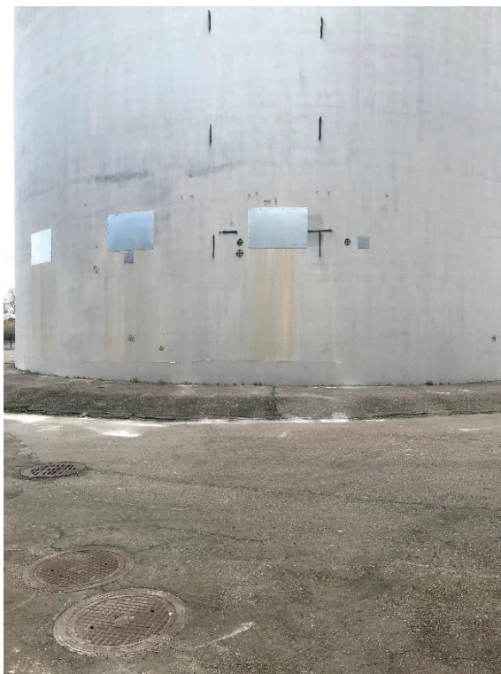
Figur 14 Efter avslutat arbete täcktes de vattenbilade hålen med rostfri plåt.
