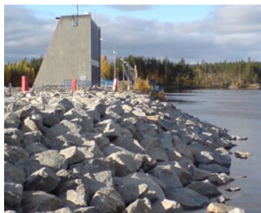
Figur 76. Nedströms stödbank som ur utrymmessynpunkt försetts med stöd av en vingmur för att ge motsvarande bredd vid anslutningen som längs övriga dammen. Den högra bilden visar uppströms erosionsskydd, som förutom att ge skydd mot vågor ger ökad bredd på dammkrönet.
