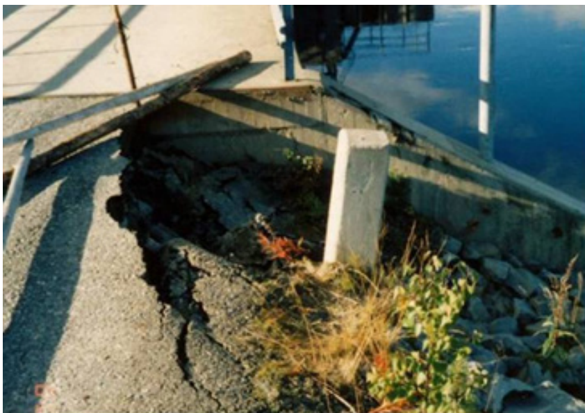
Figur 64. Sjunkgrop vänster fyllningsdamm 1985.
