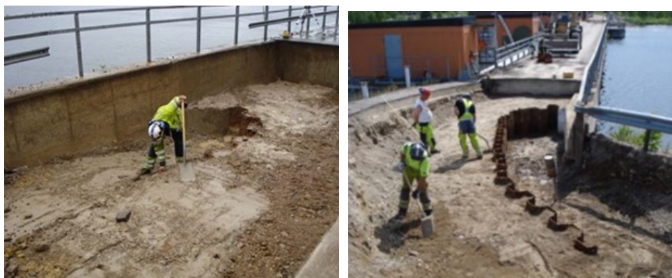
Figur 60. Framschaktade anslutningar 2007. Dåligt med utrymme på uppströmssidan av sponten i vänster anslutning för packning.
