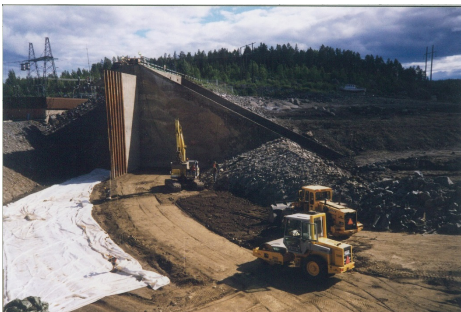
Figur 8. Bilder från utgrävning av Lövödammen. I bildens övre vänstra hörn syns en spontkonstruktion som löpt in i tätjorden (Foto av Carl-Oscar Nilsson)
