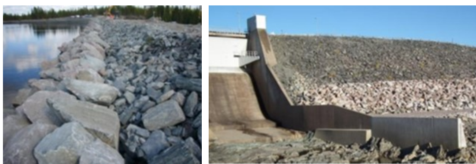
Figur 84. Nytt erosionsskydd med övergångslager på dammens uppströmssida och till höger ny stödbank på dammens nedströmssida.
