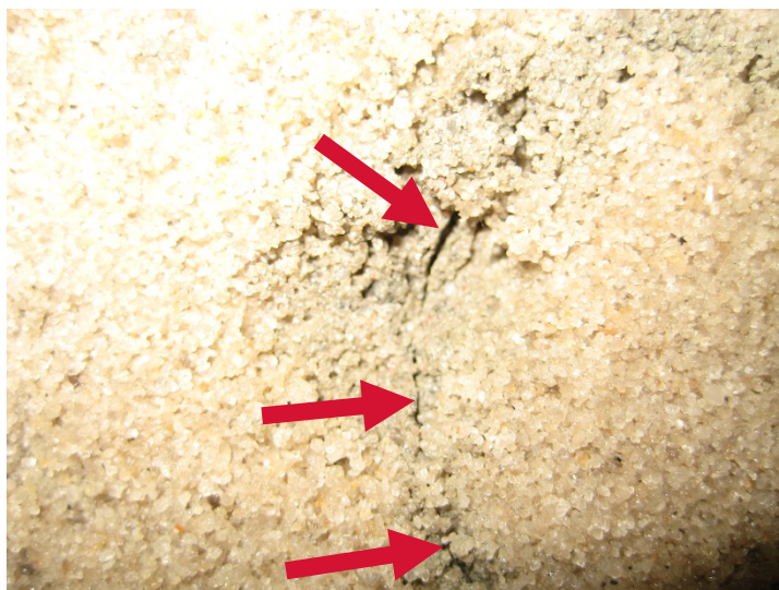
Figur 27. Framgrävt prov efter injekteringsförsök. Injektering av ett sandcementbruk i en skadad tätjord. Skadan var cirkulär och anslöt mot nedströmsfiltret. Den sand som syns i bild kommer från nedströmsfiltret och har fastnat mot tätjordsytan. Sprickan mellan injekteringsbruket och tätjorden gick runt hela skadan och markeras med röda pilar mitt i bilden.
