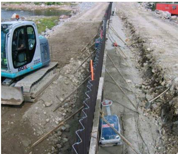
Figur 9. PVC-spont för höjning av tåtkärnan (Nilsson 2016).
