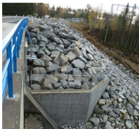
Figur 76. Nedströms stödbank som ur utrymmessynpunkt försetts med stöd av en vingmur för att ge motsvarande bredd vid anslutningen som längs övriga dammen. Den högra bilden visar uppströms erosionsskydd, som förutom att ge skydd mot vågor ger ökad bredd på dammkrönet.
