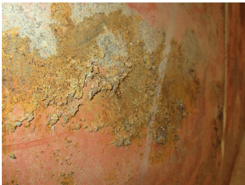
Figur 25. Reaktion mellan tätjord och stål som upptäcktes efter ett dammbrottsförsök. Den glatta stålytan fick på flertalet ställen utskjutande delar av grusmaterial som rev upp närliggande tätjord vid lastförändringar.
