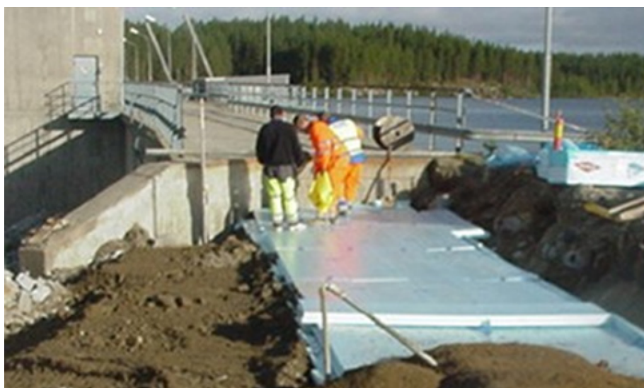
Figur 75. Isolering över tätkärnan.
