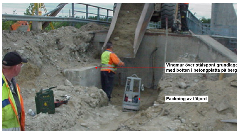
Figur 74. Höjning av tätkärna intill vingmur (vänster bild) och isolering över tätkärna vid övergång till betongkonstruktion (höger bild).
