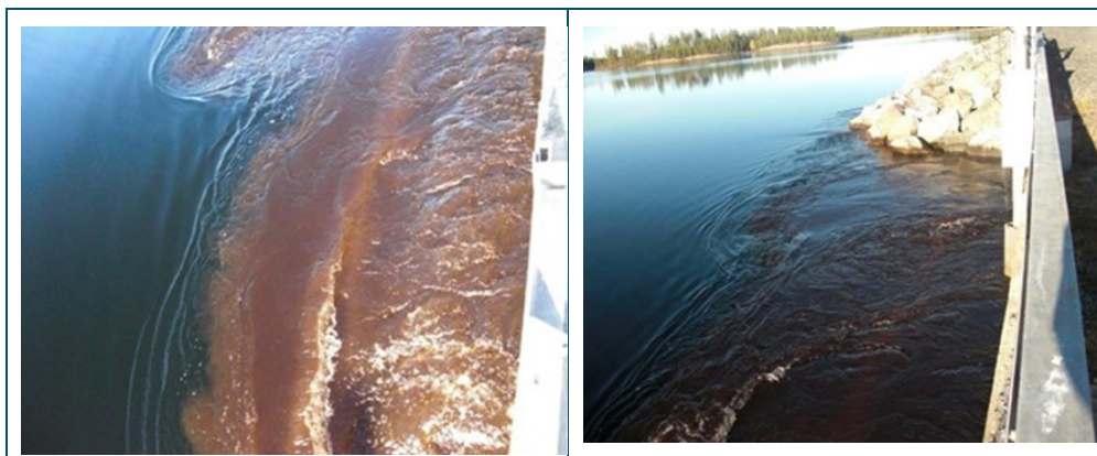
Figur 82. Grumling i vänster anslutning vid spill genom utskov 2010.
