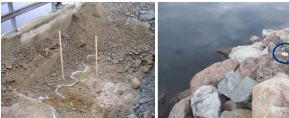
Figur 85. Spont framschaktad i vänster anslutning 2005 vid höjning av dammkrönet, samt dubb i uppströmsslänt.
