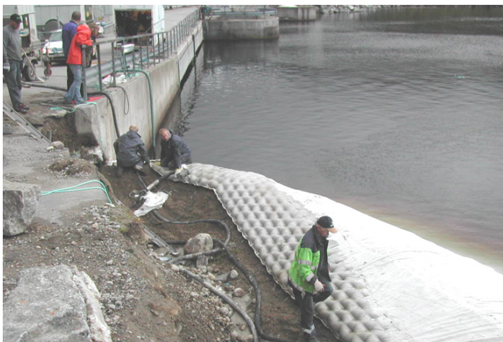
Figur 42. Utläggning av betongmadrass i området för vänster anslutning.
