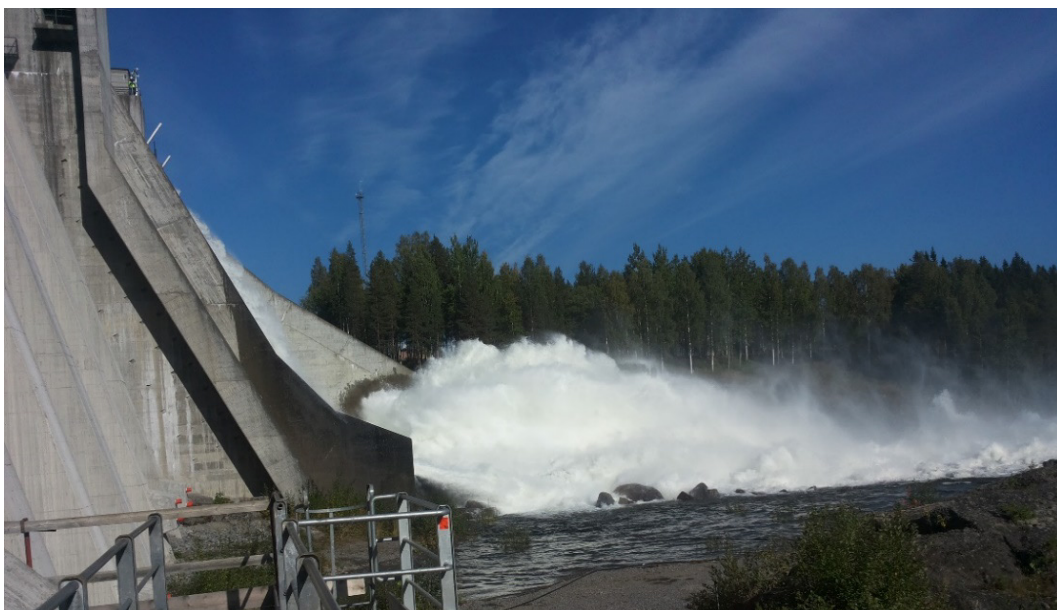
Figur 3.4 Fotografi från spillvattentappning ur center utskov vid samma kraftverk som på föregående foto år 2015 innan ombyggnationen av spillfåran, sidovy från höger. Den berghäll som höjde sig ovanför vattenmassornas flödeslinje agerar som stötblock och orsakar därefter turbulens i flödet då vattenkaskaderna rytmiskt slår ned på bergytan nedströms.
