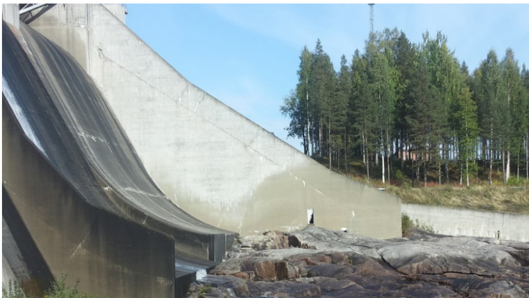
Figur 3.3 Bild över spillfåra vid ett kraftverk i Norrland år 2014 innan ombyggnation av densamma. Direkt nedströms center skibords tå finns en berghäll som höjer sig ovan skibordstån. En dörröppning är placerad vid högsta punkten. Berghällen agerar som stötblock vid spillvattentappning. Notera även det enorma block som ligger, till synes löst något längre nedströms.
