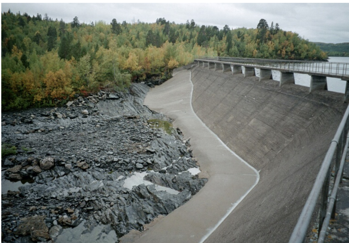
Figur 2.2 Pågjutning av dammtå på en betongdamm (översfallsdamm) i Norge (Källa: Norconsult AS).
