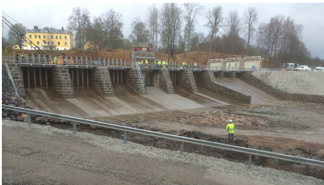
Figur 3.7 Under år 2016 färdigställd renoverad spillfåra med låga stötblock vid skibordstån vid ett kraftverk i Mellansverige.
