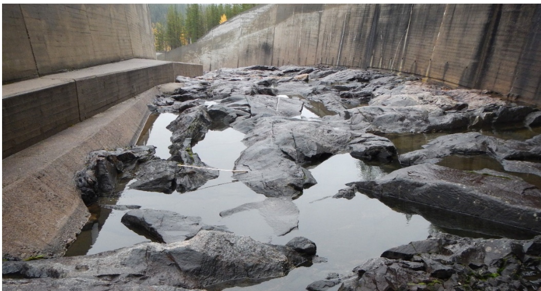
Figur 3.1 Bild över spillfåra vid ett kraftverk i norra Norrland, se rapport 2018:532. Notera att block i bergmassan ställvis fungerar som stötblock gentemot det framstörtande vattnet. Där stor turbulens skapas kommer nedströms bergyta även få agera stötbotten. Notera även att ytan ställvis plansprängts för att jämna ut topografin. Sprickytor existerar men är svåra att identifiera, har hög krökning och är tätt sammanpressade. Bergmassan får därav en massiv karaktär.
