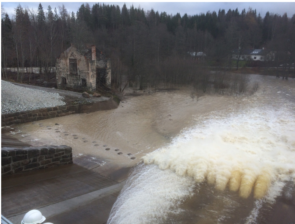
Figur 3.8 Spillvattentappning över stötblock vid samma kraftverk som på föregående foto under år 2016. Stötblocken träffas av det framsusande vattnet, inducerar ökad energiomvandling i vattenmassan genom att tvinga vattenmassan att lyfta sig, uppdelas genom luftmassan och tumla ned på nedströmssidan om stötblocken med friktionsförluster som följd. Då energimängden avtar genom den inducerade rörelsen i vattenmassan är det högsta trycket att finna vid stötblockens stötsida.
