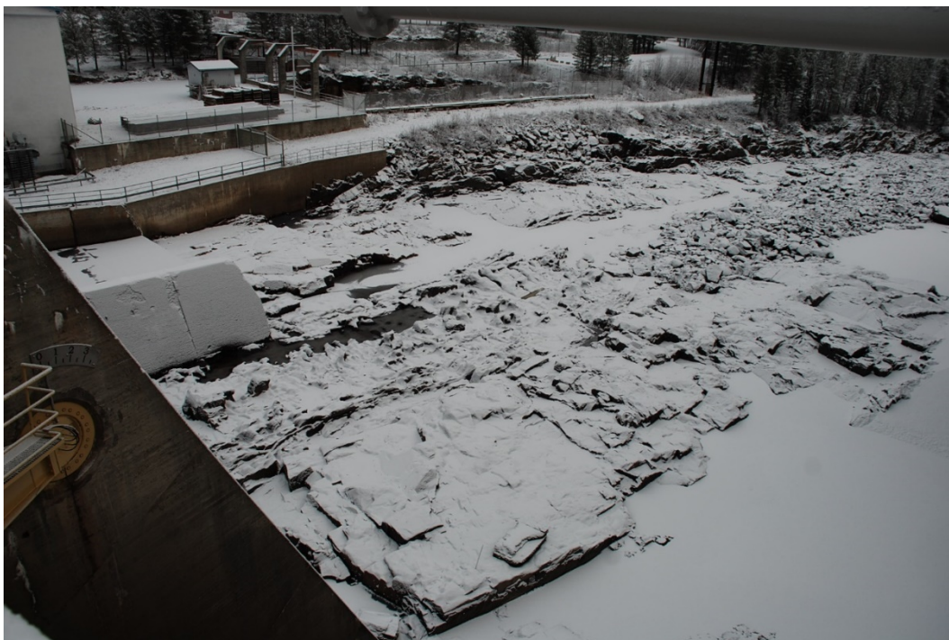
Figur 3.2 Bild över spillfåra vid ett kraftverk i norra Norrland under lätt snötäcke, se rapport 2018:532. Notera högra delen av spillfåran där berggrunden är uppsprucken i rektangulära block. Ömsom agerar berggrunden som stötblock, ömsom som stötbädd för de framrusande vattenmassorna. Sprickytorna avslöjas lätt i fält på grund av att vertikala sprickgrupper skär av bankningsplan och förlämnar överytan en kubistisk karaktär. Sprickorna i bankningsplanen är något öppna upp till 5mm emedan de vertikala sprickseten företrädesvis är täta till något öppna (<2,5mm) i överytan.
