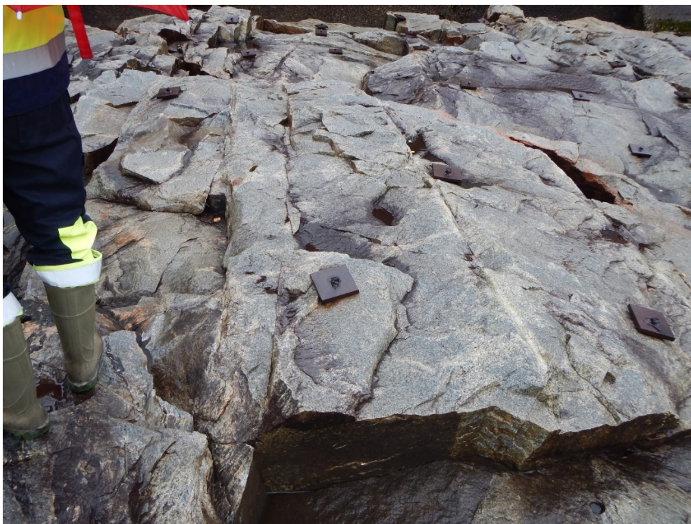
Figur 4.10 Fotografi från ett kraftverk i norra Norrland, se Energiforsk-rapport 2018:532. Lokalt har block slitits loss längs bankningsplan i Akkats. De branta sprickgrupper som avdelar bergmassan är i regel tunna med en sprickvidd som understiger 1mm. I denna spillfåra består berggrunden av medelkornig granit. Gummistövlar som skala.
