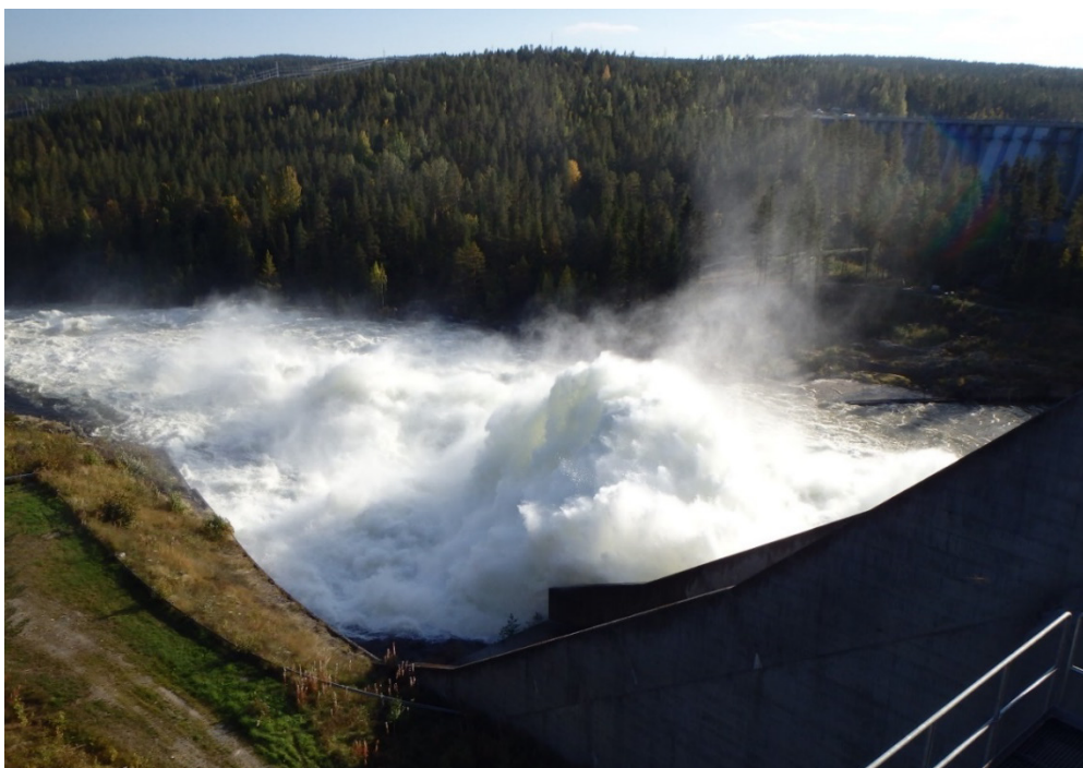
Figur 3.5 Fotografi från spillvattentappning ur center utskov vid ett kraftverk i Norrland år 2015 innan ombyggnationen av spillfåran, sidovy från vänster. Den berghäll som höjde sig ovanför vattenmassornas flödeslinje agerar som stötblock och orsakar därefter turbulens i flödet då vattenkaskaderna rytmiskt slår ned på bergytan nedströms.
