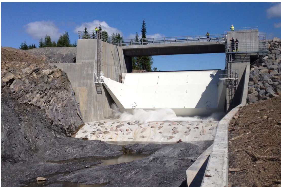
Figur 2.1 Förlängning av skibord genom pågjutning i spillfåra, vid ett kraftverk i Norge (Källa: Norconsult AS).
