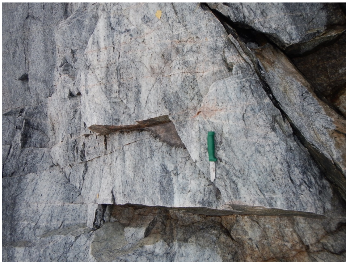
Figur 4.9 Fotografi från ett kraftverk i norra Norrland, se Energiforsk-rapport 2018:532. Berggrunden i Ligga karaktäriseras av riklig förekomst av öppna bankningsplan (1/4-2cm). För de branta sprickgrupperna som avdelar bergmassan så gäller i regel att de är tunna. Sprickvidden i de branta grupperna understiger 1mm. Berggrunden i denna spillfåra består av paragnejs.
