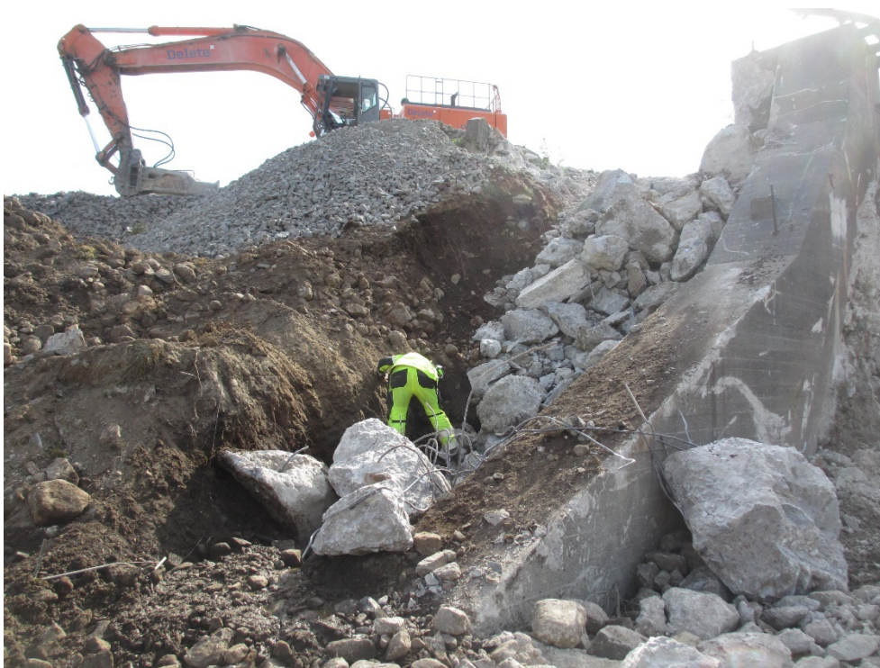
Fig. 11. Rivningsarbete påbörjat av den sista pelaren. Foto taget nedströms höger anslutning invid damm 17 sista kvarstående pelare.
