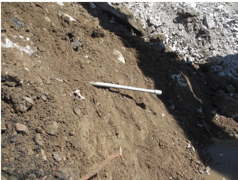
Fig. 22. Närbild på injektionsrör (Ø ca 2 tum) som stack upp ur den frilagda anslutningen genom tätjorden.
