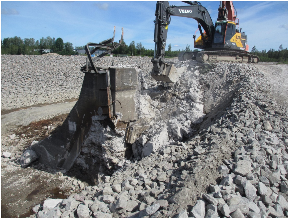
Fig. 13. Friläggning av vingmur. Foto taget från fångdamm, uppströms damm 17.
