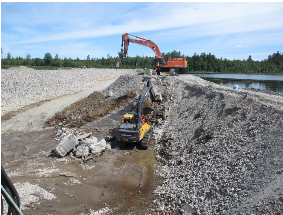
Fig. 15. Rivningsarbetet sett från vänster anslutning mellan damm 17 och damm 16. Fångdamm till höger i bilden.
