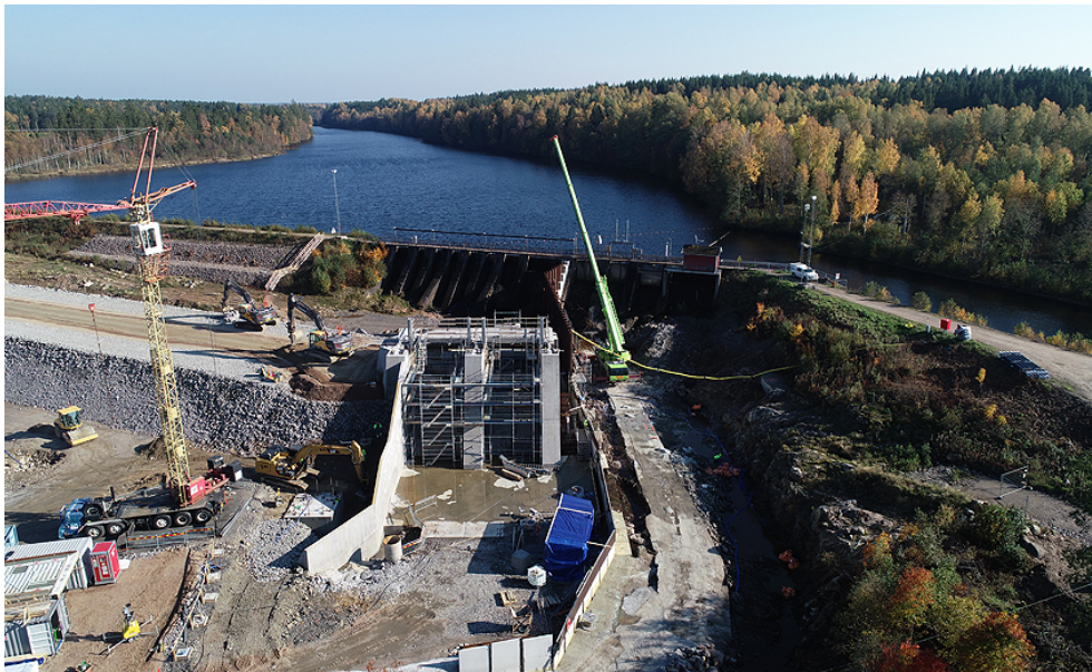
Fig. 5. Foto taget från ungefär samma punkt som Fig. 3 men med den nya regler- samt fyllningsdammen nedströms damm 17/damm 18. Reglerdammen är till hälften färdigställd när detta foto togs. Notera att damm 17 rivs i två etapper och att en spont ansluter centralt i damm 17 under rivningsarbetet. Foto: Csaba Prokec.
