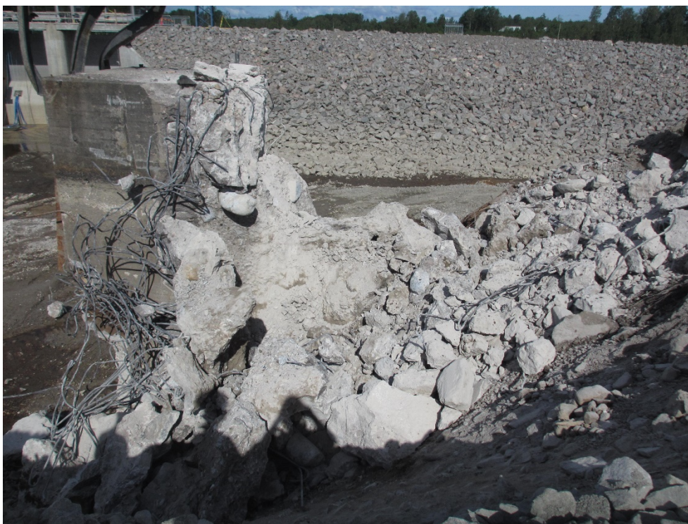
Fig. 16. Höger anslutning (pelare 13 samt vingmur) innan den sista delen av vingmuren revs.
