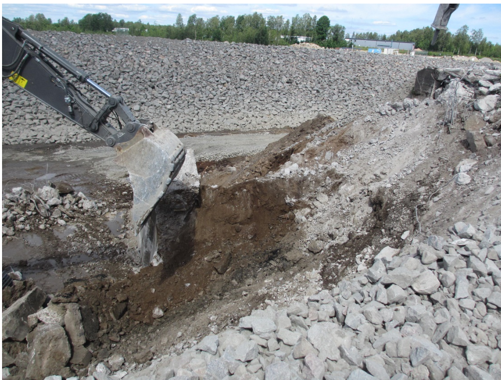
Fig. 17. Samma vy som föregående figur, Fig. 16 fast med vingmuren borttagen. Den jord som nu syns centralt i bild är den tätjord som legat emot betongen i anslutningen nedströms vingmuren. På denna yta togs prover ut av tätjord för bestämning av dess kornkurva. Endast halva pelare 13 står kvar.
