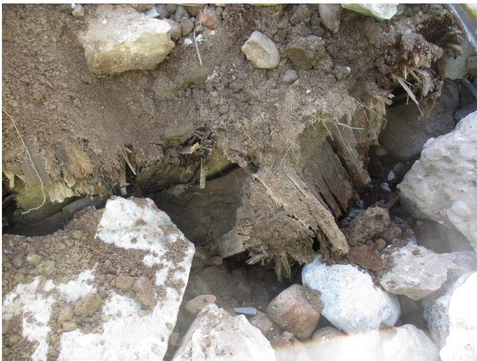
Fig. 23. Rester av en gammal träspont i anslutningen. Den träsponten som syntes var djupt placerad och orienterad vinkelrätt mot dammkrönet in i damm 18 något nedströms till.
