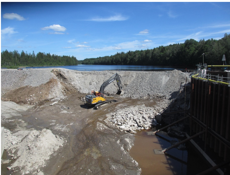
Fig. 27. Rivning av första etappen av damm 17 klar. Anslutning som studerades ligger till vänster i denna bild. Stålspont ansluter damm 17 vid pelare 5. Pelare 1 – 5 återstår att riva.
