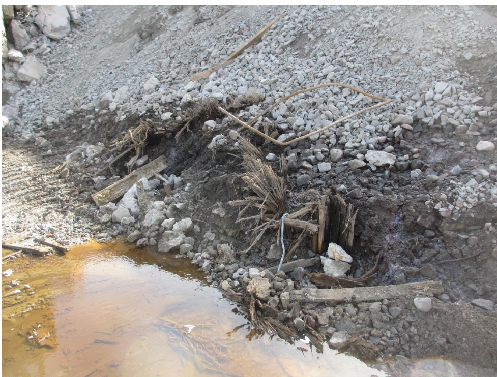
Fig. 25. Bilder på träspont mellan gamla damm 17 (demolerad) och fångdammen.
