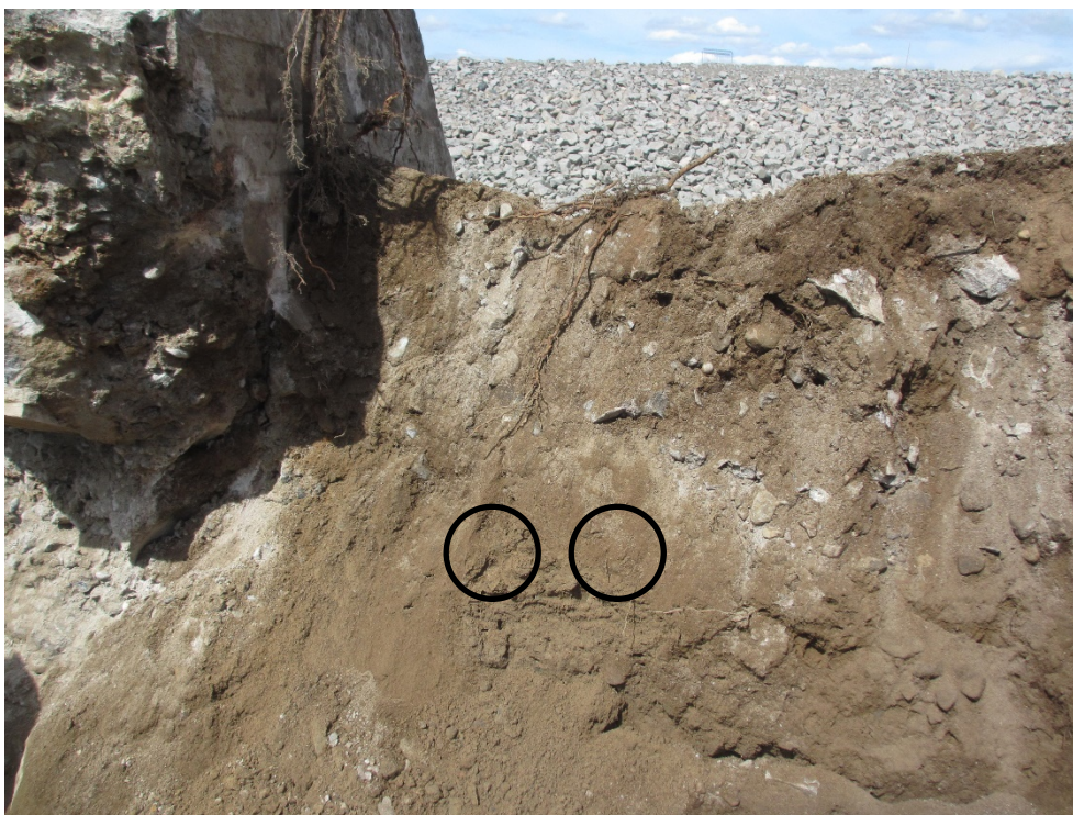
Fig. 18. Närbild på tätjord nedströms vingmur som visas i Fig. 17 vid höger anslutning. Provtagning av tätjord skedde vid de inringade områdena. Fotot är vinklat in mot damm 17.
