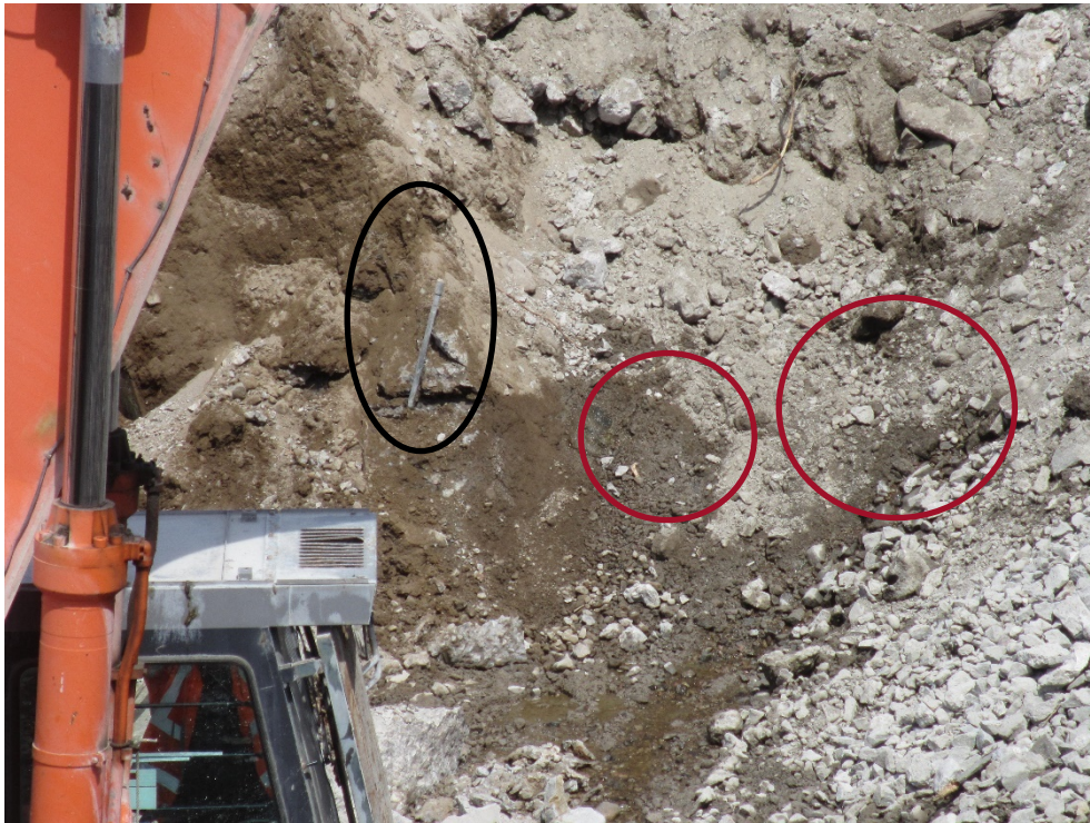
Fig. 21. Källsprång vid anslutning direkt efter dess friläggande (innanför de röda cirklarna). Gammalt injekteringsrör kunde skönjas något till vänster om bildens centrum (innanför svart ellips).
