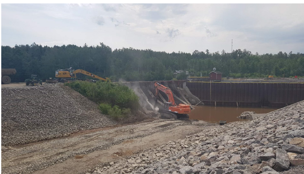
Fig. 9. Rivning påbörjad av damm 17 högra anslutning mot damm 18. Rivning påbörjades i pelare näst längst till vänster enligt figur. Foto taget från den nya fyllningsdammen nedströms damm 18. Foto: Martin Rosenqvist 19 juni 2019.
