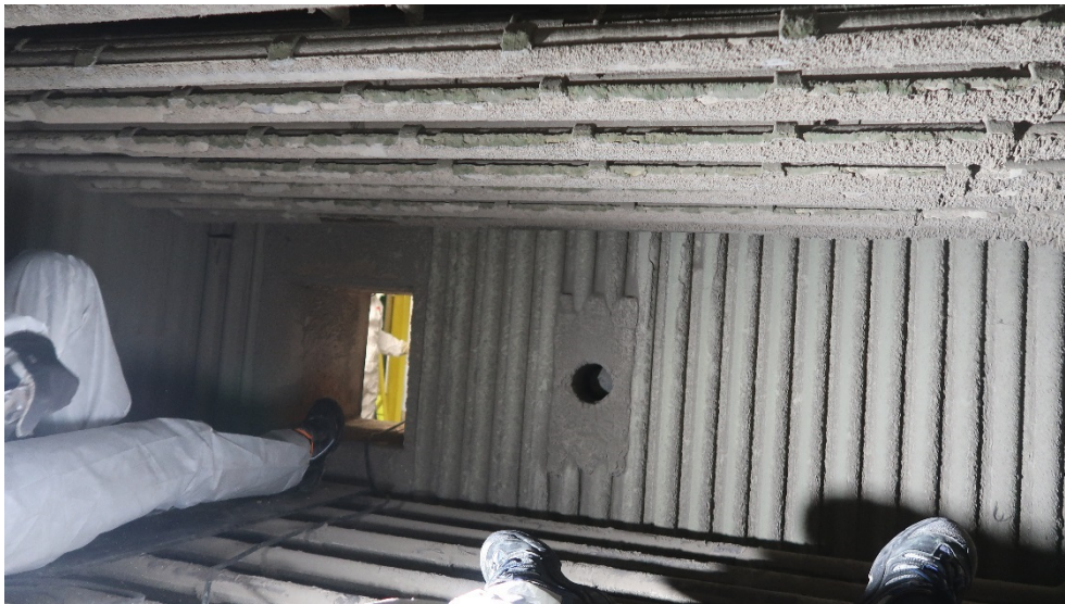
Figur 13. Utrymmet innanför manluckan med manluckan öppen (till vänster vid foten), samt cirkulär öppning för ångsotblåsare
