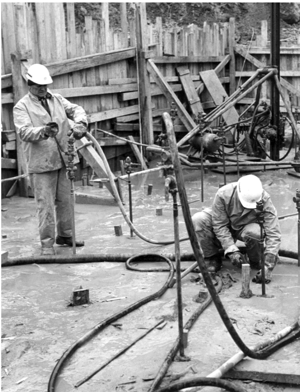
Figur 14. Vid injektering där avståndet mellan manschetterna varierar kan tyda på att injekteringsarbetet utfördes medelst successiv hålförtätning. Foto Uniper.
