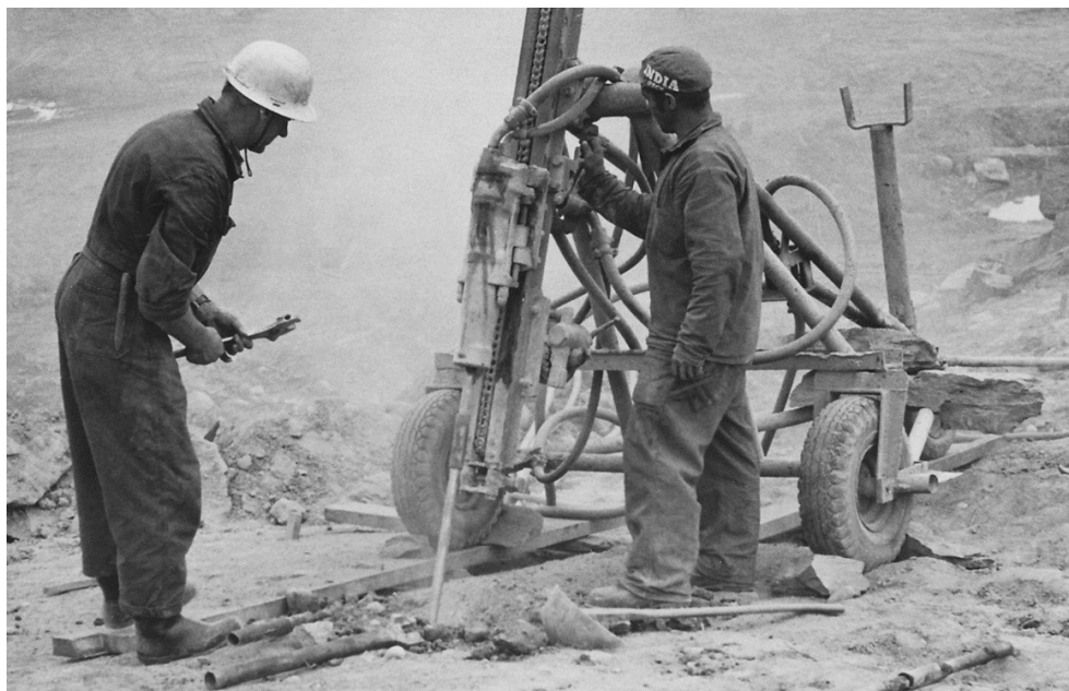
Figur 11. Bergborrning vid ett dammbygge. Observera snedställning av borrhålet. Foto Uniper.
