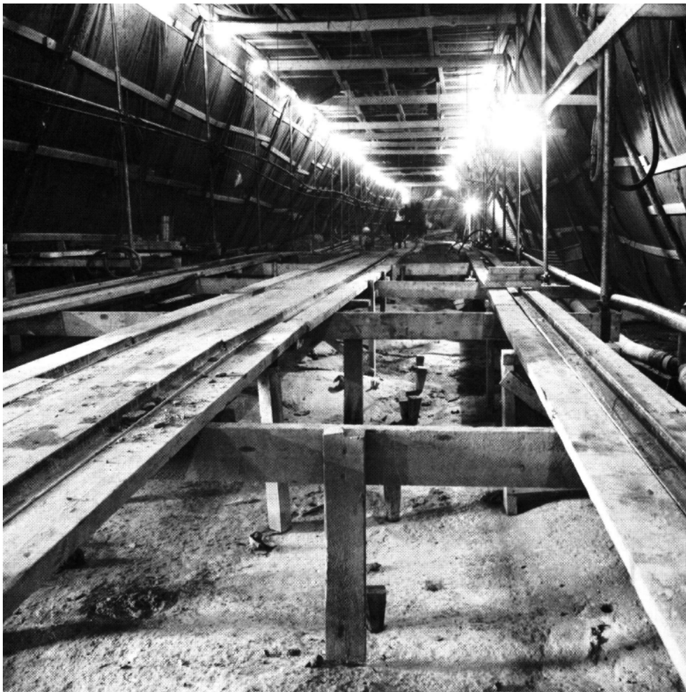
Figur 16. Insidan av ett värmeskjul som uppförts för att möjliggöra injektering vintertid. Genom uppvärmning hölls bergets temperatur på en nivå att injektering kunde utföras. Foto från Vattenfalls anvisningar (1968).
