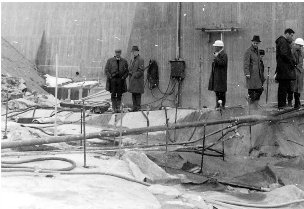
Figur 5. Placering av manschetter i rutnät inför utförande av ytinjektering. Foto Uniper.
