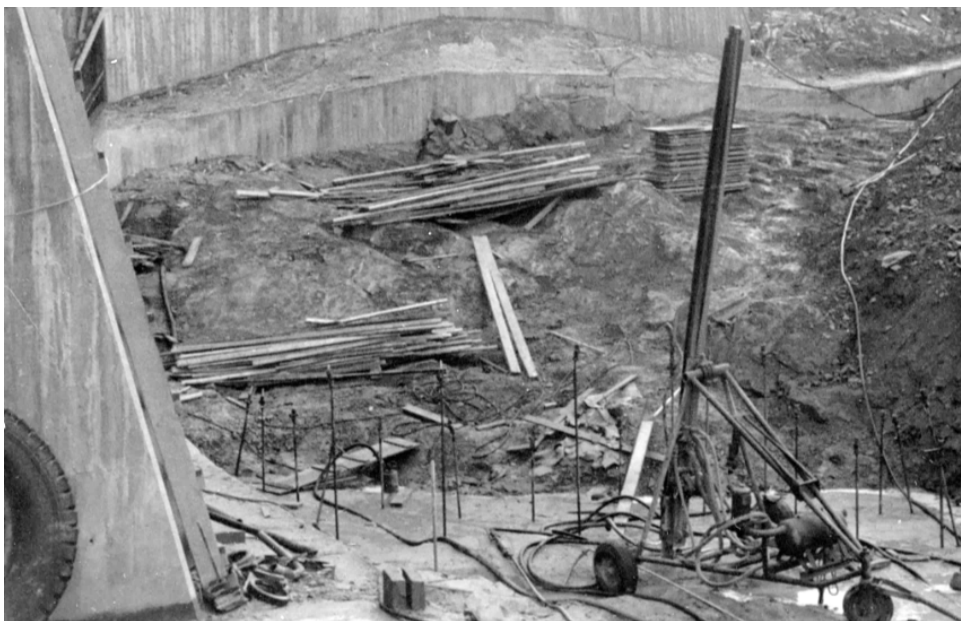
Figur 6. Kontaktinjektering av utrymmet mellan berg och betongutfyllnad. Foto Uniper.
