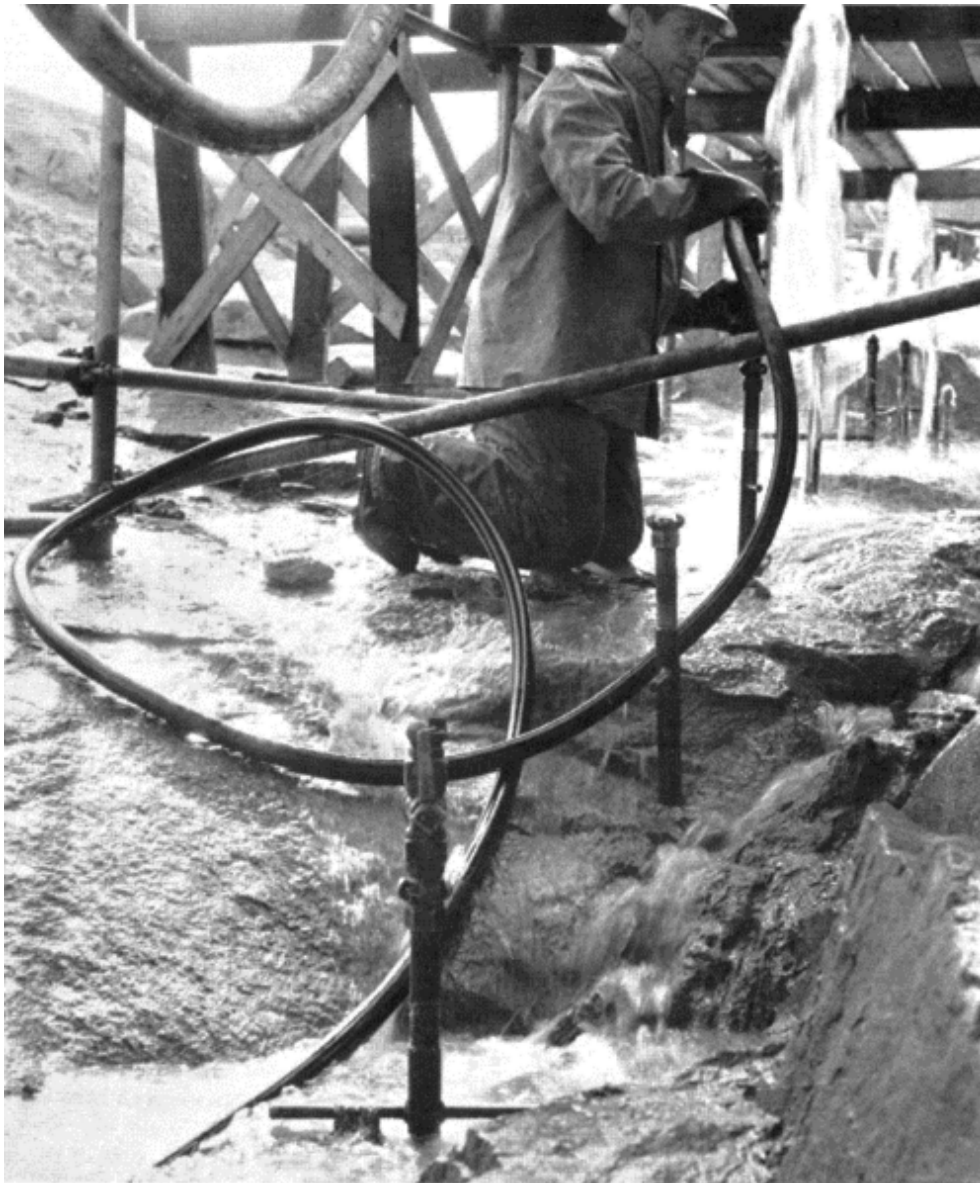
Figur 13. Vattentryckning i en borrhålsrad. Foto från Vattenfalls anvisningar (1988).
