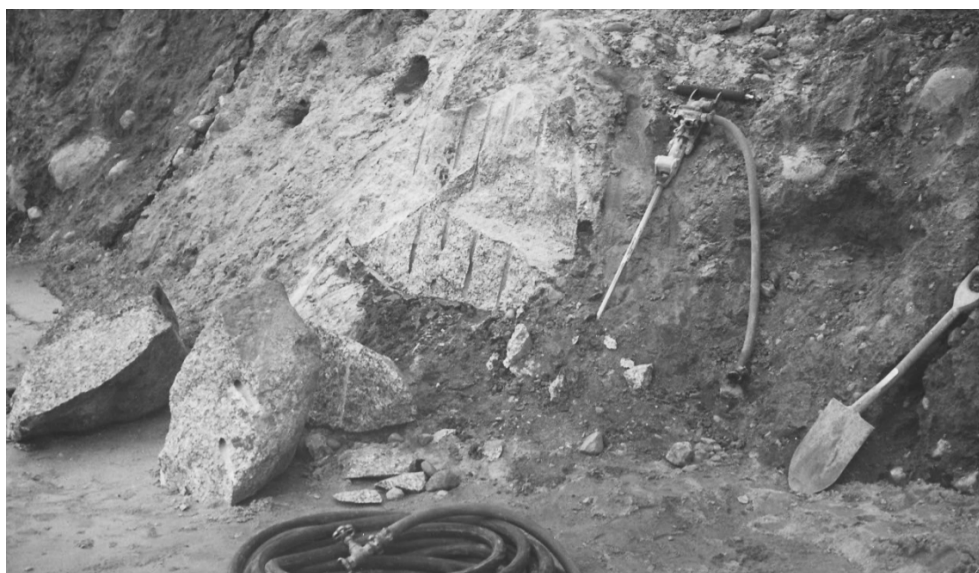
Figur 10. Bortmejsling av ett utstickande bergparti för att jämna av bergytan. Foto Uniper.
