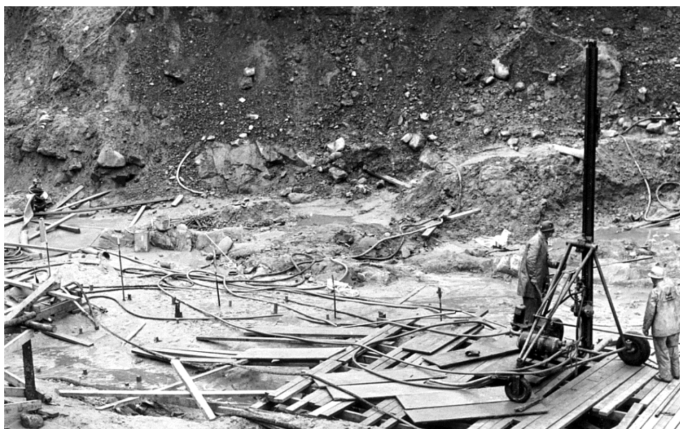
Figur 4. Borrning och montage av manschetter med regelbundet avstånd. Foto Uniper.
