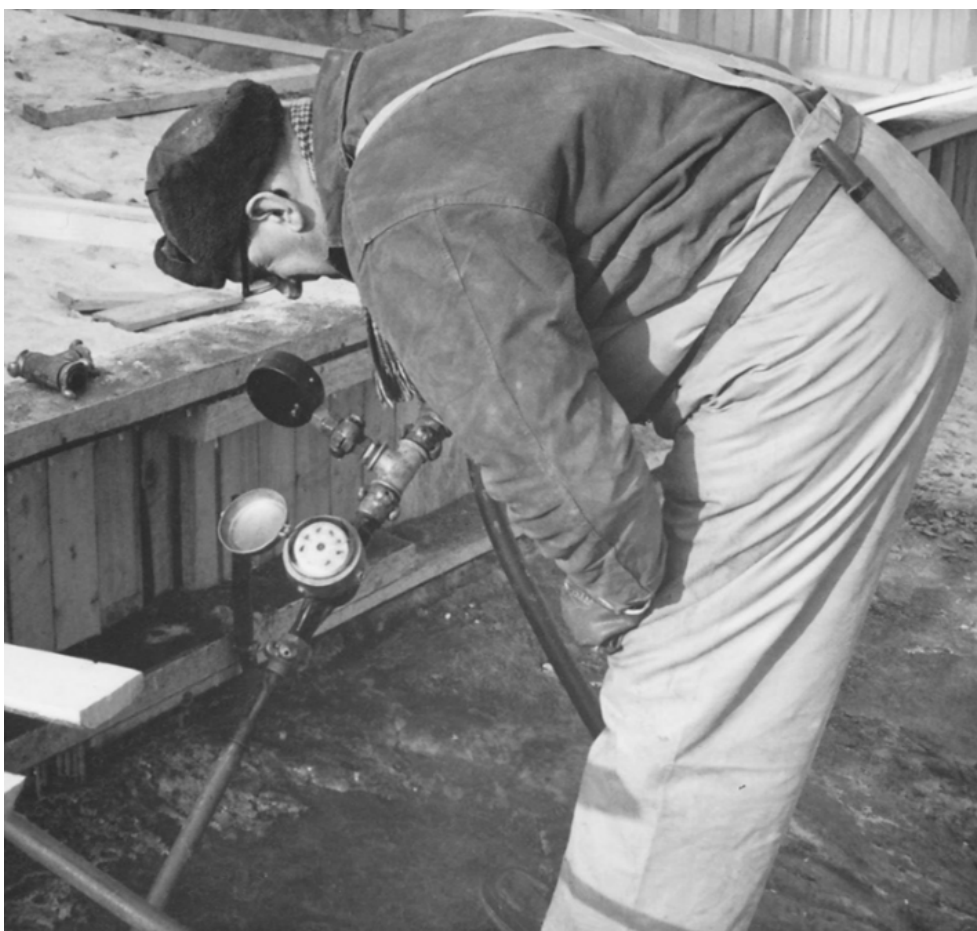
Figur 15. Kontroll av tryck och flöde vid injektering eller vattenförlustmätning. Foto Uniper.
