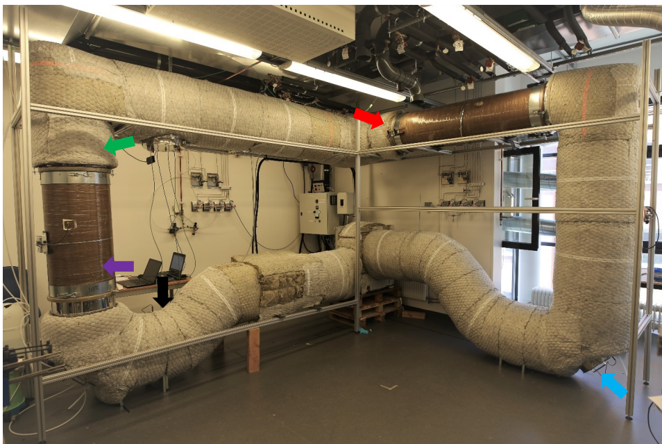
Bild 18. Anläggning med isolering samt monterade provcylindrar i GAP. Pilarna visar positioner för termoelement.
