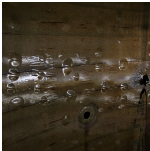
Bild 5a: Blåsor bildade i en skrubbevägg.
