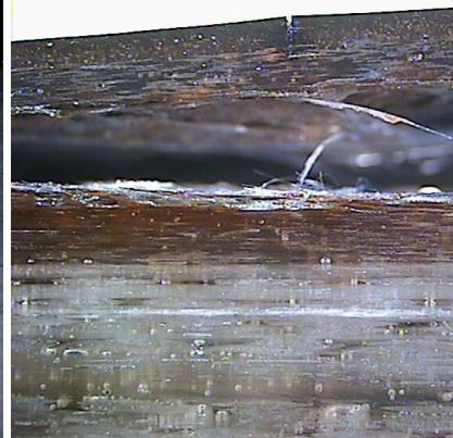
Bild 10b: Tvärsnitt av delaminering mellan spärr- och styrkelaminat.
