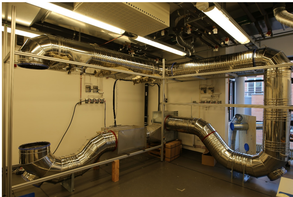
Bild 16. Testbädden under uppbyggnad. Ventilationsrör i rostfritt stål användes för att bygga kretsen.
