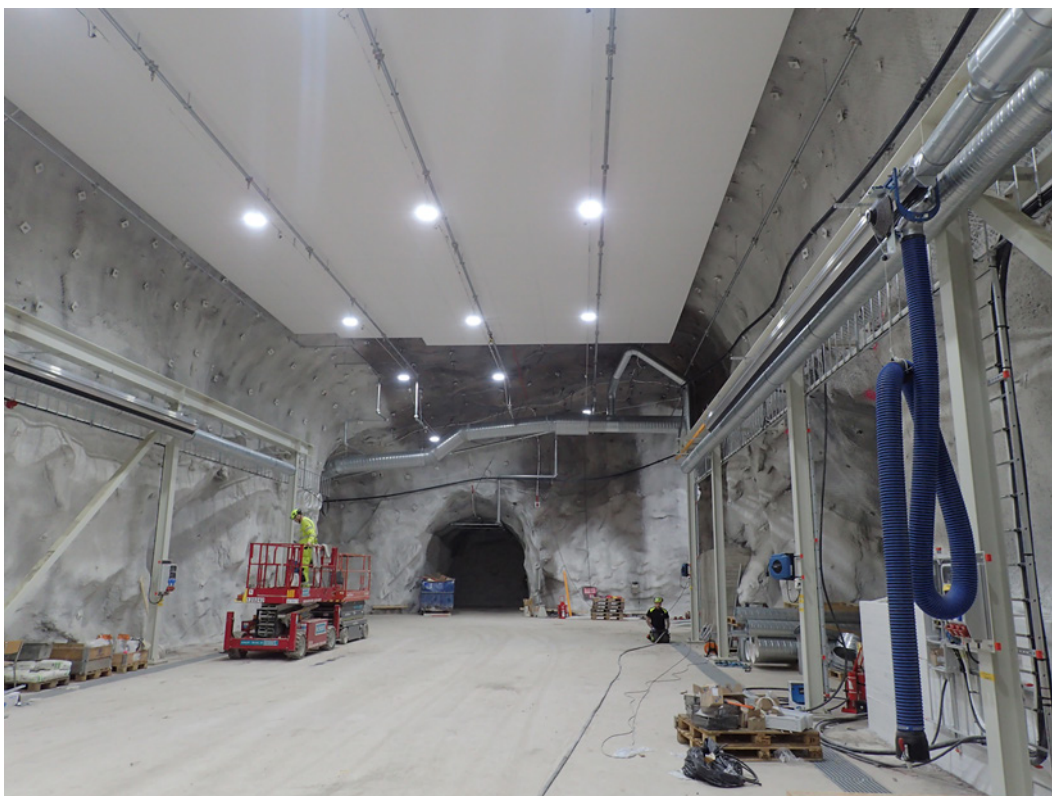
Figur 7-3. Personalutrymme som har förstärkts med sprutbetong och systematisk bultning.
