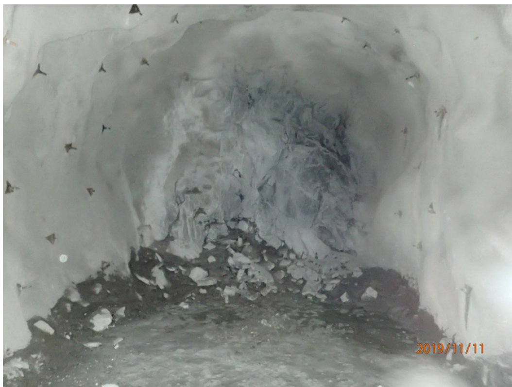
Figur 7-2. En ort som har förstärkts med minst 35 mm sprutbetong och systematisk bultning c/c 1.2 m.
