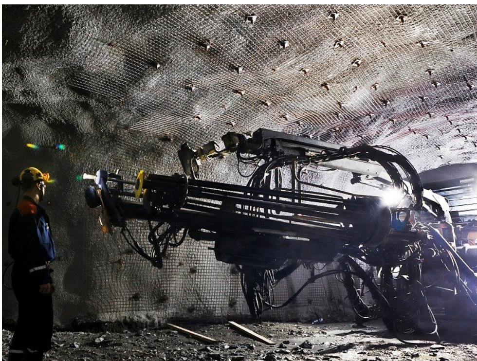
Figur 7-6. Exempel på bergförstärkning i en ort (från www.lkab.com ). Här syns sprutbetong, armeringsnät och systematisk bergbultning i tak och vägg.
