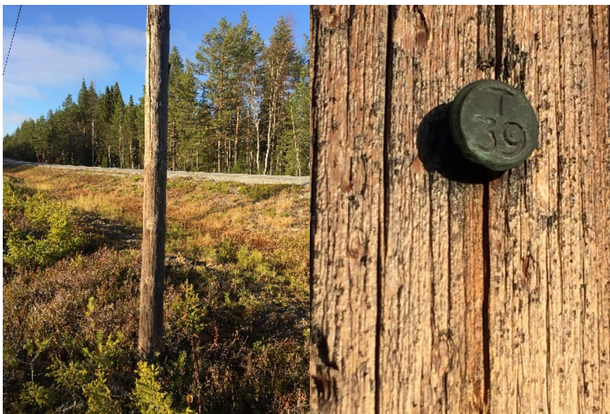
Figur 1. Kreosotstolpe fotograferad i oktober 2016 längs riksväg 92 väster om Umeå. Märkspik med instansad beteckning T39, som betyder kreosotimpregnerad 1939.
