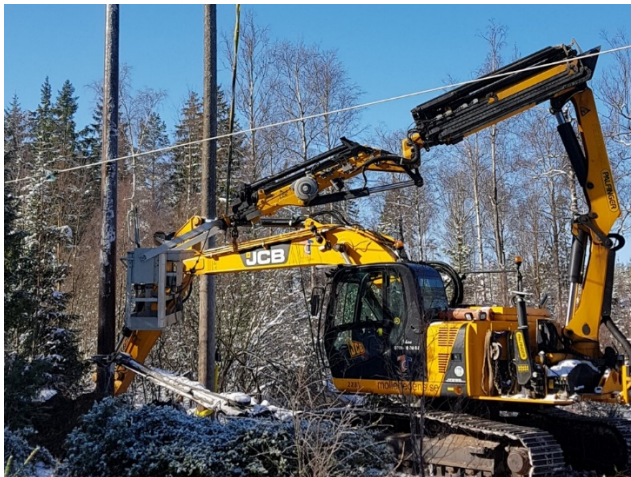
Figur 33. En WOPAS-stolpe ersätter den ena kreosotstolpen i en parstolpe. Källa: www.wopas.net
