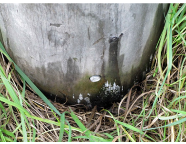
Stolpe nr 11. Fruktkroppar och algpåväxt strax ovan markbandet
