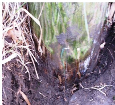
Stolpe 086. Synligt mycel under markbandet
