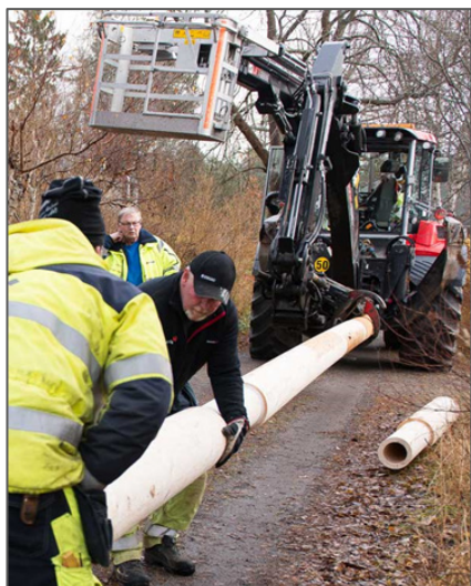
Figur 2. Montering av Forsnäs-stolpe på plats. Foto: Bo Vading
