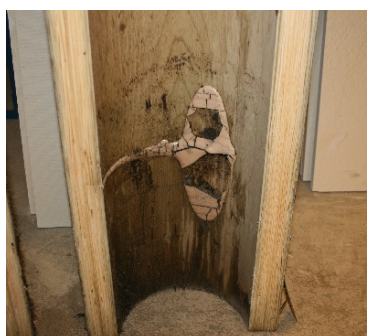
Fläck av överskottslim på insidan av stolpen
