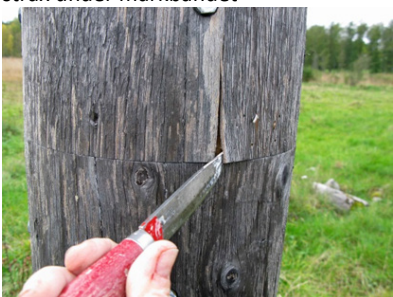
Stolpe nr 10. Knivblad trängde in 5 mm i öppen skarv
