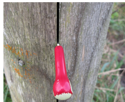
Stolpe 095. Djup spricka och fläckvisa svampfruktkroppar på ytan
