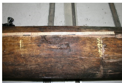
Klämskada orsakad av Grab John
