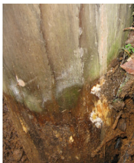
Stolpe 120444. Synligt mycel under markbandet
