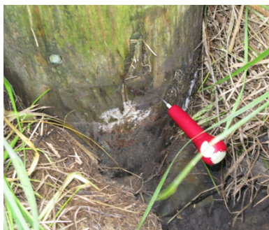
Stolpe 109. Synligt mycel under markbandet
