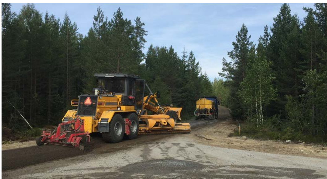
Figur 9. Bevattning och inhyvling av vatten i fräsmassan
