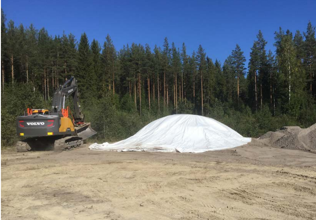
Figur 17. Lagring av aska under täckplast vid bergtäkten i Fjäl.
