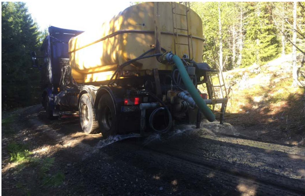
Figur A13. Vattning av askblandning med vattenbil.
