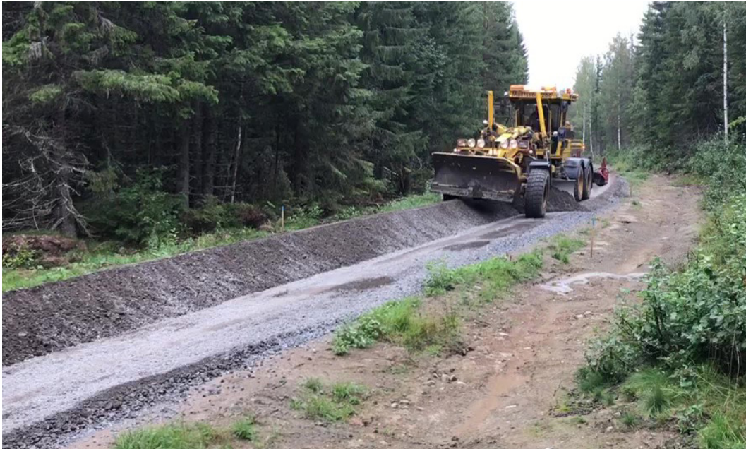
Figur 13. Utlagd aska omedelbart före hyvelblandning på testväg 2.
