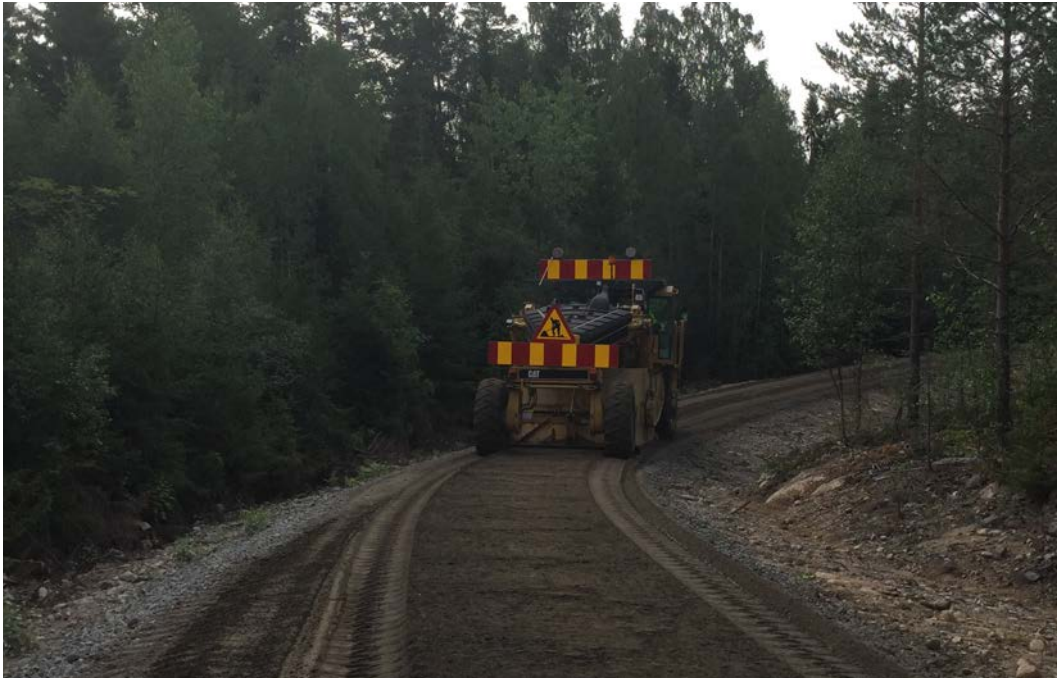
Figur A7. Framryckning med fräs.
