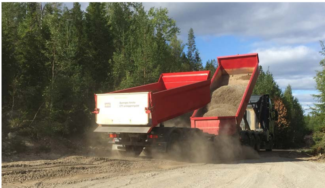
Figur 11. Utläggning av askblandning från krossverket med lastbil och släp.
