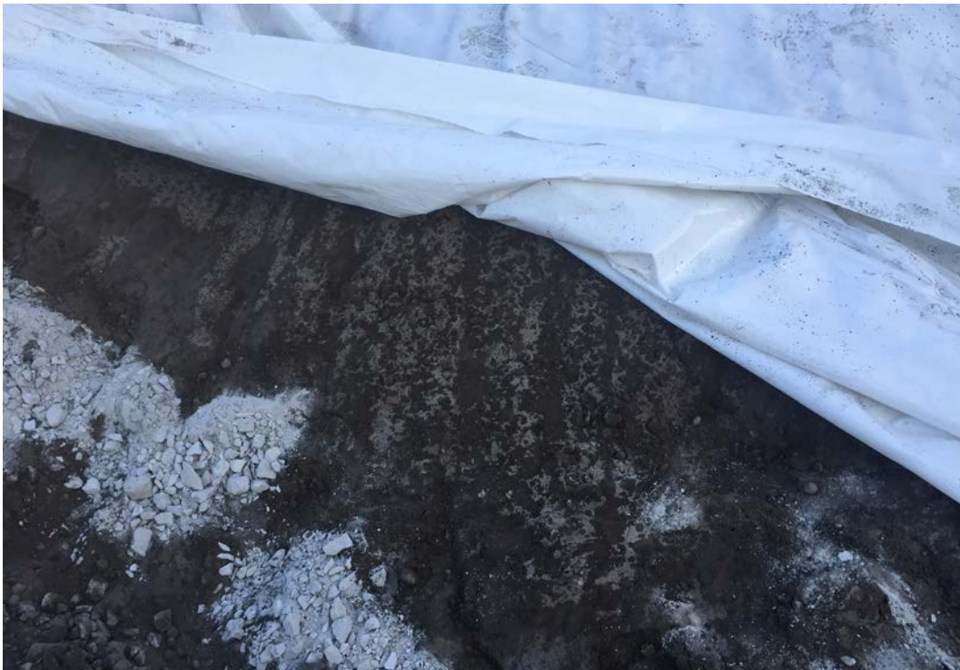
Figur 18. Vissa problem med kondens under plasten förekom.
