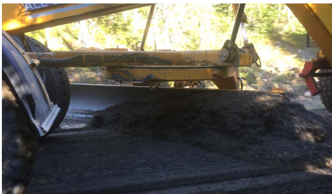
Figur 12. Aska och grusmaterial under blandning med vägghyvel på testväg 1.
