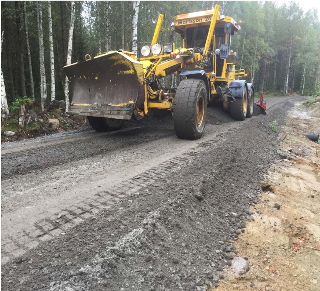
Figur A8. Blandning med hyvel på testväg 1. Materialet blandas från sida till sida.
