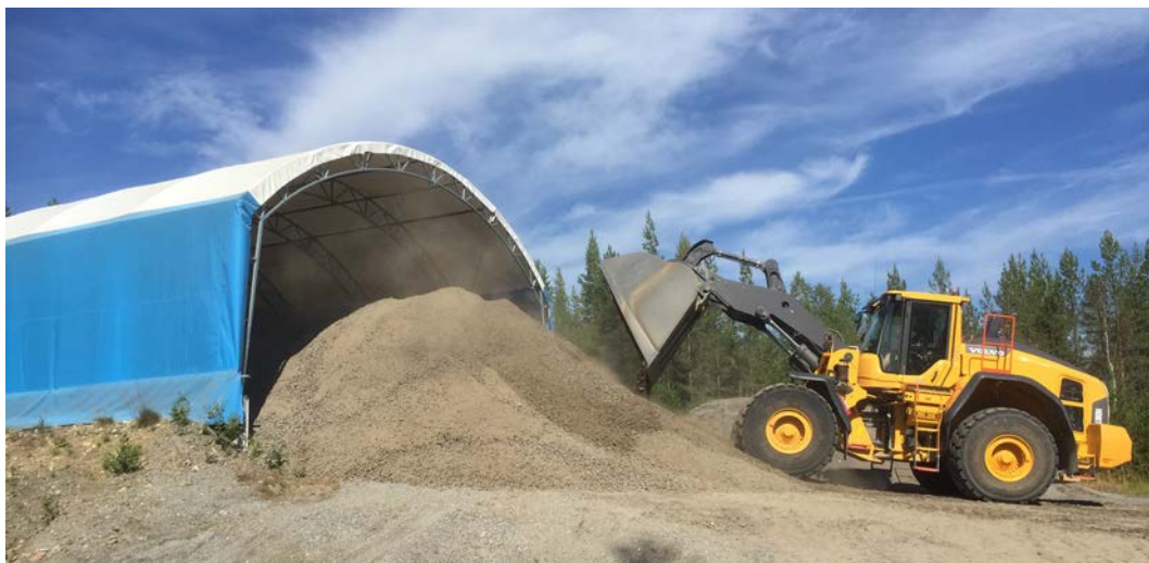
Figur A4. Stackning av krossblandning i tälthall. Allt rymdes inte, varpå delar av högen hamnade utanför tältet och täcktes med GROT-papp.
