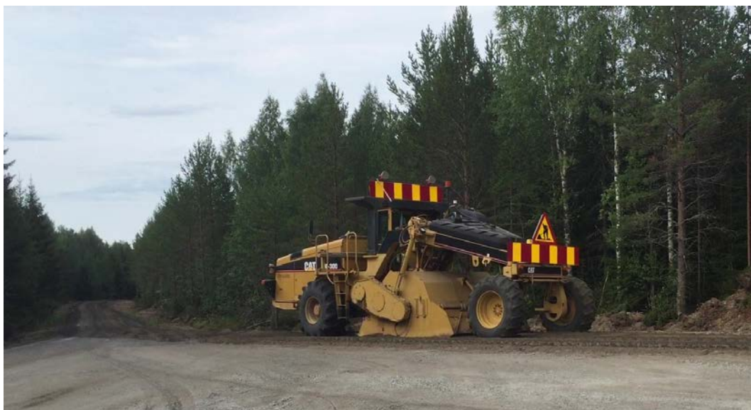
Figur 8. Den använda vägfräsen, Caterpillar RM-300. Fräsning av teststräcka 1, testväg 1 (metod 1).
