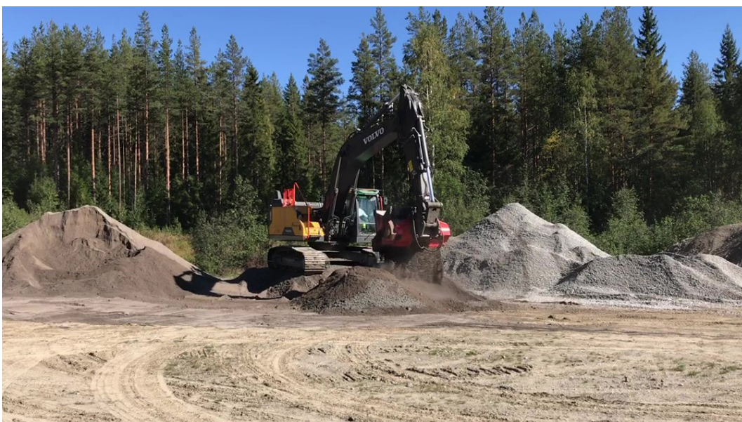
Figur 14. Blandningsskopan i arbete på lagringsplatsen vid Högsjömon.
