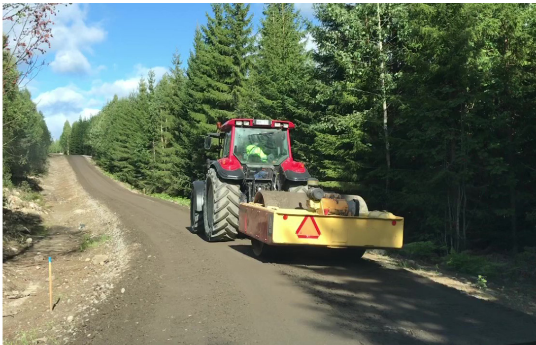
Figur A11. Vältning med bogserad vibrovält.
