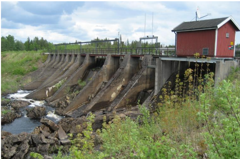
Figur 1. Nedströmssidan av den ursprungliga utskovsdammen vid Hylte kraftverk. Fotograferad i maj 2011.
