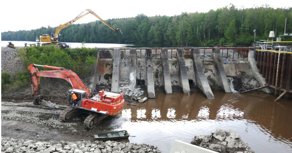
Figur 71. Utskovsdammen strax efter att rivningsarbetet hade inletts med stödpelare 11. Fotografiet togs från en plats på den nya stenfyllningsdammen vid lunchtid den 19 juni 2019.
