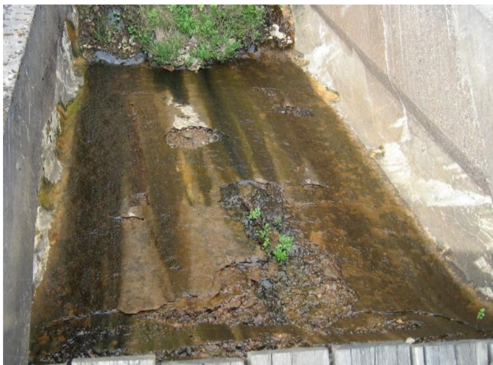
Figur 32. Status för lagningsbruket på skibordet i utskov 6. Fotografiet togs från dammens krön i maj 2011.
