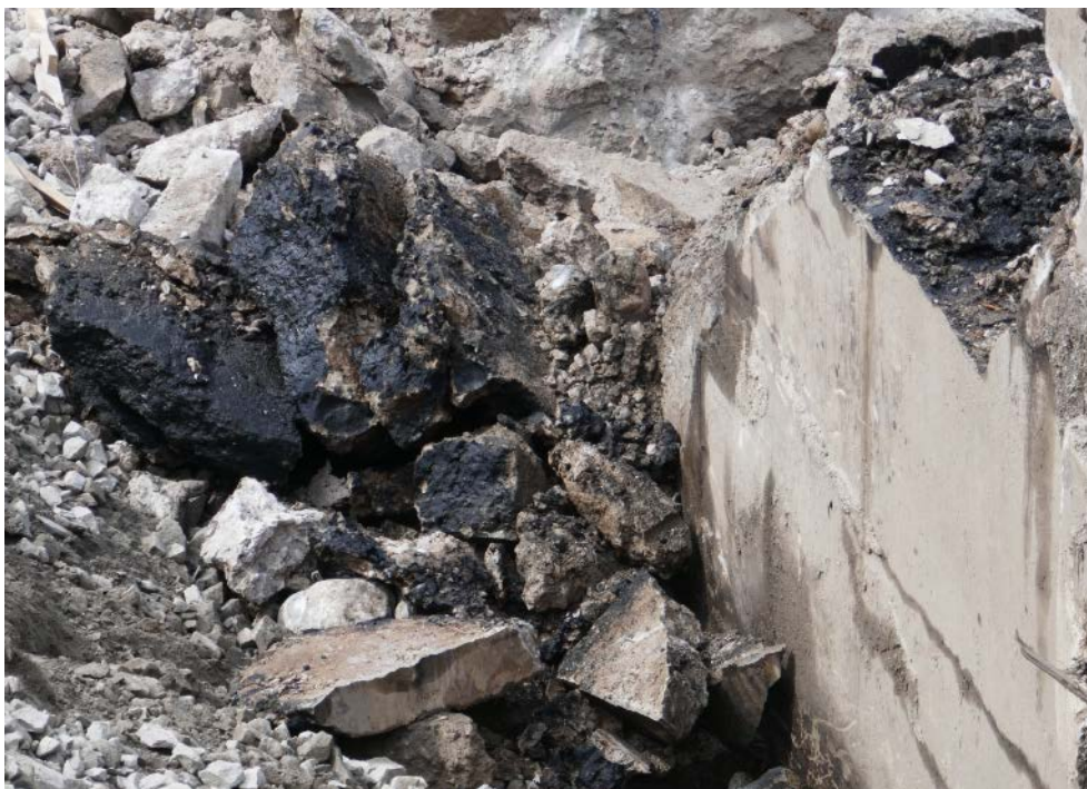
Figur 105. Stora betongstycken där brottytorna var mörkbruna, nästintill svarta, i kulören.
