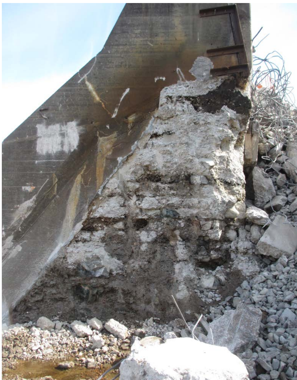
Figur 95. Pelare 13. Inblick i den utrivna utskovströskeln med tillhörande skibord i utskov 12. Vad som syns i fotografiet är att betongen torkar långsammare längs de horisontella gjutfogarna. Fotografi från J Lagerlund.
