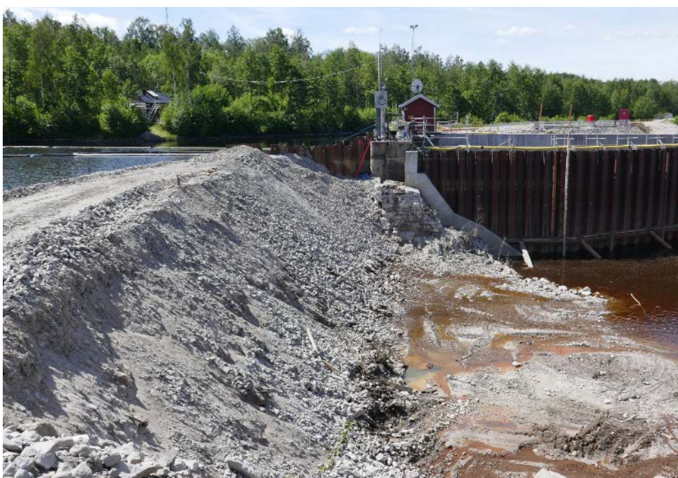
Figur 74. Utskovsdammen efter att utrivningen hade fullbordats.
