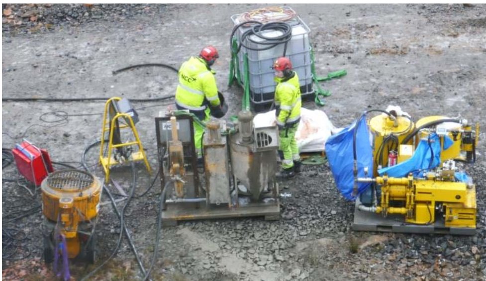
Figur 64. Injekteringsutrustningen bestående av blandare, lagringskärl, pump och registreringsutrustning.
