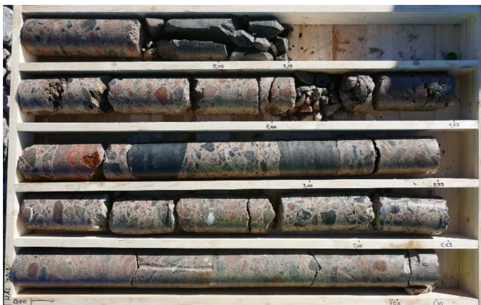
Figur 66. Betongkärna M. Krönets yta ned till vänster. Kärnans totala längd 5,2 m.
