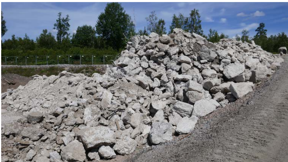
Figur 75. Rivningsmassorna placerades i ett upplag i avvaktan på krossning för att separera stål från betong.
