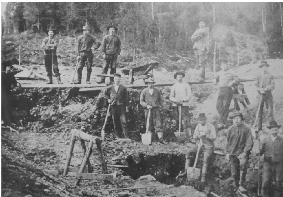
Figur 22. Fotografi från grävningen av tilloppskanalen 1907–1909. Fotografiet från Hembygdsförening (2002).
