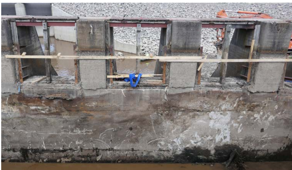
Figur 91. Innan rivningsarbetet inleddes syntes ej några mörka stråk på dammens uppströmsida, vilket indikerade att det vatten som pressades ut vid rivningen rymdes i håligheter inuti dammkroppen.
