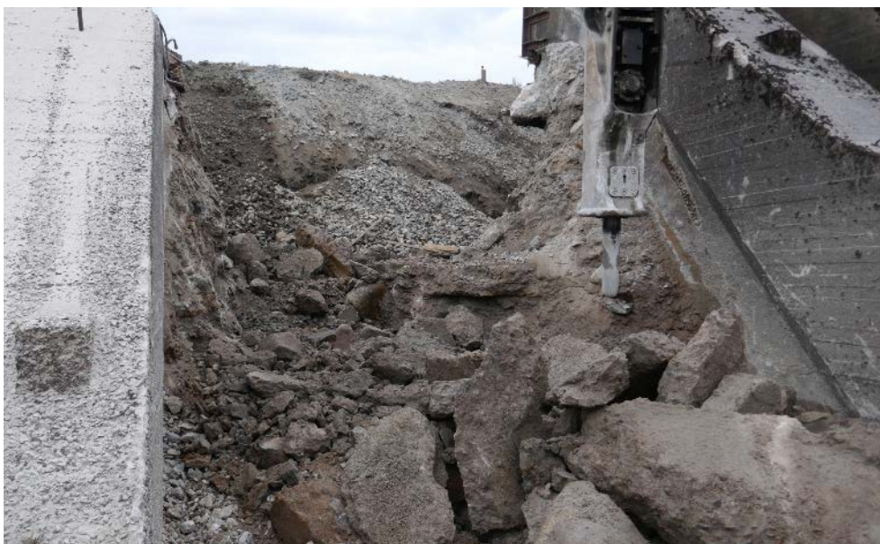
Figur 92. Rivningen av utskovströsklarna/skiborden i utskov 10 och 11, samt resterande del av pelare 11 gick snabbt. Betongen föll sönder i horisontella skikt och betongstyckena kunde enkelt dras ned på marken.
