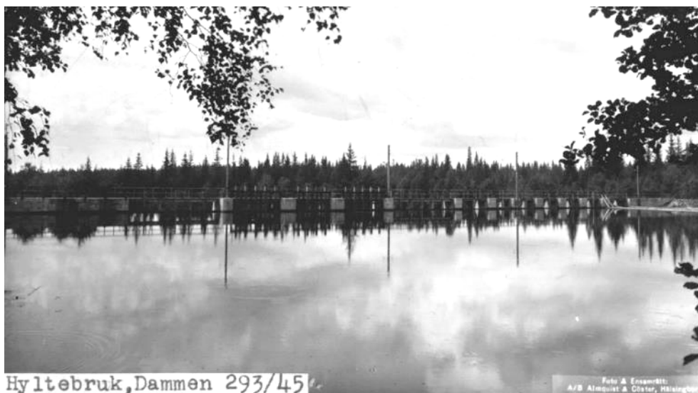
Figur 11. Ej antaget motiv till vykort som visar utskovsdammens uppströmssida. Fotografiet ska ha tagits 1932. Fotografiet har skannats och tillhandahållits av K-O Nilsson ( www.hyltevykort.se ).
