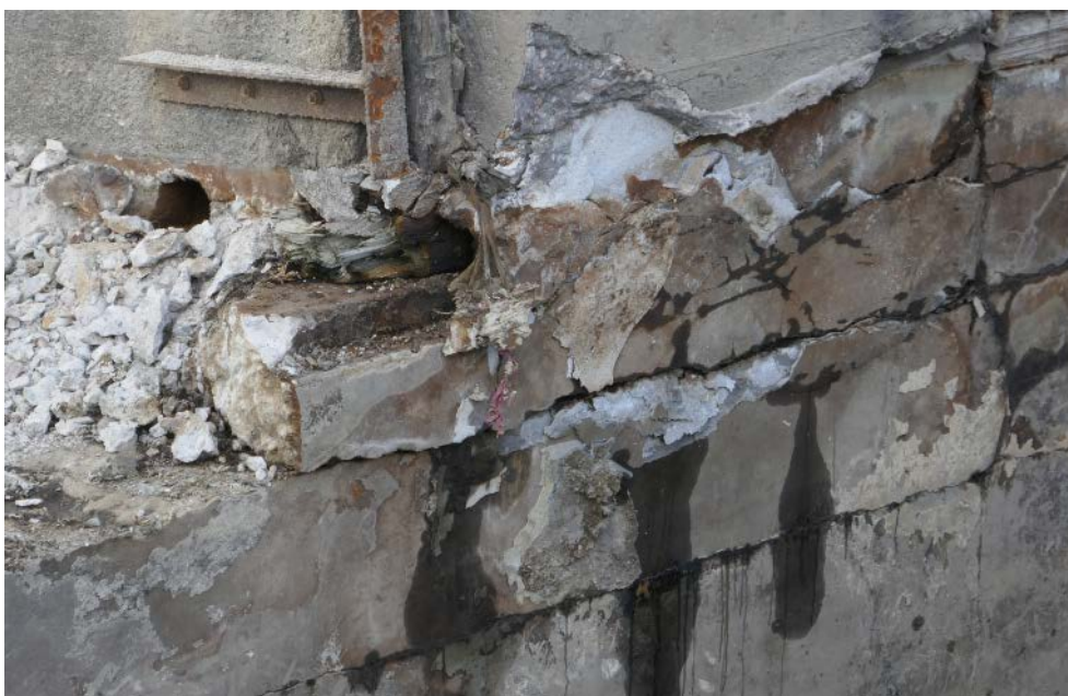
Figur 99. Pelare 12. Bakom bortfallna bitar av putsskiktet noterades ett friskt injekteringsbruk (ljusa områden).
