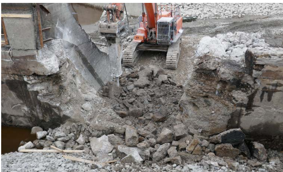
Figur 93. Uppströms vy efter rivningen av utskov 10 och 11, samt resterande del av pelare 11.
