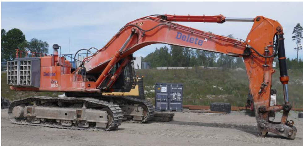
Figur 68. Grävmaskinen som användes vid rivningsarbetet var av märket Hitachi ZAXIS 850H.
