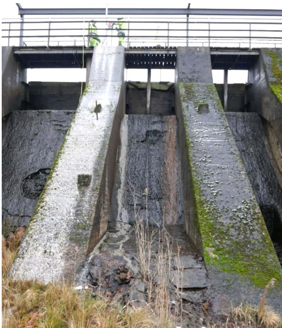
Figur 51. Tröskel och skibord i utskov 11. Utborrning av betongkärnor från pelare 12 utfördes i december 2018.
