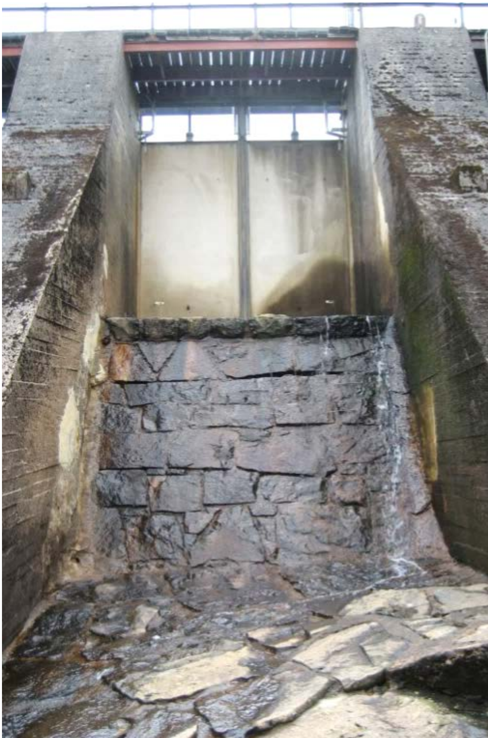
Figur 27. Utskov 3 med stenbeklädnad på tröskel, skibord och skibordsförlängning. Fotografi från maj 2011.
