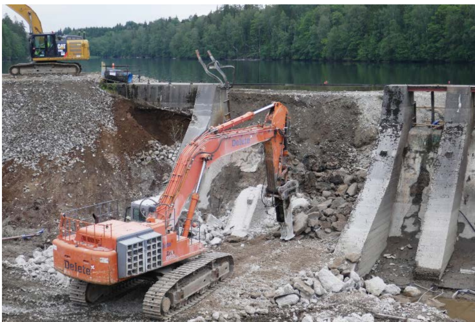
Figur 96. Friläggning av vingmuren som utgjorde del av anslutningen mellan betong- och jorddamm.
