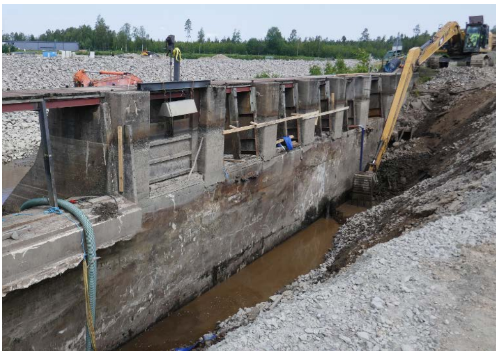
Figur 81. Friläggningen av dammens uppströmssida visade att den putsats. Äldre träspontar påträffades också.
