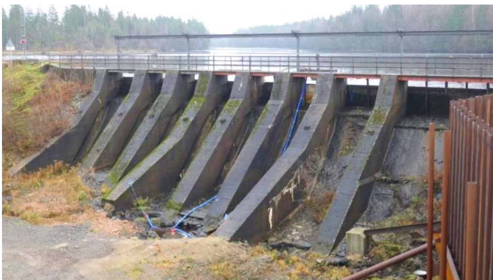
Figur 24. Nedströmssidan av den högra delen av utskovsdammen i november 2018. I fotografiet syns utskov 5–12 respektive stödpelare 6–13. Denna del av dammen revs ut i juni 2019.
