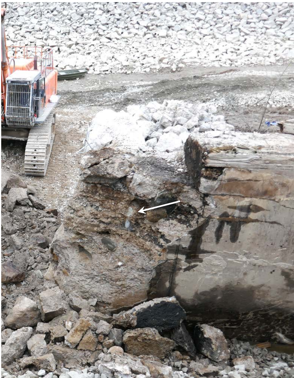
Figur 109. Pelare 12 – uppströmsvy. Inblick i pelarens inre under ett uppehåll i rivningsarbetet. Notera det med friskt injekteringsbruk igenfyllda borrhålet US (vit pil). Betongen var brunfärgad i partiet runt borrhålet. Läget för den brunfärgade betongen sammanföll med de horisontellt orienterade sprickorna i putsskiktet.
