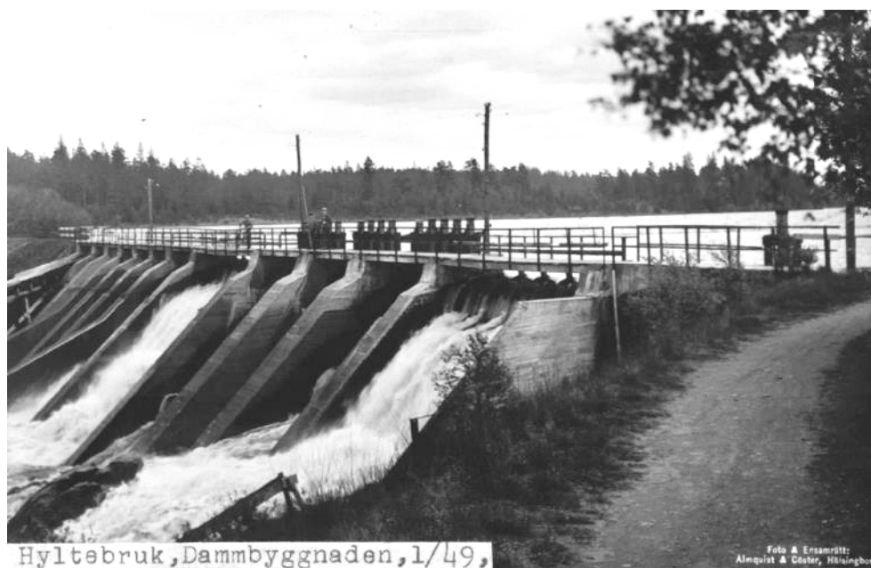
Figur 9. Ej antaget motiv till vykort. Enligt noteringar på fotografiets baksida ska det ha tagits 1932. Notera att stödpelarna har förlängts genom pågjutning. Det har även tillkommit en ledmur nedströms pelaren längst till vänster i flödesriktningen. Fotografiet har skannats och tillhandahållits av K-O Nilsson ( www.hyltevykort.se ).
