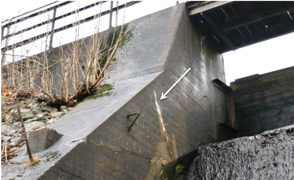
Figur 37. Pelare 13. Sned spricka med vit kalkutfällning (vit pil). Gjutfogen från 1940-talets höjning syns också.
