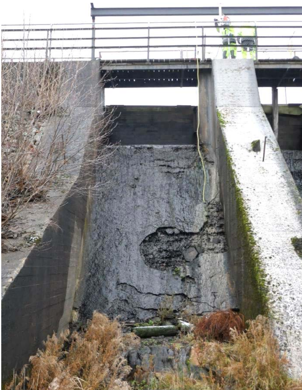
Figur 52. Tröskel och skibord i utskov 12. Utborrning av betongkärnor från pelare 12 utfördes i december 2018.
