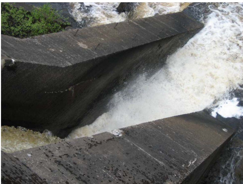
Figur 41. Vid avbördning utsätts den inre och nedre delen av pelarna för strömmande vatten.
