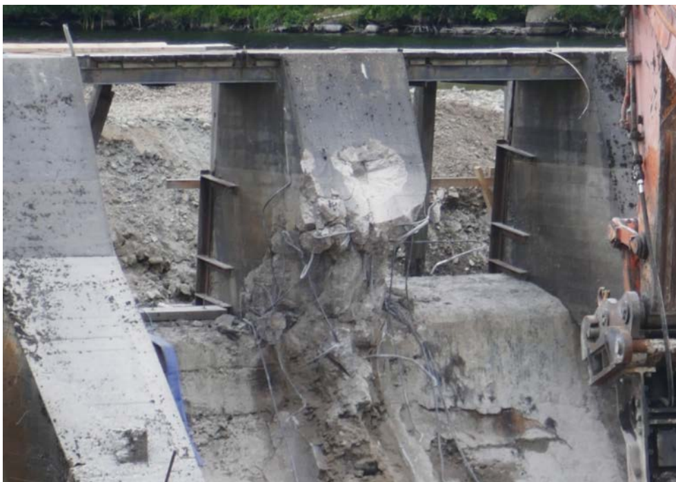
Figur 86. Pelare 11. Pelartoppen strax innan rivning. Höjdskillnaden mellan utskovströskel och krön är 2,36 m.
