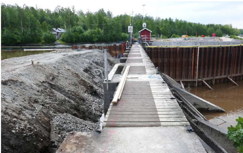
Figur 73. Utskovsdammen strax innan rivningsarbetet påbörjades. Till vänster i fotografiet syns fångdammen.
