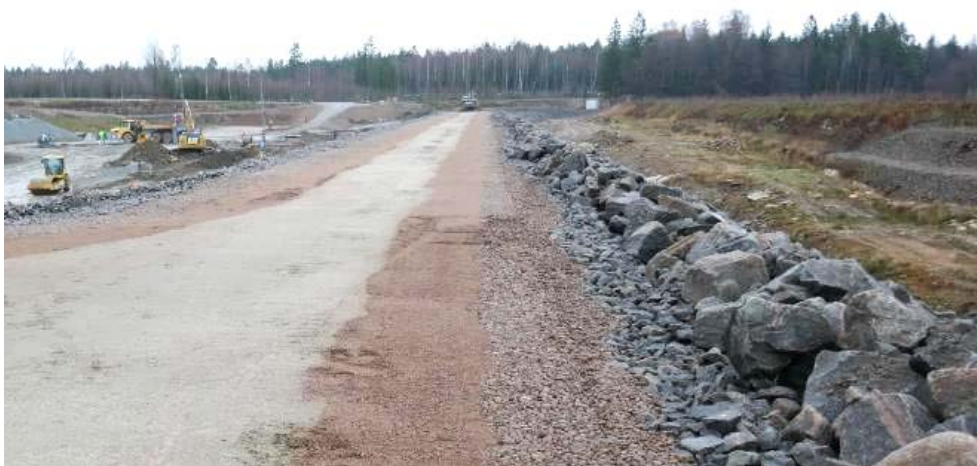
Figur 21. Den nya stenfyllningsdammen nära fullbordan i november 2018. Centralt i dammen syns tätjorden, därefter två lager filtermassor, samt ytterst stenfyllning med utanpåliggande erosionsskydd.
