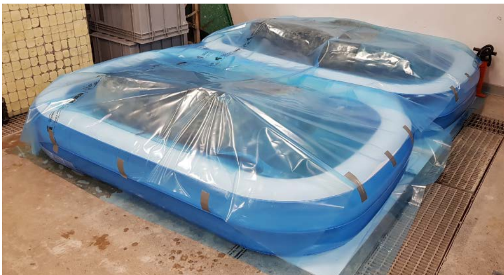
Figur 80. Bassängerna har täckts över för att betongstyckena ska omges av luft med hög relativ fuktighet.
