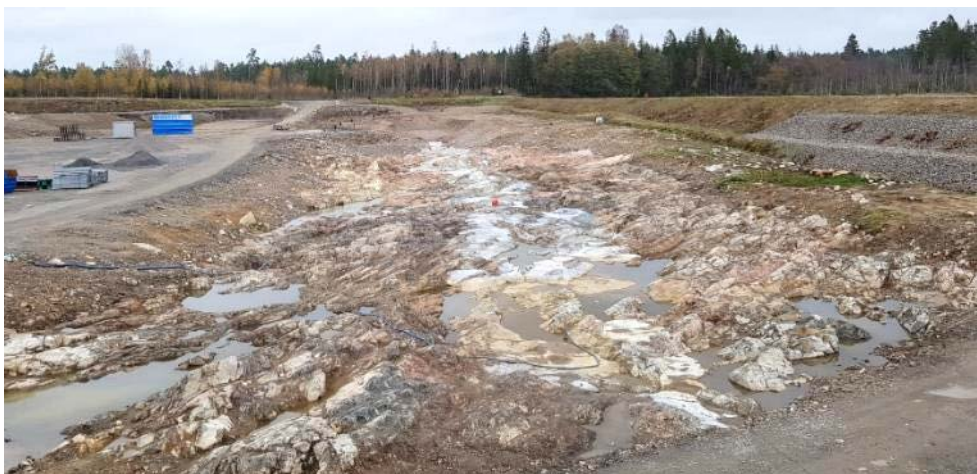
Figur 20. I oktober 2017 hade bergytan frilagts vid platsen för den nya stenfyllningsdammen. Den ursprungliga jordfyllningsdammen, inklusive senare utförd förstärkning av dammtån, syns längst till höger i bild.
