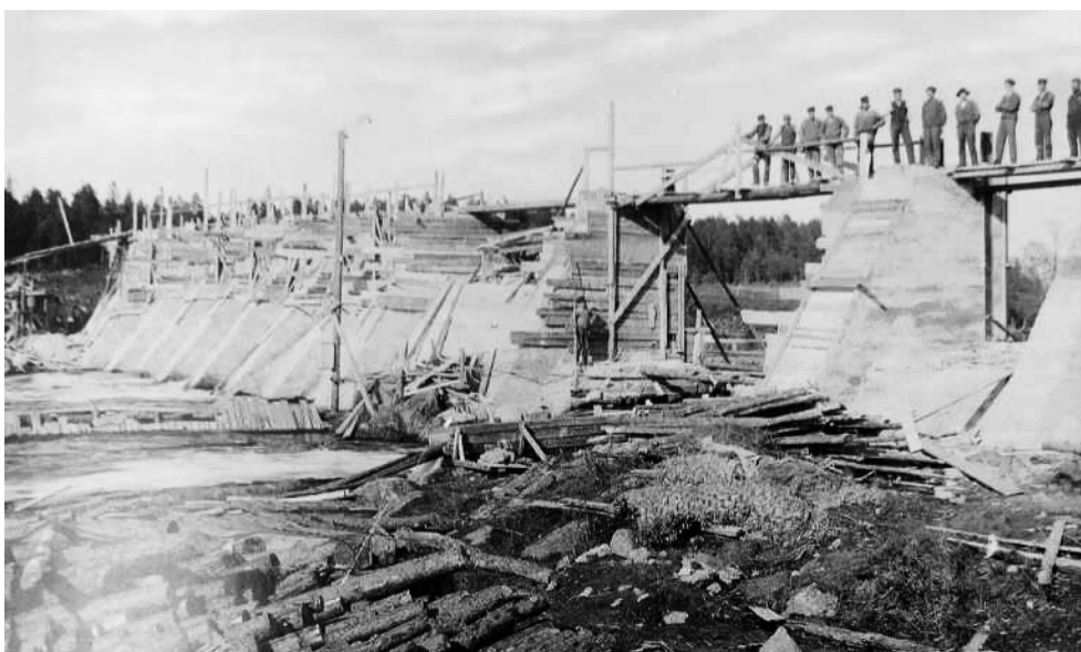
Figur 5. Fotografi från bygget av utskovsdammen 1907–1909. Fotografiet från Hembygdsförening (2002).
