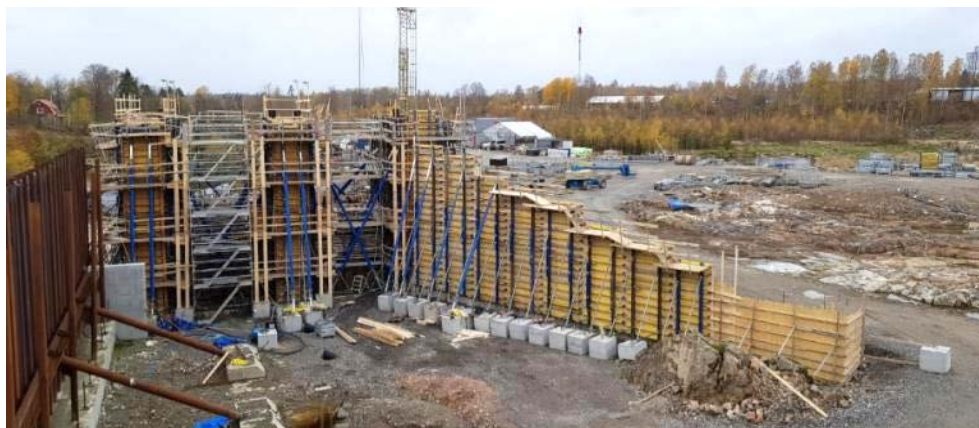
Figur 18. Uppströmssidan av den nya utskovsdammen fotograferad från den gamla utskovsdammen i oktober 2017. Formbygge inför gjutning av stödmur mot den nya stenfyllningsdammen, samt pelarna i utskov 3 och 4.
