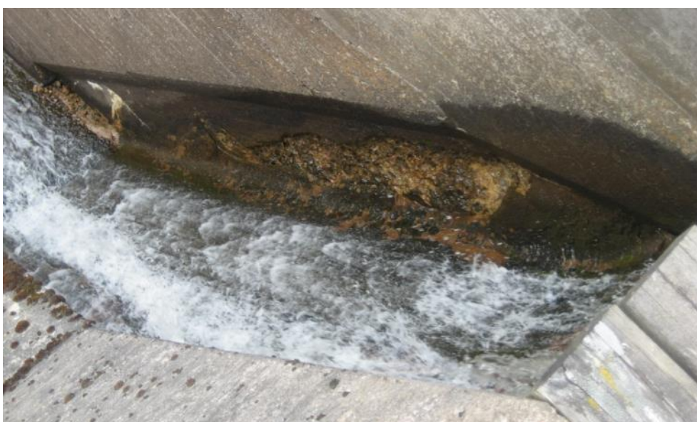
Figur 36. Vid avbördning i utskov 9 blötläggs ursparingen längs pelare 10. Fotografiet togs i maj 2011.
