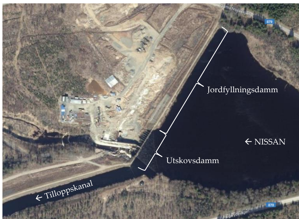
Figur 2. Flygfotografi förevisande läget för den gamla utskovsdammen och anslutande jordfyllningsdammar vid Hylte kraftverk. Flygfotografiet har hämtats från www.hitta.se 2019-09-19.
