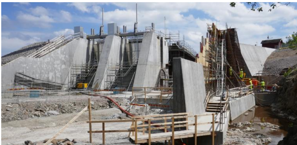
Figur 19. Den nya utskovsdammens nedströmssida i juni 2019. Planluckor har monterats i utskoven 3 och 4.
