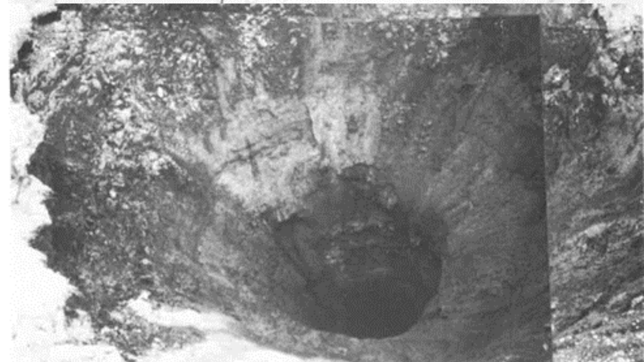
Hultman, Stille, Söder (1993) Ras i kraftverkstunnel, Befo 471:1/93
