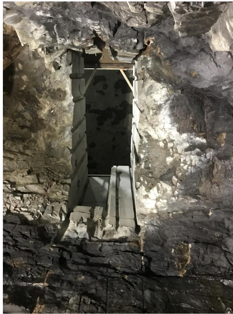
Schaktet fotat från sugrörsbotten G4
