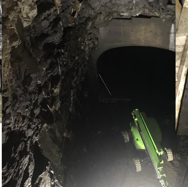
Skrotning, bultning och sprutbetonering av sugröret efter torrläggning
