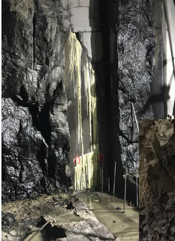
Sågning av falslägen och tröskellägen efter torrläggning. Kompletterande keminjektering har varit nödvändig för att underlätta betongarbeten
