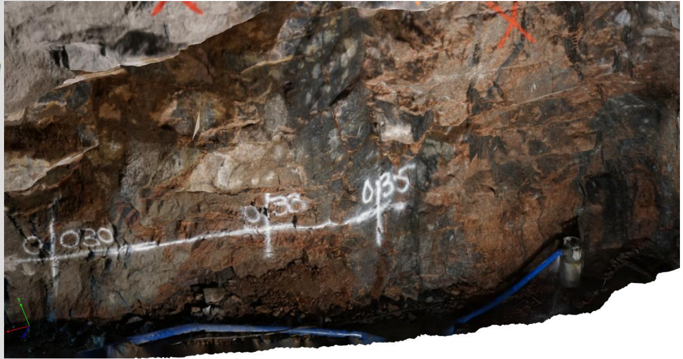
Fotogrammetri i tillfartstunnel
