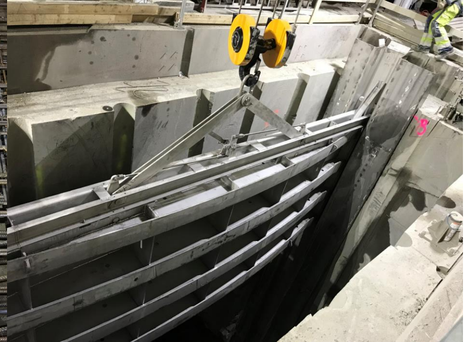
Provning av nya luckor, oktober 2020
