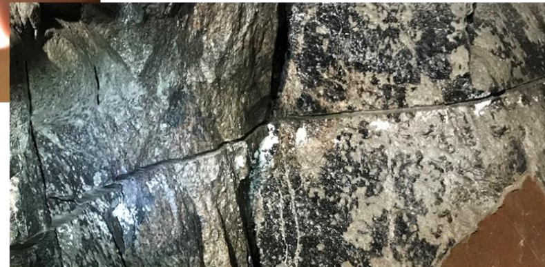
Sågsnitt för tunnelgolvet, någon cm brett
