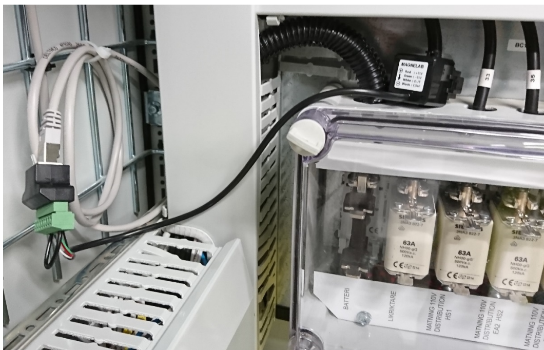
Figur 7: Strömgivare installerad i LS-centralen för mätning av ström från likriktare
