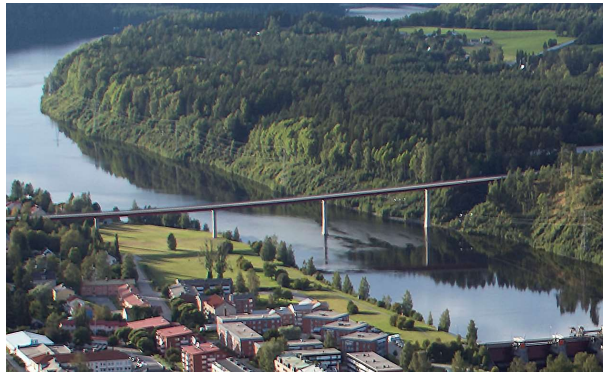
Ångermannabron är en balkbro över Ångermanälven i västra Sollefteå i Västernorrlands län. Bron är en del i riksväg 90 och förbinder stadsdelarna Rödå i söder och Nipan i norr. Bron är 469 meter lång och 35 meter hög och bärs upp av fem betongpelare.
