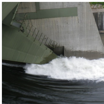
Figur 2.5 Överspolning av lucklager
