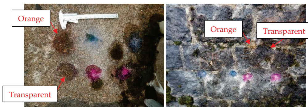
Figur 3-1. Test av pH i betong på horisontell yta t.v. och lutande yta t.h.
