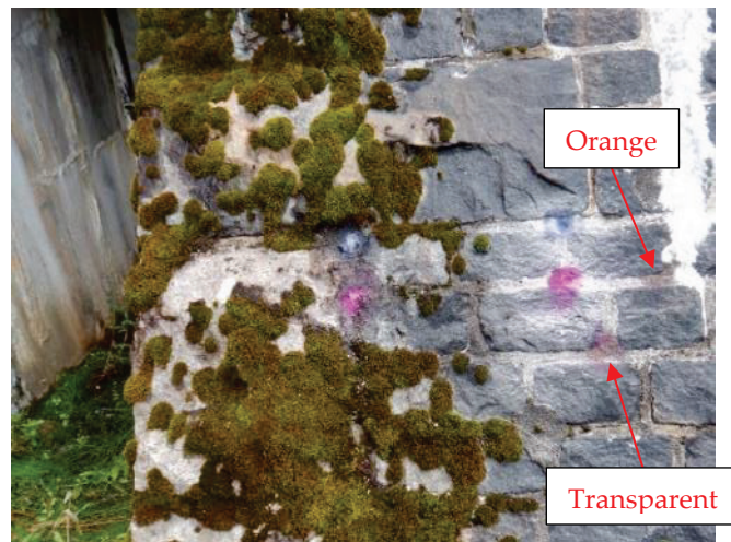
Figur 3-2. Test av pH i betong på lutande yta.
