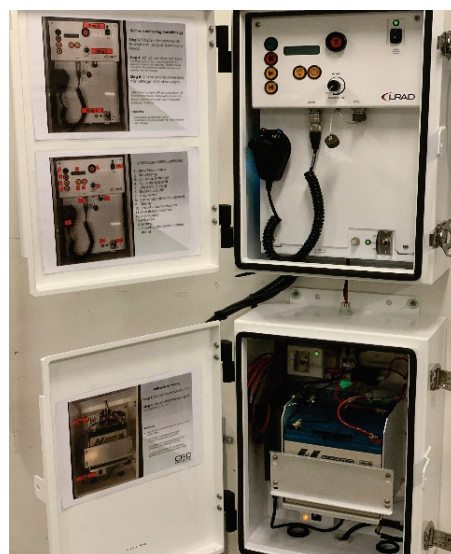
Figur 10. Reservkraft och manöverpanel för manuell drift och aktivering
