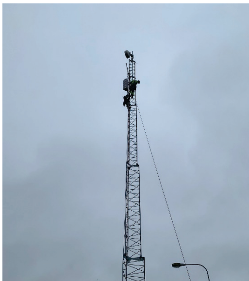
Figur 8. Montering vid Harrsele vattenkraftanläggning
