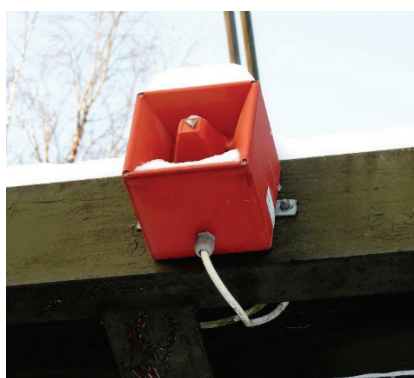
Figur 4. Befintligt ljudhorn vid hängbron
