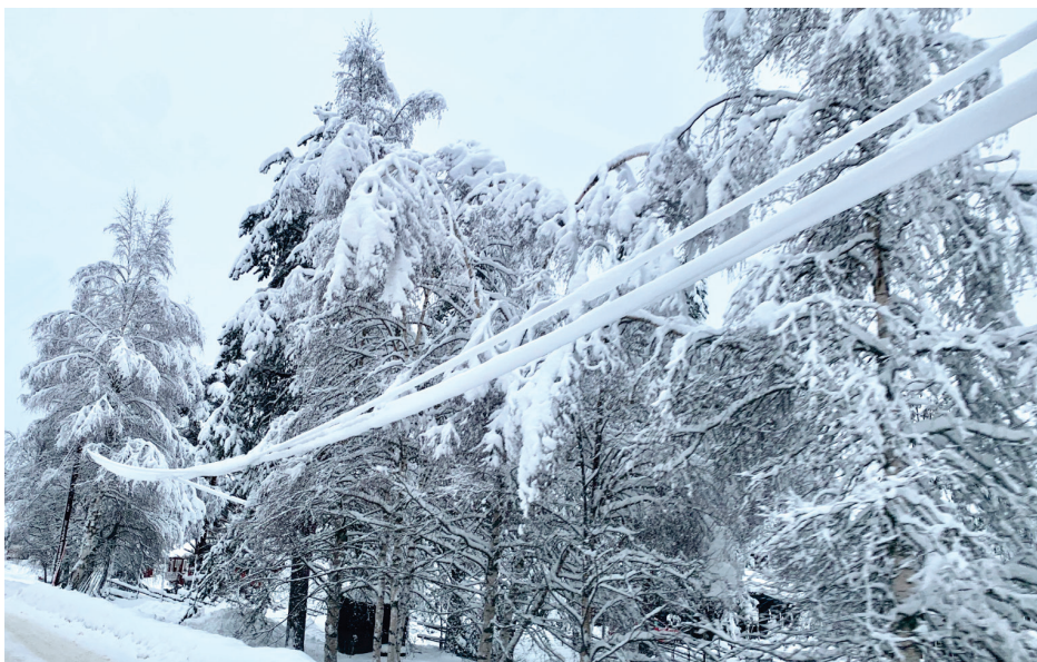
Figur 8: Bild på relativ normal snöpåbyggnad på luftledning och omgivande träd (Foto: Profu).
