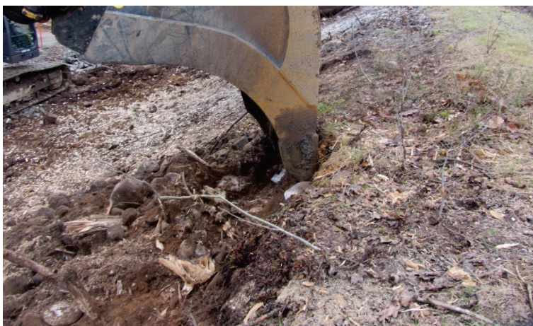
Figur 48 Bortgrävning av lösa rotrester och träflis efter fräsning
