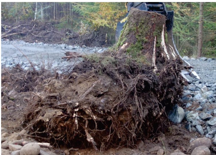
Figur 35 Stubbe från en ek med stamdiameter 55 cm. Eken växte i dammtån. Rotklumpen var ca 1,2 m hög. Utanför själva rotklumpen fanns inga stora rötter.
