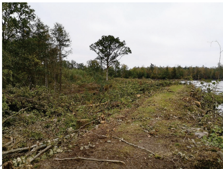
Figur 41 Alla träd på dammen och i dammtån har avverkats
