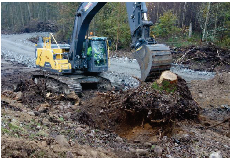
Figur 1 Bortgrävning av en stubbe i dammtån
