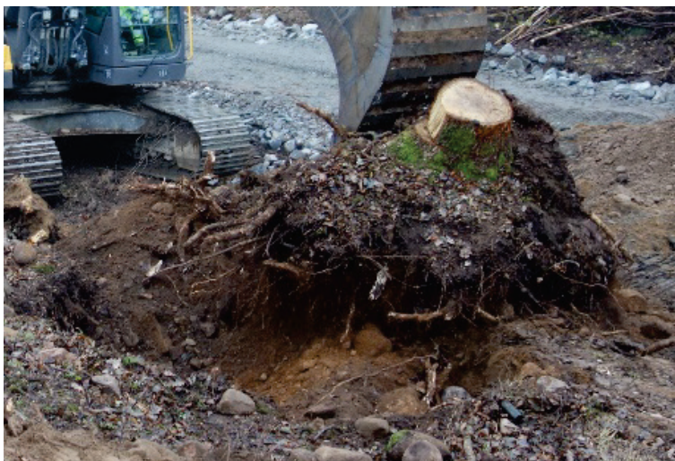
Figur 30 Ekstubbe med rotklump i dammtån. Stamdiameteren var 50 cm.
