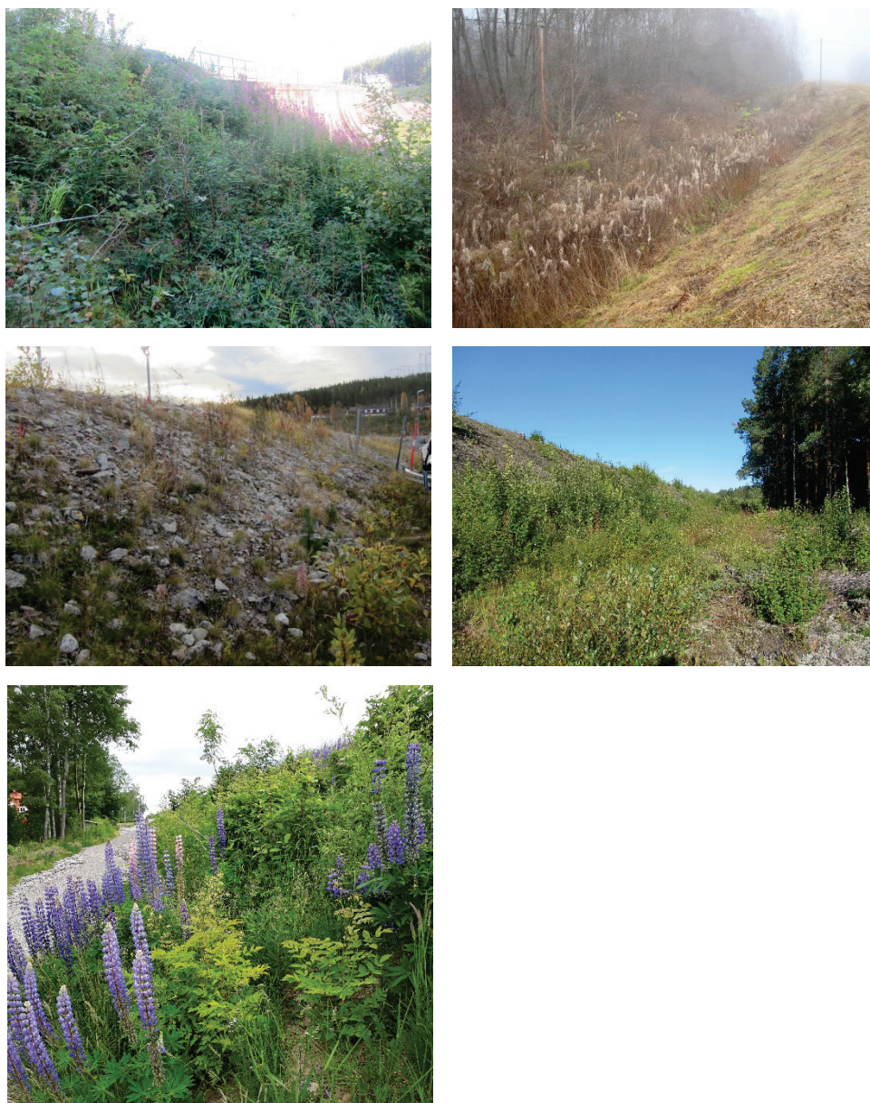
Figur 32 Exempel på svenska dammar bevuxna med buskar och sly i olika omfattning
