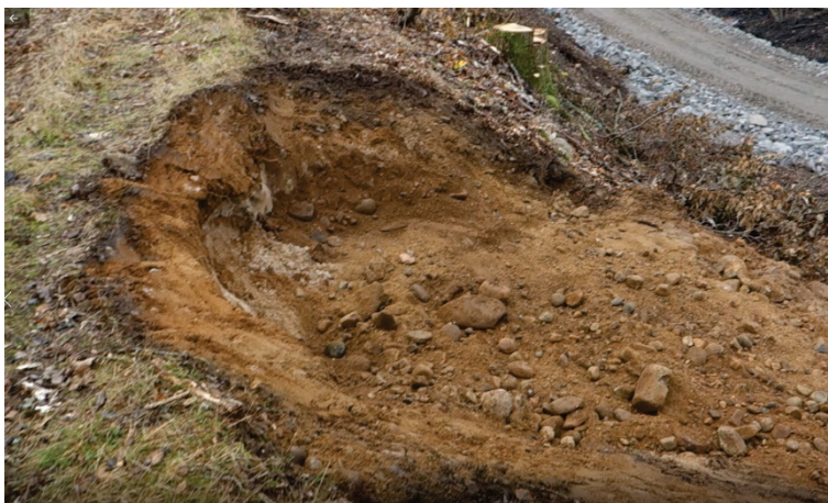
Figur 39 Hål i nedströmsslänten efter stubbrytning. Materialet utgörs av grusig Sand.
