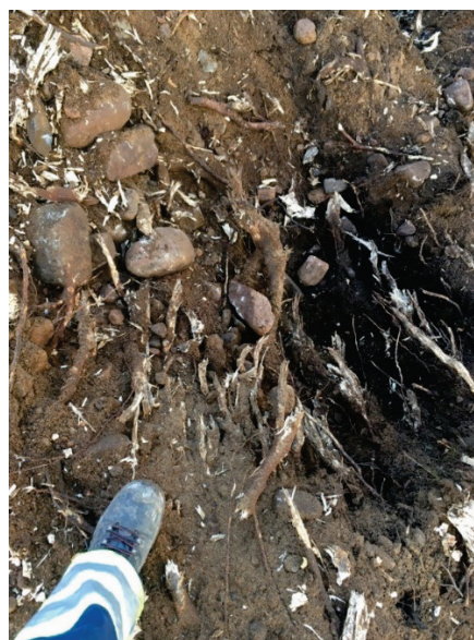
Figur 43 Bokstubbe med stamdiameter 40 cm i uppströmsskanten av dammkrönet. Bilden till höger visar rester efter fräsning av stubben.
