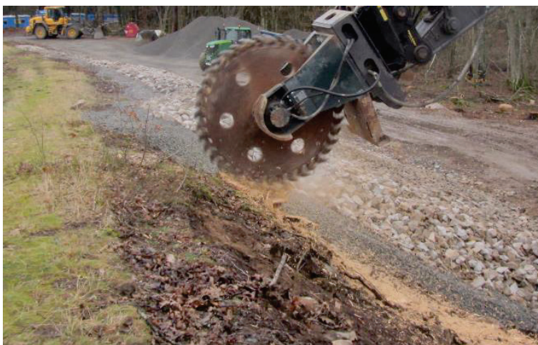
Figur 6 Fräsning av stubbe med bergfräs monterad på grävmaskin
