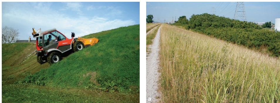
Figur 23 Bilden till vänster visar gräsklippning på en invallningsdamm i Frankrike. Bilden till höger visar en invallningsdamm i USA där inspekterbarheten är begränsad eftersom gräset inte underhållits på rätt sätt (från CIRIA, 2013).
