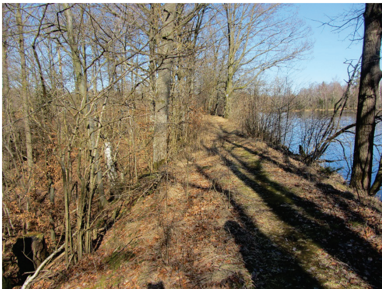
Figur 43 Dammen innan åtgärder
