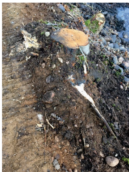
Figur 43 Bokstubbe med stamdiameter 40 cm i uppströmsskanten av dammkrönet. Bilden till höger visar rester efter fräsning av stubben.
