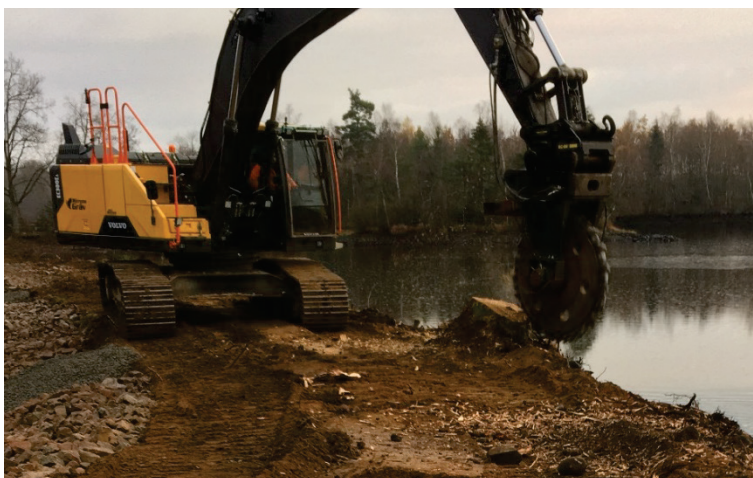
Figur 47 Fräsning av stubbe med bergfräs monterad på grävmaskin
