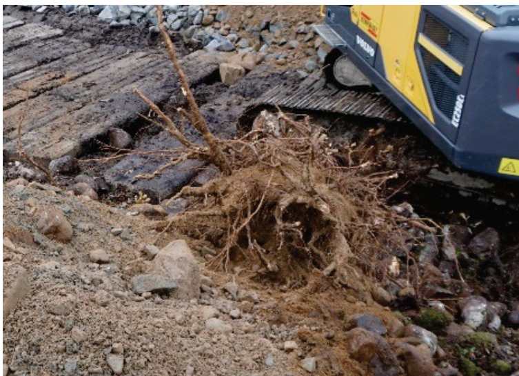
Figur 29 Rotklump till borttagen ekstubbe i dammtån. Stamdiameteren var 50 cm.
