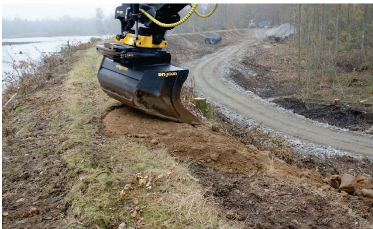
Figur 17 Packning av de återfyllda massorna
