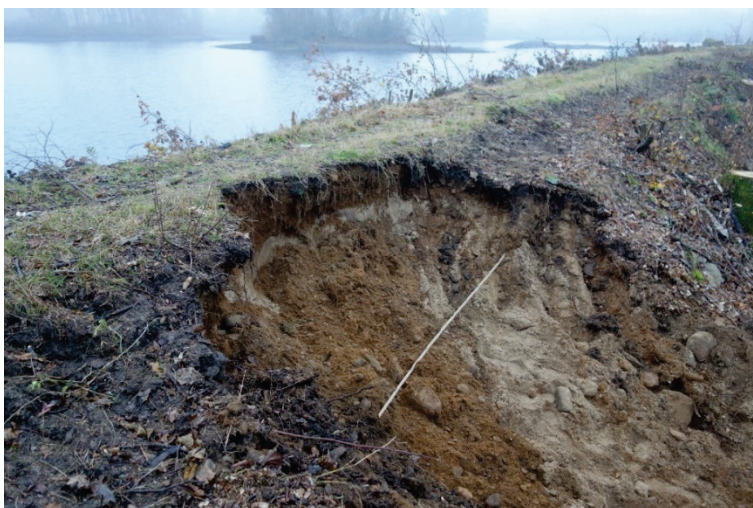
Figur 39 Hål efter uppgrävning av bokstubben i Figur 37. Hålet var 3 x 2 m och ca 1 m djupt.
