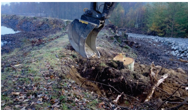
Figur 44 Björkstubbe med stamdiameter 60 cm i nedströmsslänten
