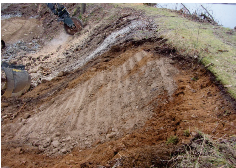
Figur 18 Hål efter stubbrytning i nedströmsslänten återfyllt och färdigpackat
