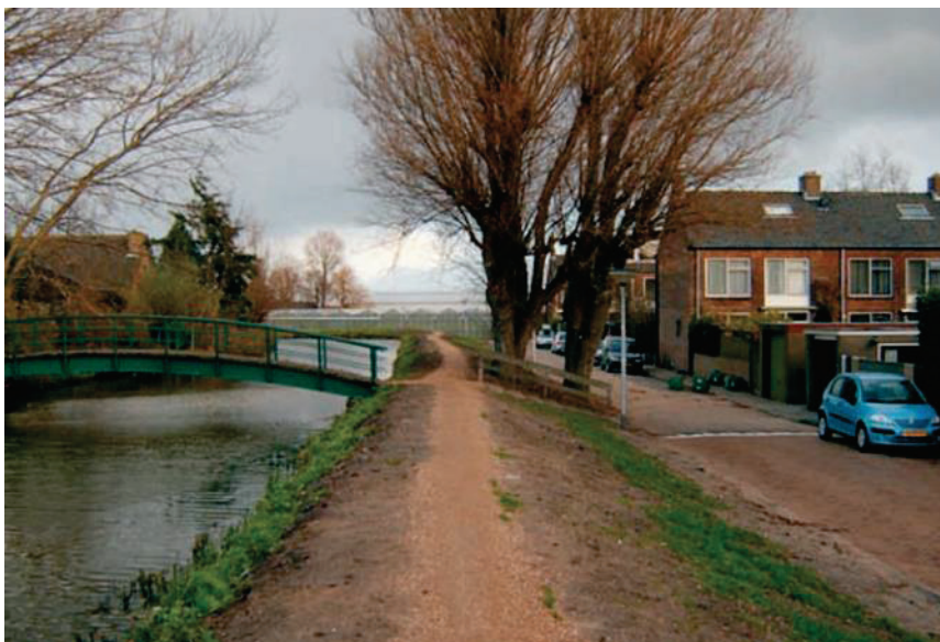
Figur 29 Exempel på träd som bedömts som oacceptabla att ha kvar i dammvallen eftersom kriterierna för att låta träden vara kvar inte uppfylls och trädens influenszon ligger inom dammens minimitvårsnitt (från CIRIA, 2013)
