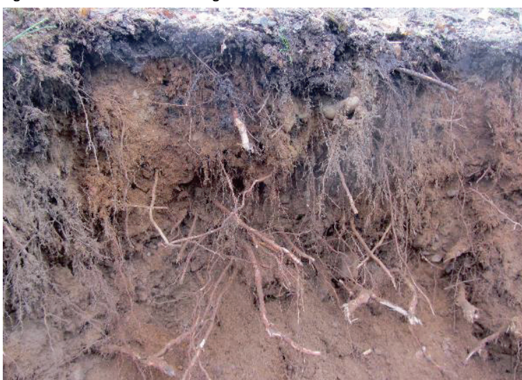
Figur 9 Rötter med diameter <1 cm lämnades kvar i dammen
