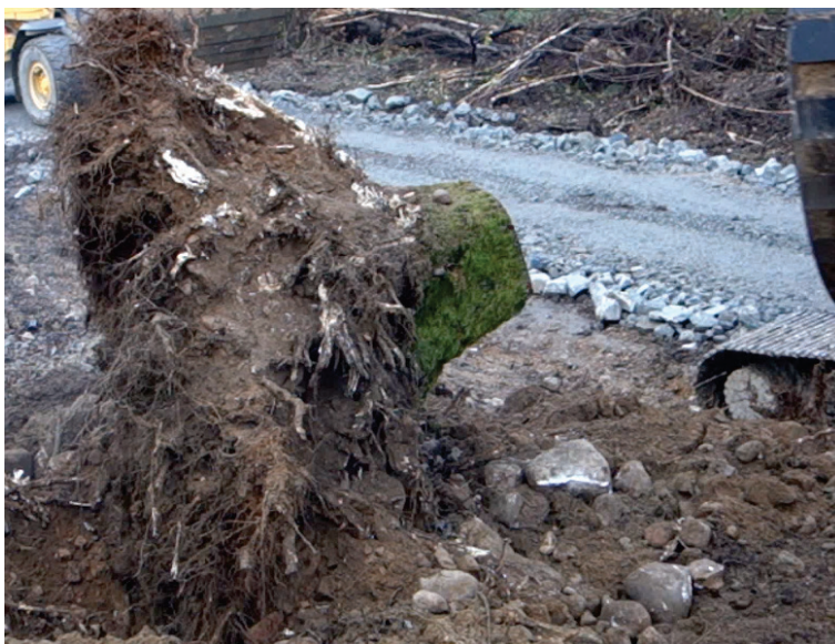
Figur 32 Rotklump från ek i dammtån med stamdiameter 55 cm
