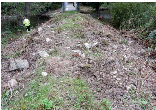
Figur 13 Damm i södra Sverige där vildsvin bökat upp såväl krön som uppströmsslänt och nedströmsslänt
