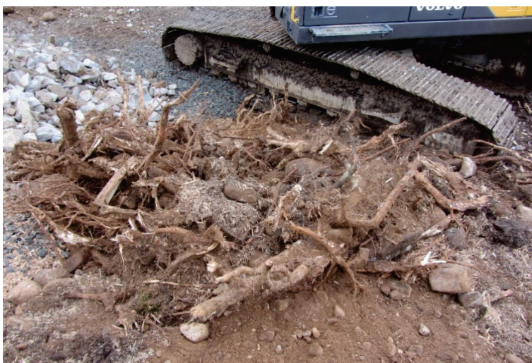
Figur 8 Lösa rotrester efter fräsning
