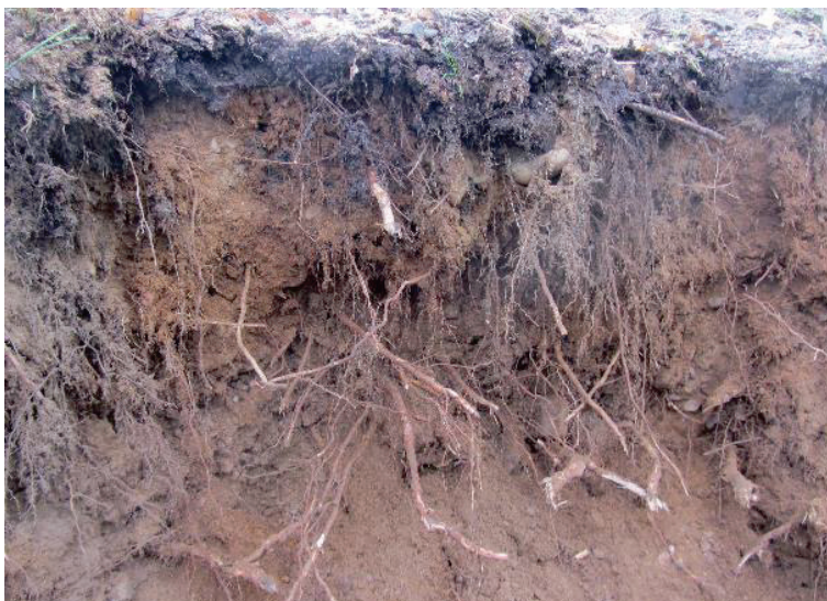
Figur 49 Rötter med diameter <1 cm lämnades kvar i dammen
