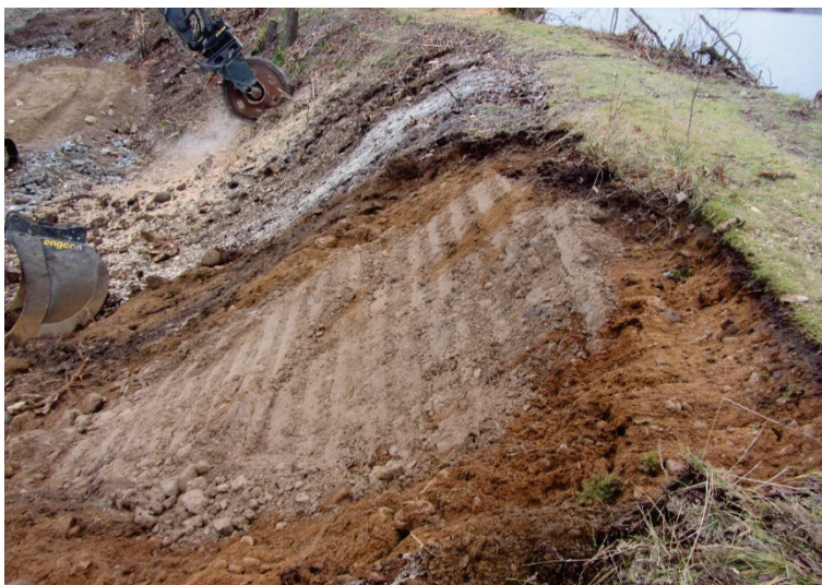
Figur 52 Hål efter stubbrytning i nedströmsslänten återfyllt och färdigpackat
