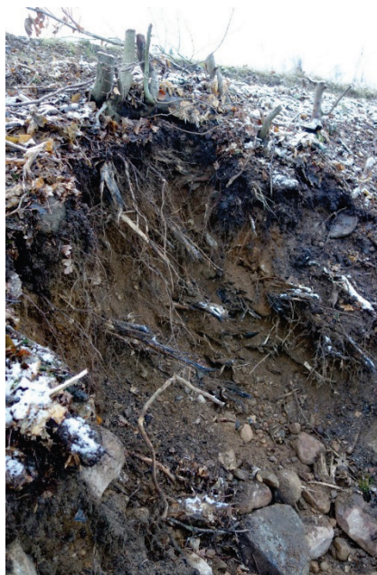
Figur 11 Hål efter stubbfräsning i nedströmsslätten. Några enstaka rötter med stamdiameter >1 cm lämnades kvar där det bedömdes som större risk att ta bort dem än att låta dem vara kvar. På vänstra bilden en rot med diameter 5 cm som går in i dammen i riktning uppströmsåt.
