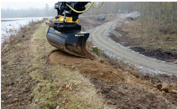
Figur 51 Packning av de återfyllda massorna
