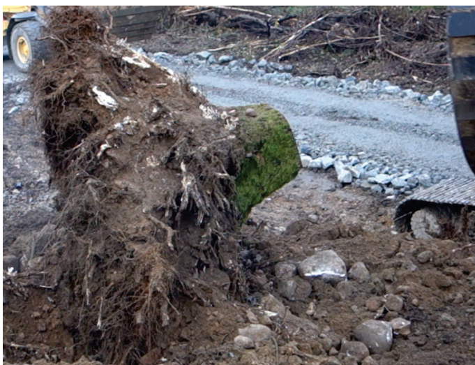
Figur 56 Rotklump från ek i dammtån med stamdiameter 55 cm
