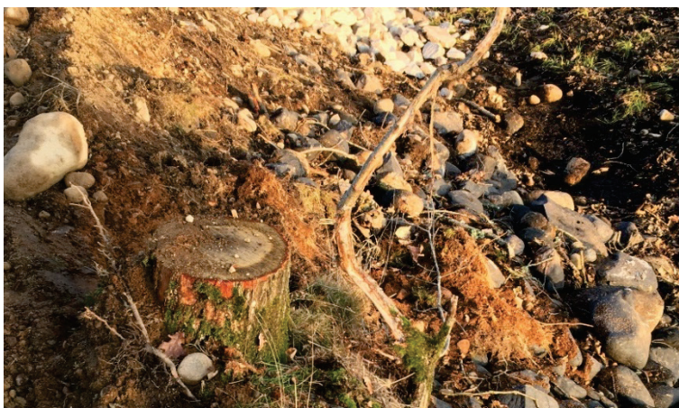
Figur 33 Ekstubble med stamdiameter 40 cm i uppströmsslänten
