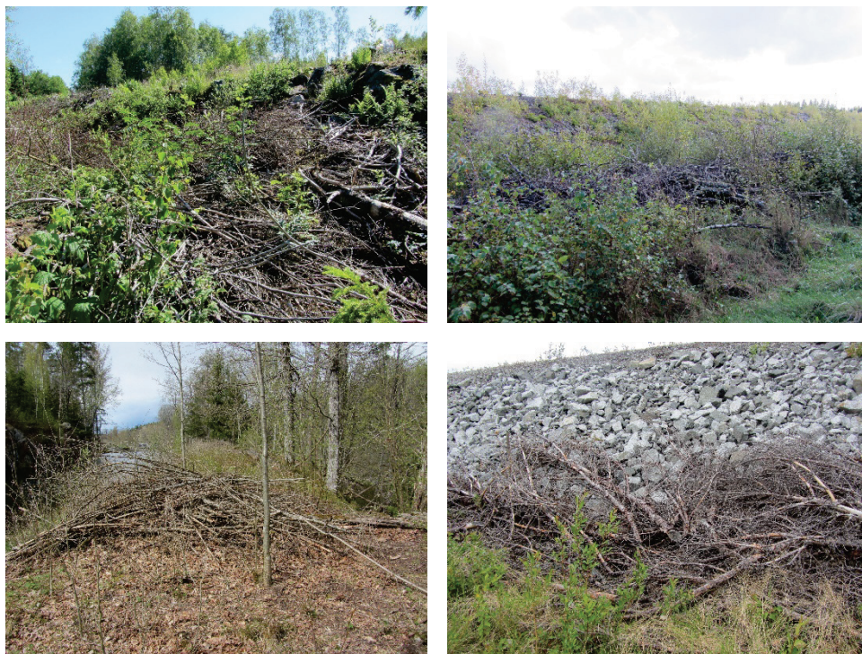
Figur 36 Exempel på dammar där gammalt ris från röjning lämnats kvar på dammen
