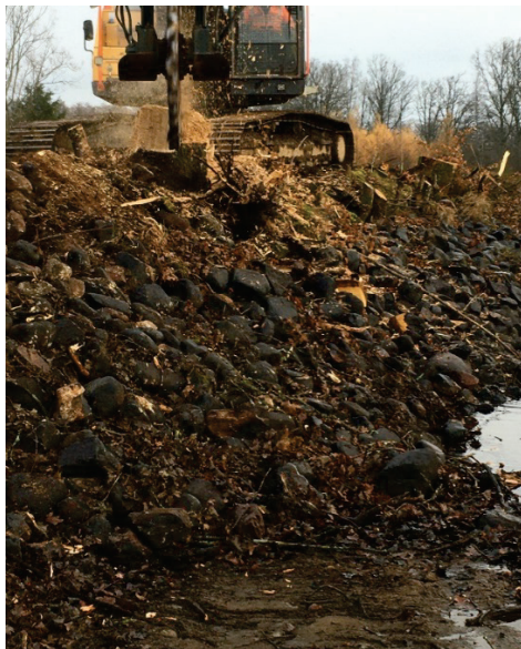
Figur 13 Fräsning av stubbar i uppströmsslänten
