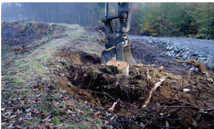
Figur 2 Bortgrävning av en stubbe i nedströmsslätten där dammen är som lägst
