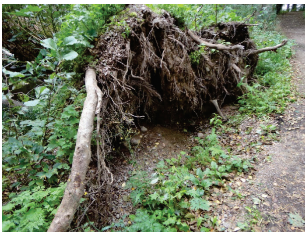
Figur 11 Omkullvält träd i uppströmsslänten på en damm i södra Sverige
