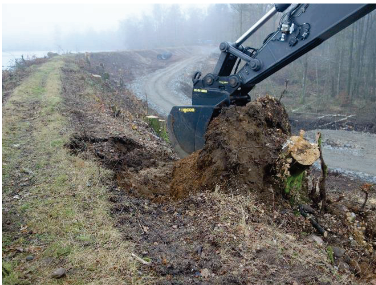
Figur 45 Bortgrävning av en stubbe i nedströmsslänten
