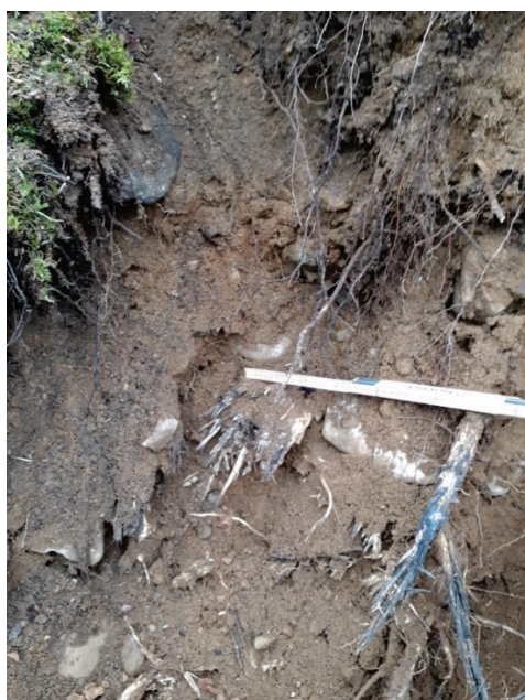
Figur 11 Hål efter stubbfräsning i nedströmsslätten. Några enstaka rötter med stamdiameter >1 cm lämnades kvar där det bedömdes som större risk att ta bort dem än att låta dem vara kvar. På vänstra bilden en rot med diameter 5 cm som går in i dammen i riktning uppströmsåt.
