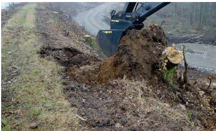
Figur 3 Bortgrävning av en stubbe i nedströmsslätten
