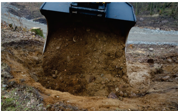
Figur 16 Återfyllning av hål med moränmassor
