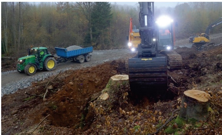
Figur 25 Bortgrävning av ekstubben i Figur 24
