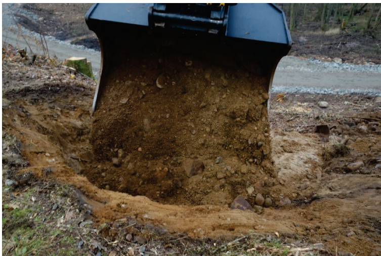
Figur 50 Återfyllning av hål med moränmassor
