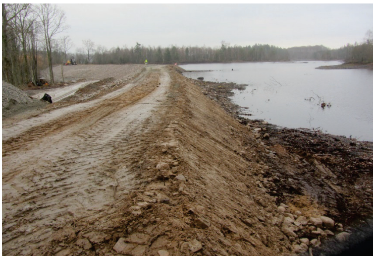
Figur 20 Uppströmsslänten är justerad med moränmassor efter stubbrytning
