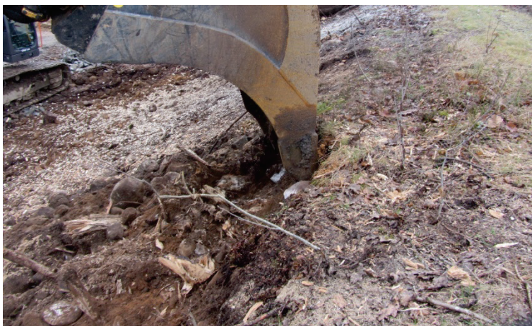
Figur 7 Bortgrävning av lösa rotrester och träflis efter fräsning
