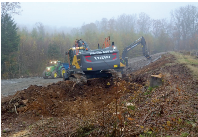
Figur 27 Hål efter bortgrävning av ekstubben i Figur 24. Hålet var 4 m i diameter och 1,3 m djupt.
