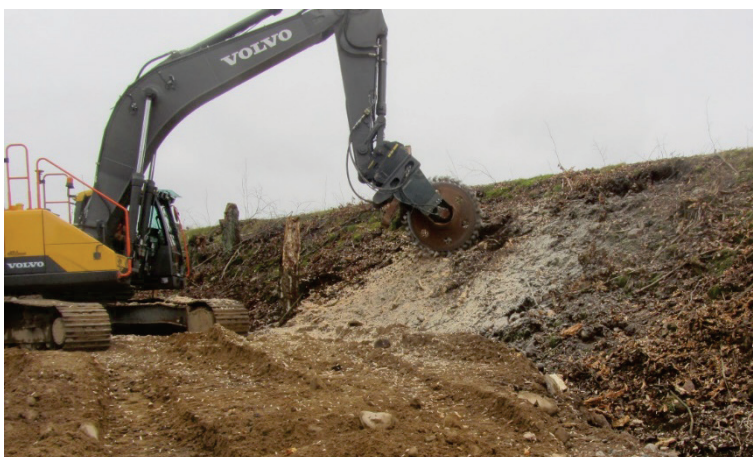
Figur 5 Fräsning av stubbar i nedströmsslänten har påbörjats
