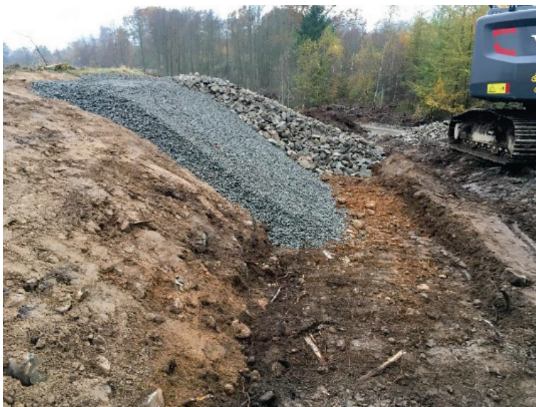
Figur 42 Utläggning av övergångslager och stödbank
