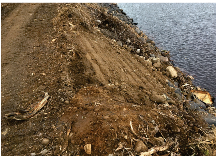
Figur 19 Hål efter stubbrytning i uppströmsslänten återfyllt
