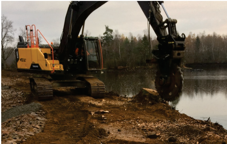
Figur 12 Fräsning av stubbe i uppströmsslänten
