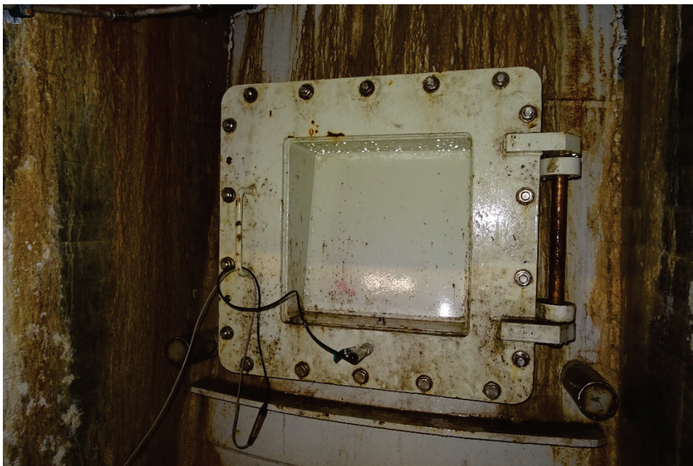
Figur 10 Montage av tryckgivare för sugrörstrycket, Gulsele aggregat 3.
