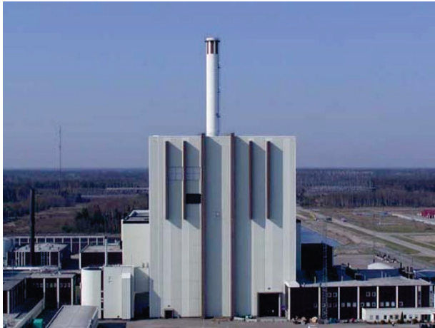
Figur 1-3 Foto på Formark II, foto Tommy Halvarsson, https://sv.wikipedia.org/wiki/Forsmarks_k%C3%A4rnkraftverk#/media/Fil:Forsmark.jpg
