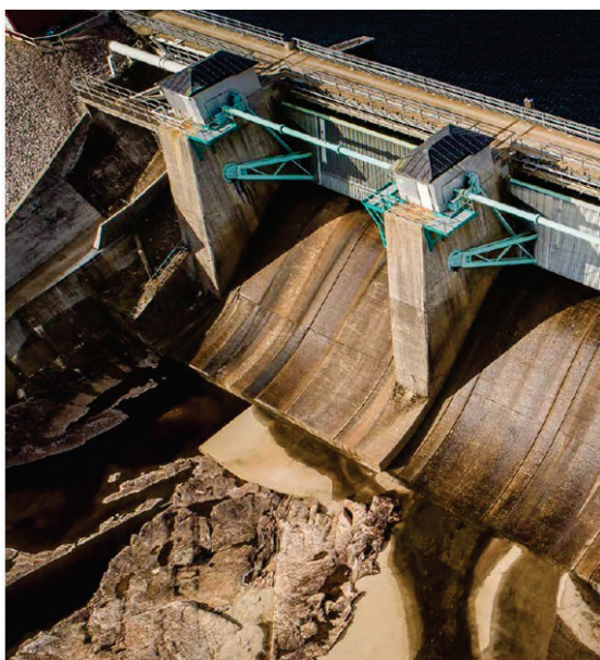
Figur 6 Den avbördande funktionen hos en damm utgörs av anläggningsdelar (utskov) för att släppa vatten genom eller förbi en anläggning. Foto: SvK.
