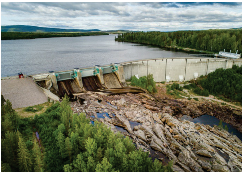
Figur 5 Den dämmande funktionen hos en damm utgörs av olika typer av dammkonstruktioner med syfte att koncentrera fallhöjd och/eller att magasinera vatten. Foto: SvK.
