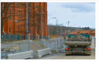
Digitalisering av byggarbetsplatser
