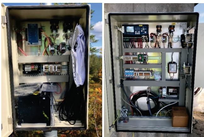
Figur 15. Innehåll på HydMet-skåp med batteridrivna och kraftdrivna loggar.
