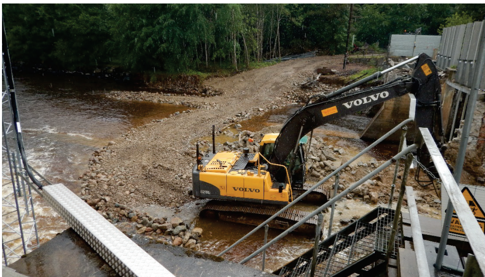
Figur 3.6. Översiktsfoto. Vy över pågående rivningsarbete på dammens nedströmssida (2020-06-30).
