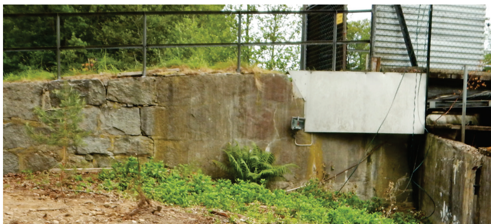
Figur 3.39. Höger dammanslutning. Utseendet hos dammanslutningen mellan fisktrappan (till höger i bild) och naturlig mark. Även här utgörs dammen av en murverkskonstruktion som har försetts med ett skikt av puts eller sprutbetong. Notera att de synliga stenarna är av större dimension jämfört med i pelarna (2020-06-17).
