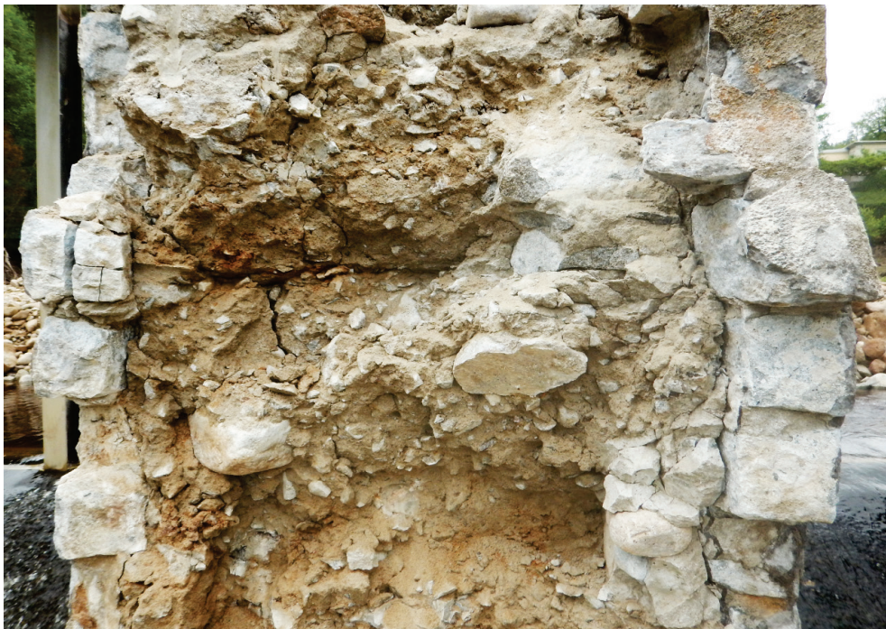
Figur 3.24. Pelare 3. Ett tvärsnitt av pelaren med yttre skalmur och inre jordliknande material (2020-06-30).
