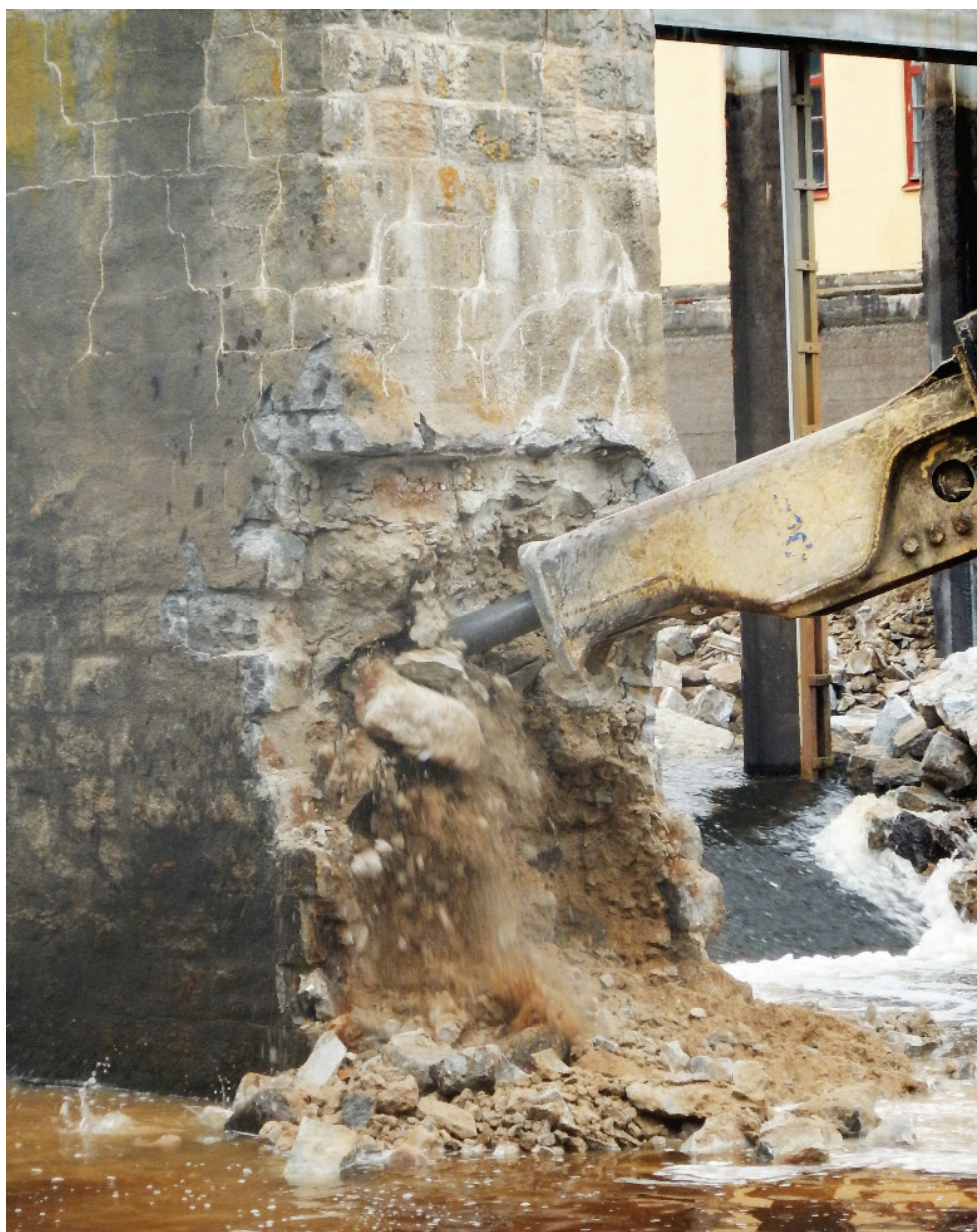
Figur 3.22. Pelare 3. I fotografiet syns pelarens nedströmssida strax efter att rivningen påbörjats (2020-06-30).
