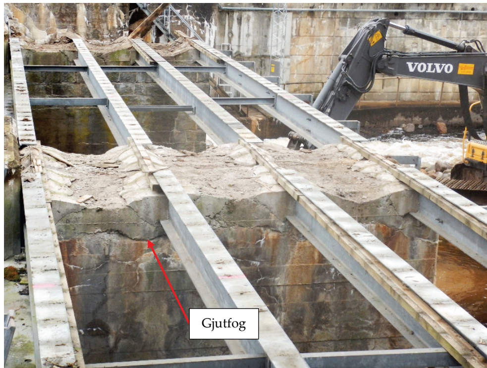
Figur 3.51. Pelare 4. Brobanan bärs upp av stålbeams av I-profil, vilka hade fixerats med betong. I bakgrunden syns pelare 3 där motsvarande pågjutning hade gjorts på murverket för att fixera stålbeamsarna (2020-06-30).
