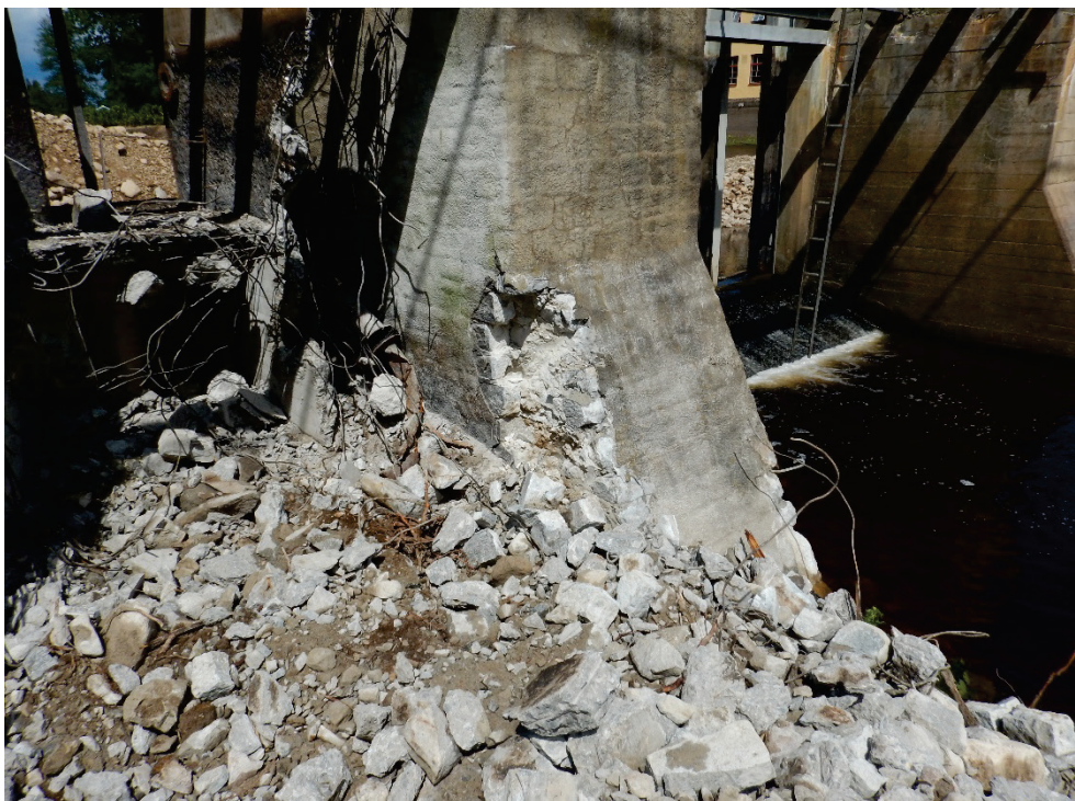
Figur 3.35. Pelare 5. Kontroll av pelarens uppbyggnad gjordes vid fisktrappans utrivning (2020-06-30).
