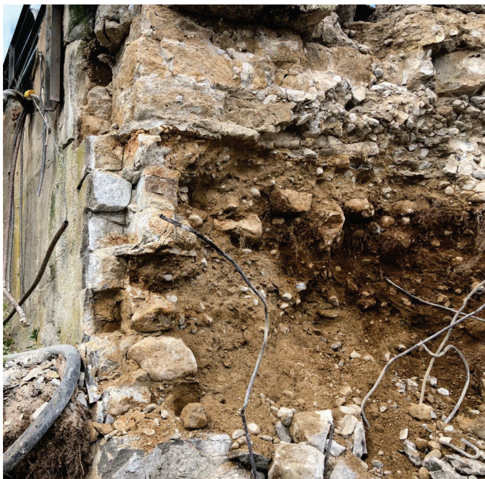
Figur 3.45. Höger dammanslutning. Nedströms övre hörn. På nedströmssidan syns det tunna skiktet av puts eller sprutbetong. Bakom detta skikt återfinns skalmuren av huggen sten. Notera att det finns två lager med sten jämfört med ett lager på uppströmssidan (Figur 3.44). Foto F Lundblad (2020-07-02).
