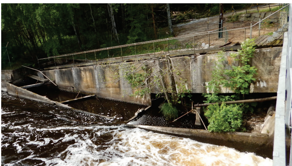
Figur 2.10. Vänster sida av fisktrappans övre del utmed höger strand (2020-06-17).
