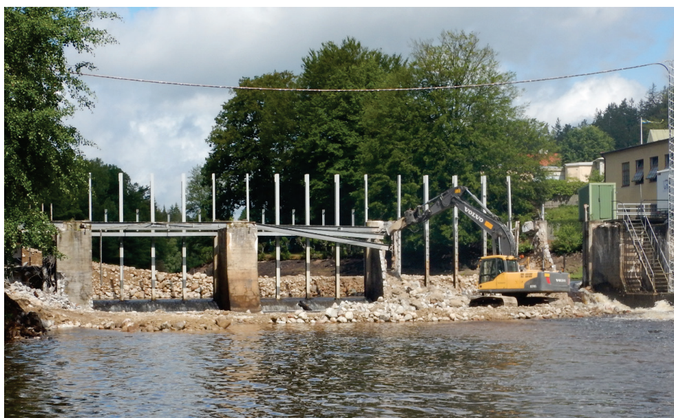
Figur 3.5. Översiktsfoto. Nedströmsvy av dammen under rivningsarbetet (2020-06-30).
