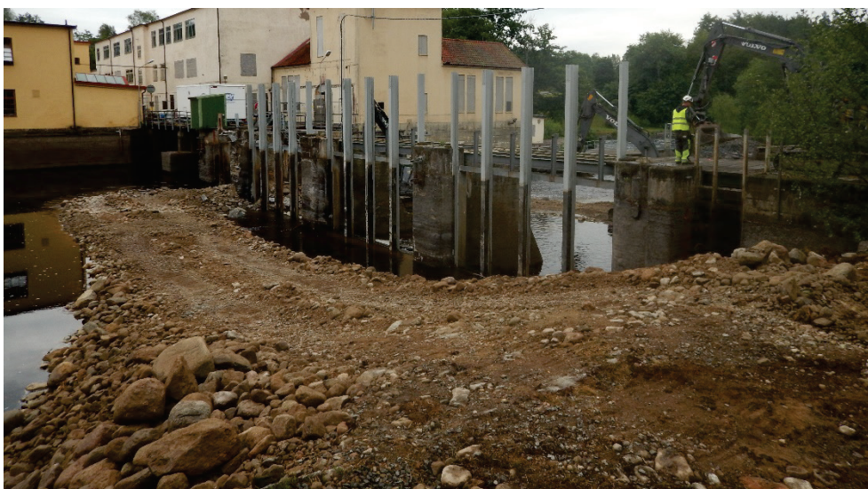
Figur 3.7. Översiktsfoto. Tillfällig fångdamm på uppströmssidan under rivningsarbetet (2020-06-30).
