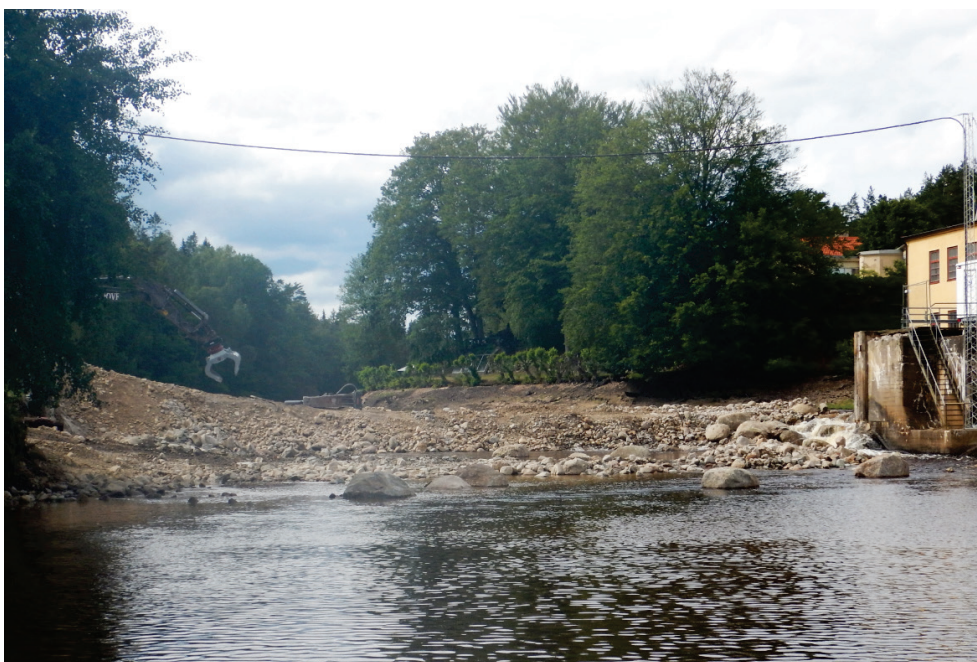
Figur 3.9. Översiktsfoto. Vy över av dammens läge strax efter att rivningsarbetet avslutats (2020-07-03).
