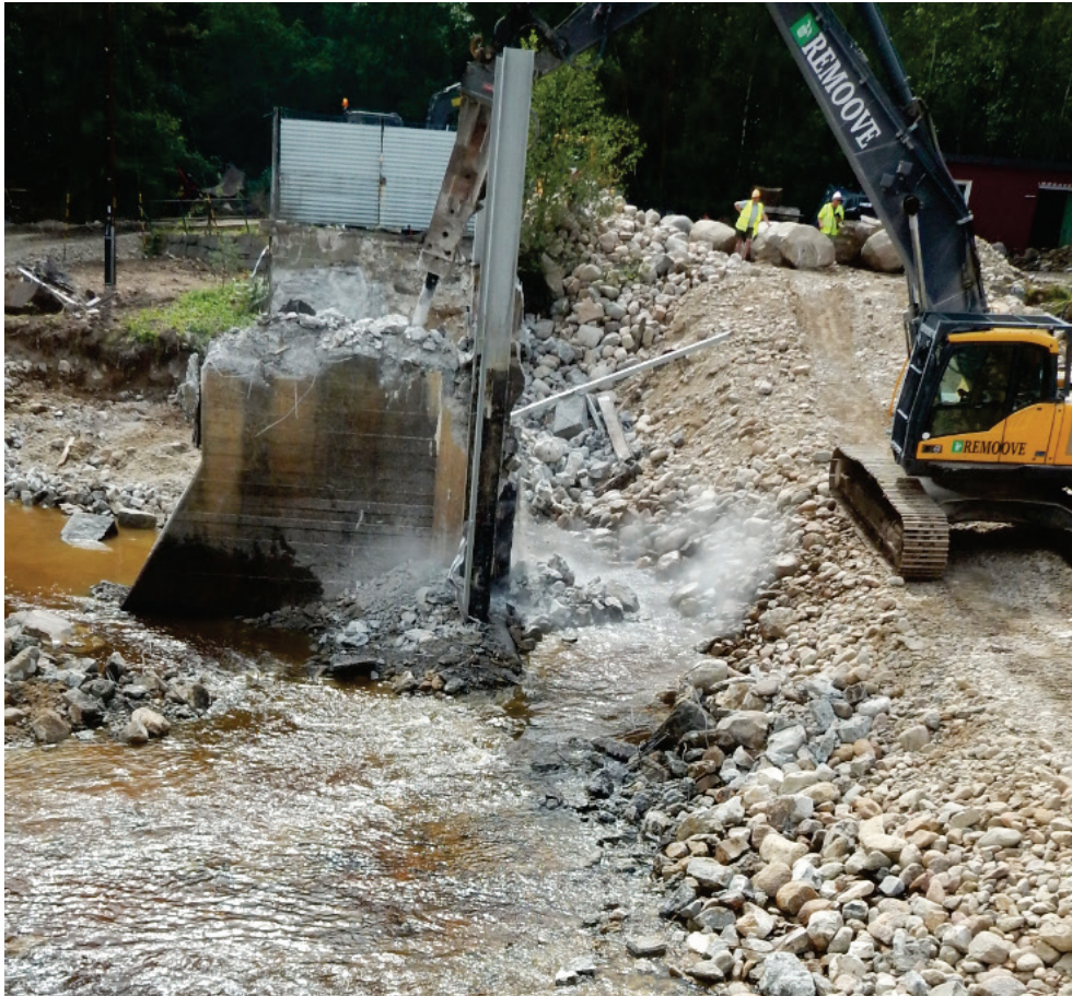
Figur 3.32. Pelare 4. I avvaktan på kraftigare utrustning hann övriga delar av dammen rivas ut (2020-07-01).
