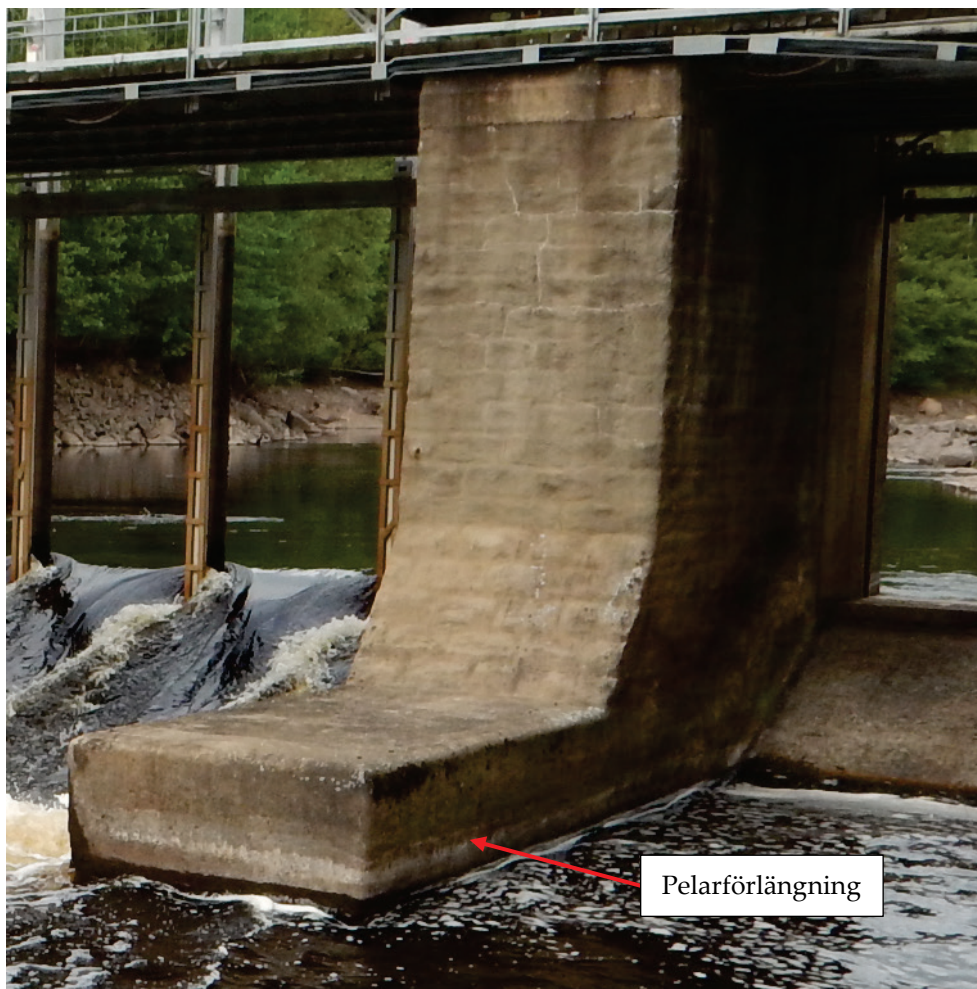
Figur 3.13. Pelare 2. I fotografiet syns pelarens vänstra sida och nedströmssida (2020-06-17).
