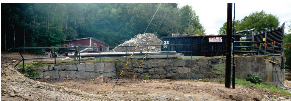
Figur 3.42. Höger dammanslutning. I bild syns den del av dammanslutningen som inte revs ut (2020-07-03).
