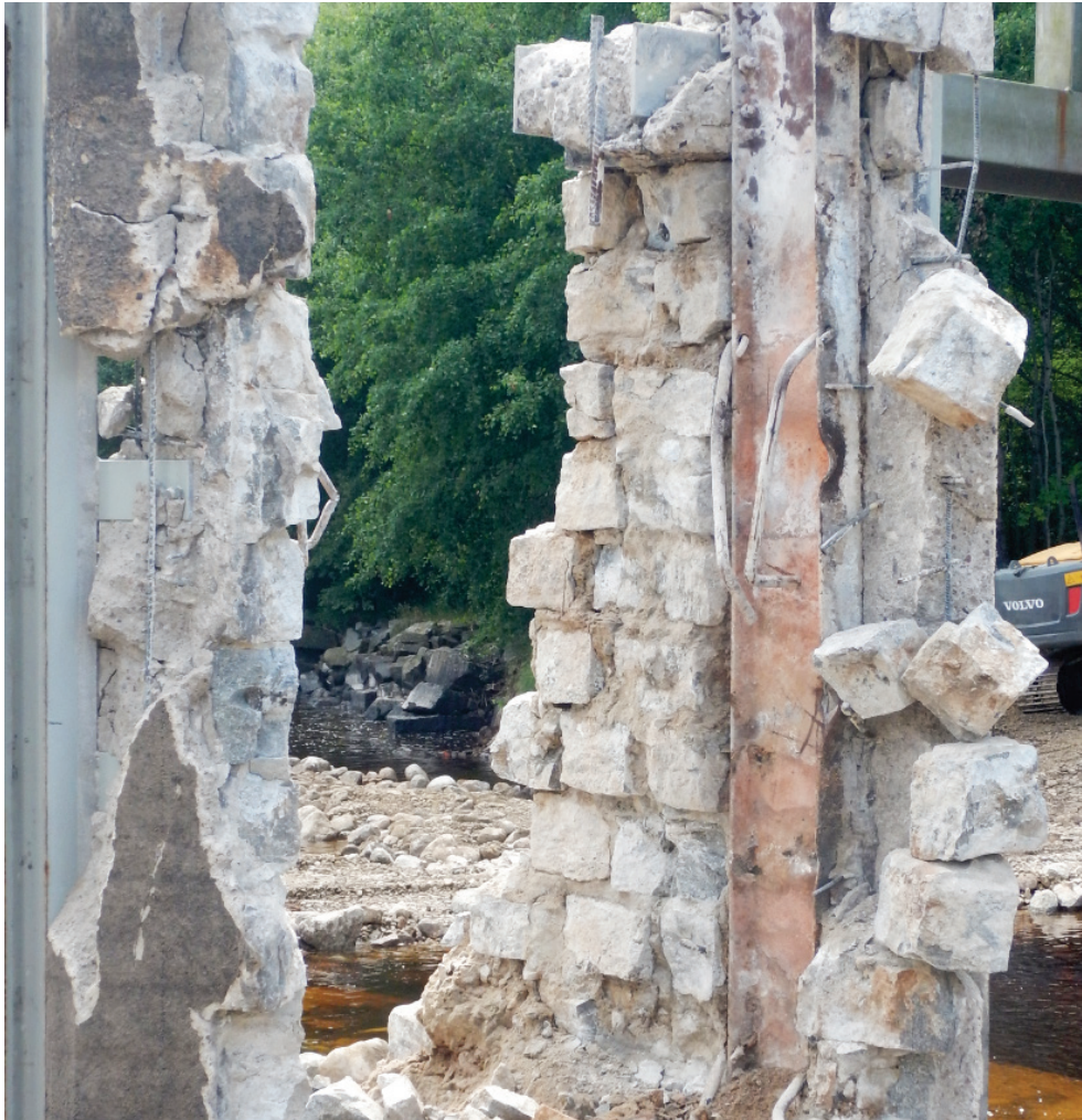
Figur 3.28. Pelare 3. Insidan av pelarens skalmur syns tillsammans med den inre U-balken (2020-06-30).
