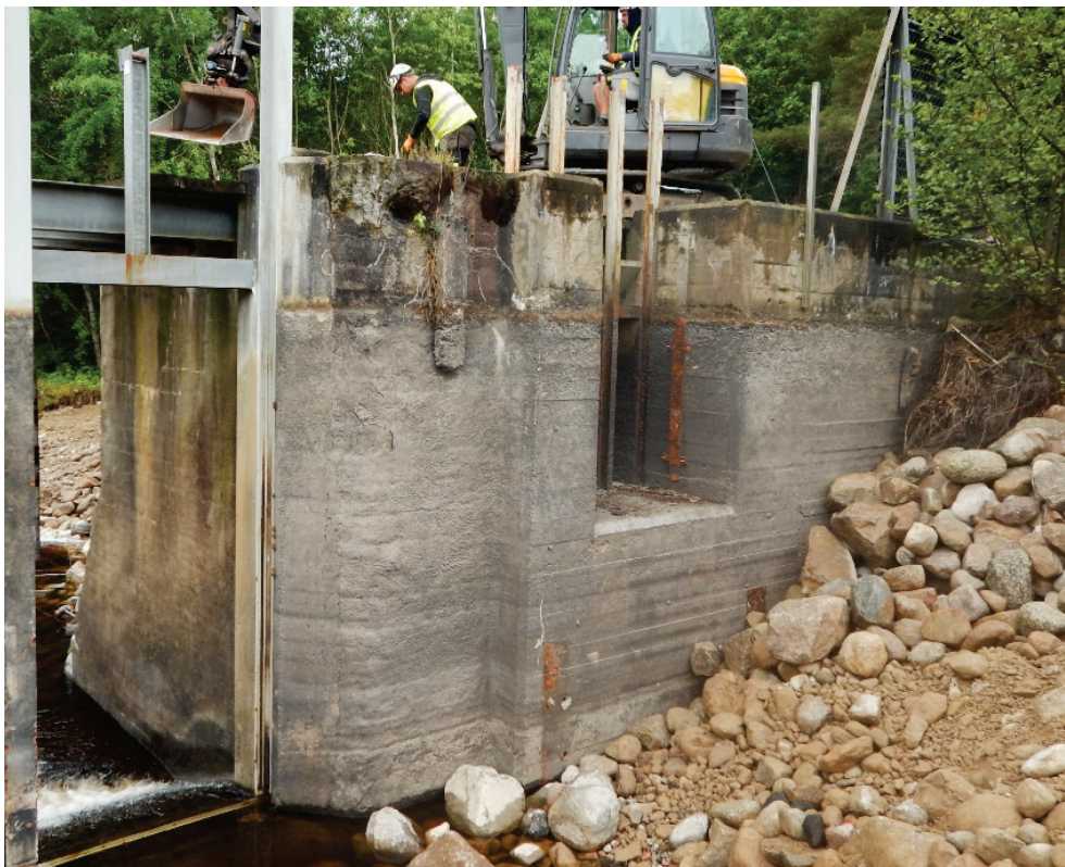
Figur 3.36. Pelare 5. I fotografiet syns uppströmssidan till pelare 5, intaget till fisktrappan och anslutningen in i höger strand. Notera att pelaren är täckt med puts/sprutbetong medan konstruktionerna till höger visar spår efter formplank. Uppströmssidan för dessa delar är även något förskjuten i riktning uppströms (2020-06-30).
