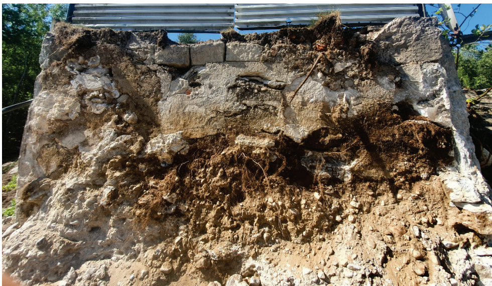
Figur 3.43. Höger dammanslutning. Utseende efter avslutad rivningsentreprenad (2020-08-04).
