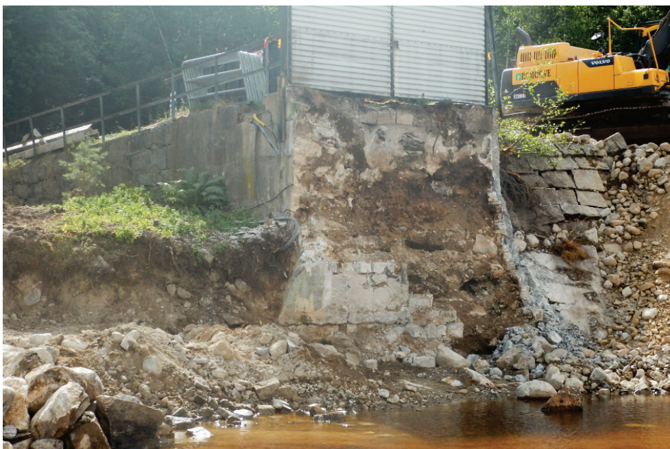
Figur 3.41. Höger dammanslutning. Utrivning av dammanslutningen utfördes till strandlinjen (2020-07-03).
