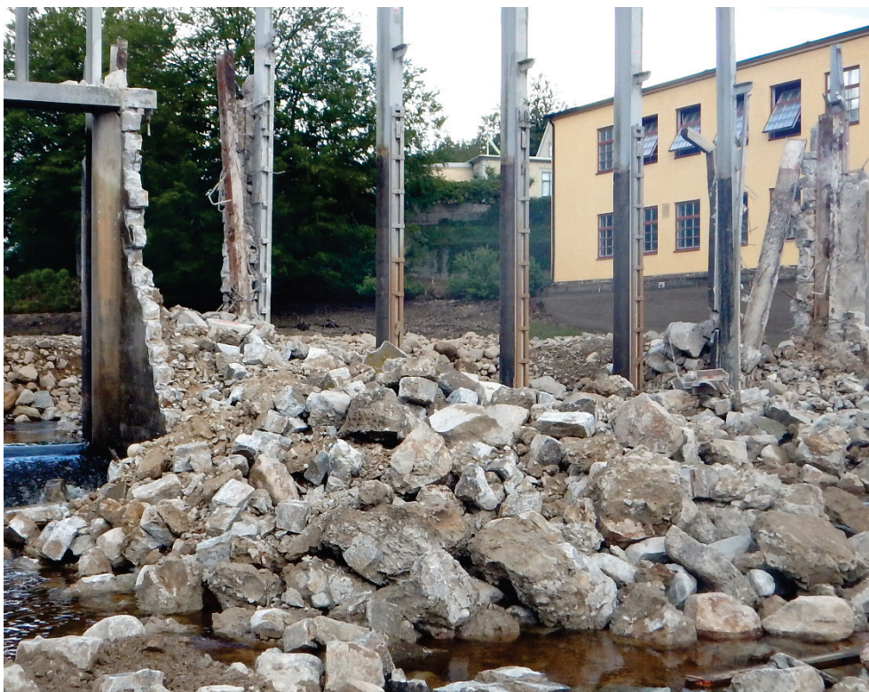
Figur 3.26. Pelare 3. Rivningsmassor när större delen av pelaren har rivits ut (2020-06-30).
