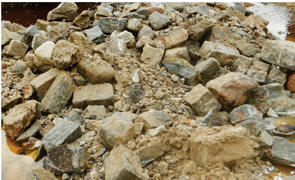
Figur 3.25. Pelare 3. Närbild på rivningsmassor strax efter att rivningsarbetet har påbörjats (2020-06-30).
