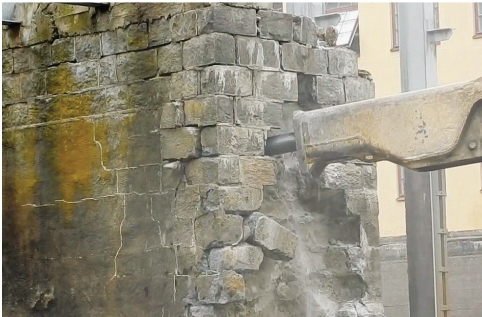
Figur 3.23. Pelare 3. Rivningsmaskinens hydraulhammare spräcker med lätthet upp skalmuren (2020-06-30).
