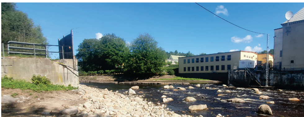
Figur 3.11. Översiktsfoto. Notera den kvarlämnade delen av betongdammen på höger sida (2020-08-04).
