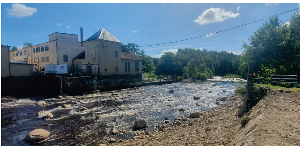
Figur 3.12. Översiktsfoto. Vy nedströms som visar dammens före detta läge (2020-08-04).
