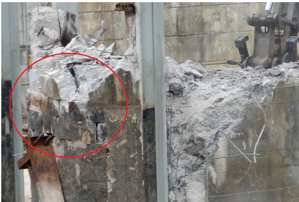
Figur 3.33. Pelare 4. Huggen sten kunde noteras i de övre delarna av pelarens uppströmssida (2020-07-01).
