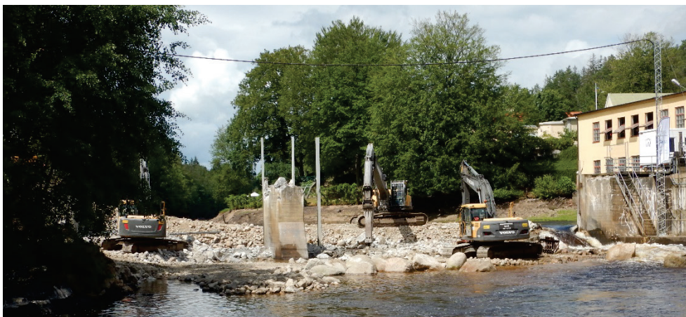
Figur 3.8. Översiktsfoto. Vy över pågående rivningsarbete. Notera att pelare 4 ej rivits ut än (2020-07-01).
