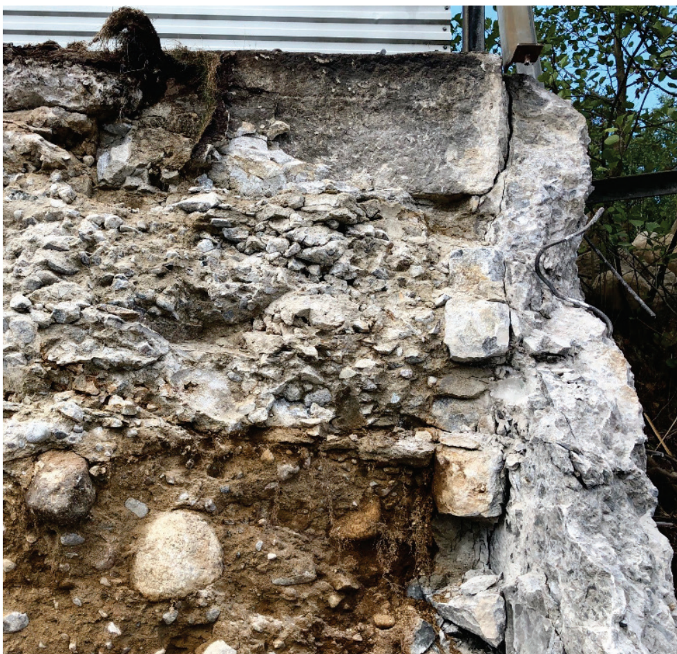
Figur 3.44. Höger dammanslutning. Uppströms övre hörn. Till höger i bild syns en pågjutning av konventionell betong utanför skalmuren av huggen sten. Innanför skalmuren syns en betongplatta överst, därunder en mager betong och underst ett jordliknande material. Foto F. Lundblad (2020-07-02).
