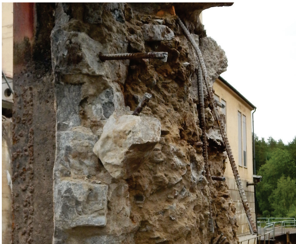
Figur 3.16. Pelare 2. Närbild på skalet av huggen sten, samt förekommande armeringsjärn (2020-06-30).
