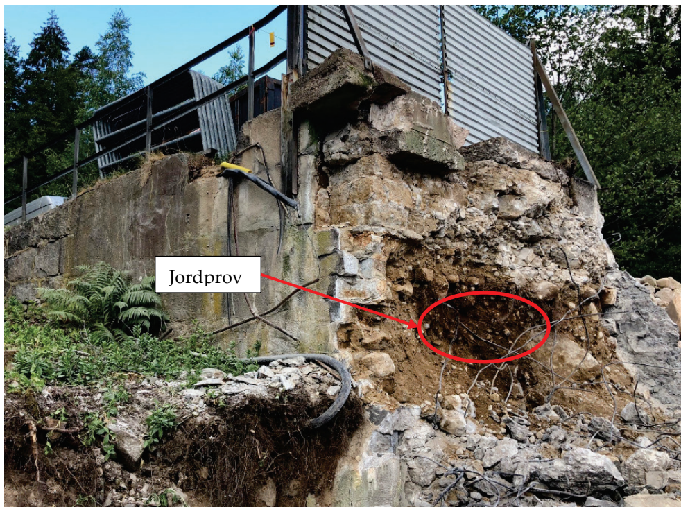
Figur 3.47. Höger dammanslutning. Röd cirkel markerar platsen för jordprovet. Foto F Lundblad (2020-07-02).
