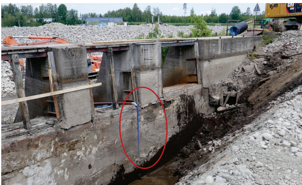
Figur 2. Betongblockens ungefärliga position i betongdammen markeras av den röda ringen centralt i bilden.
