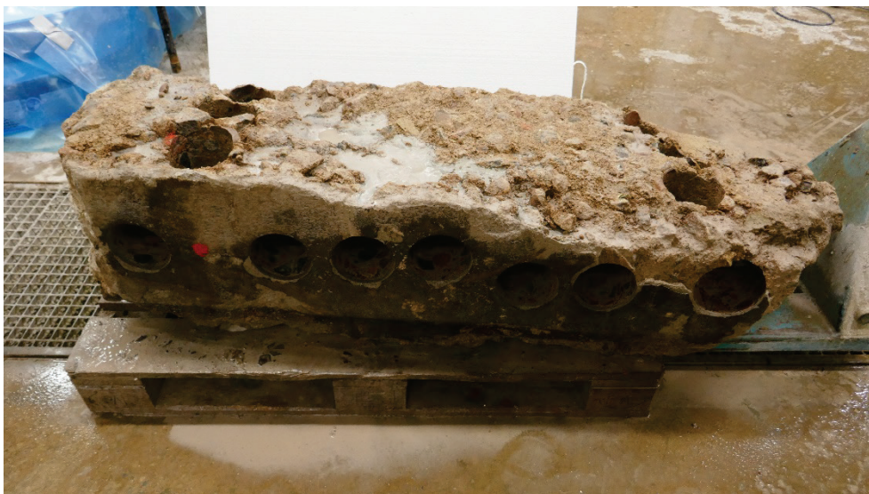
Figur 4. Betongblock med borrhål efter huvudsakligen horisontella borrhärnor.
