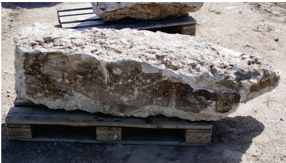
Figur 1. Block som togs ut från Hylte betongdamm i samband med rivningen under 2019. Den ljusa överytan var orienterad som en horisontell gjutfog i betongdammen. Ytan närmast i bild var del av dammens uppströmssida med ett putsskikt ytterst.
