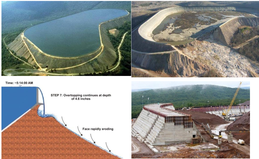
Figur 3-7 Taum Sauk Dam före och efter dammbrottet 2005. Nedre raden illustration av överströmning och en fullständig ombyggnad med en damm uppbyggd med vältbetong.
