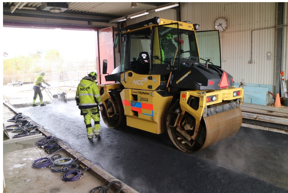
Utläggning bundet bärlager
