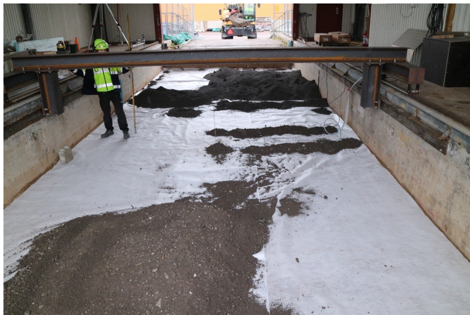
Utläggning slagggrus (Sysav och Umeå Energi)
