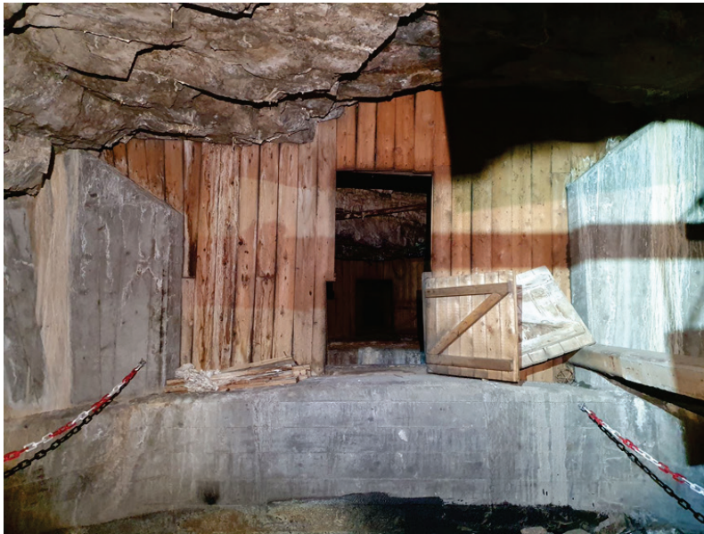
Figur 4. Exempel på berg bakom inklädnadssystem som står fritt från berget från Krångede kraftstation.
