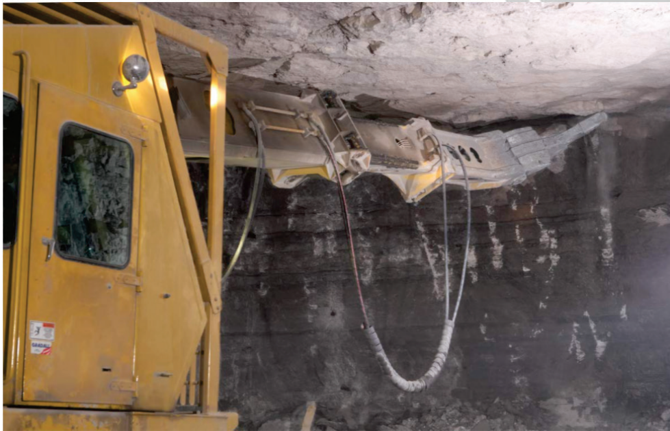
Figur 22. Gradalls skrotningaggregat i arbete.
