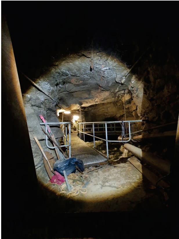
Figur 2. Berg ovan sugrörskonstruktioner från Krångede kraftstation
