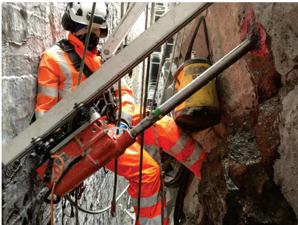
Figur 19. Exempel bild med företaget klätterteknik som utför bergarbeten på projekt Slussen. 25
