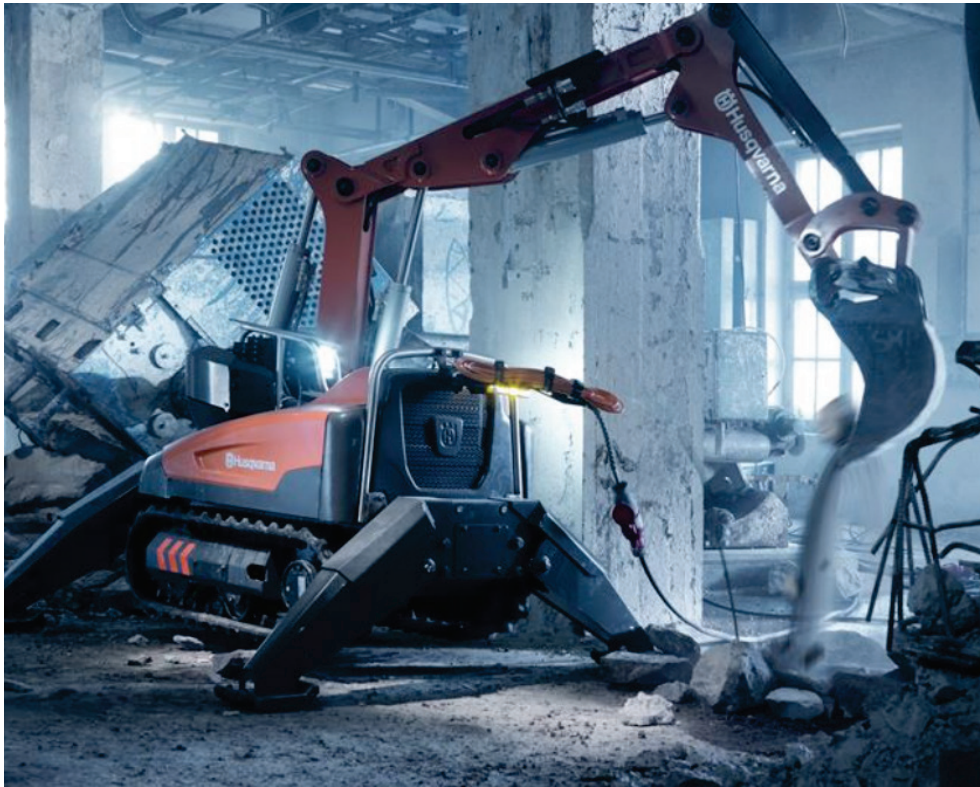
Figur 44. Rivningsrobot från Husqvarna som är utrustad med skopa för att kunna lasta och rensa. I trånga utrymmen. 68
