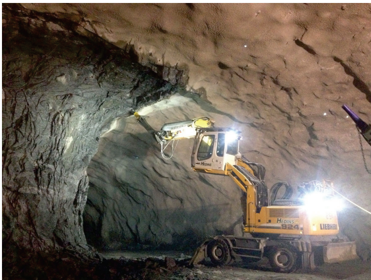
Figur 21. Eldriven Liebherr som skrotar salva i tunneldrift med hammare. Bild från Hedins hjulgrävmaskiner AB.
