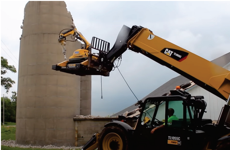
Figur 27. Brokk på kranlyft för skrotning.
