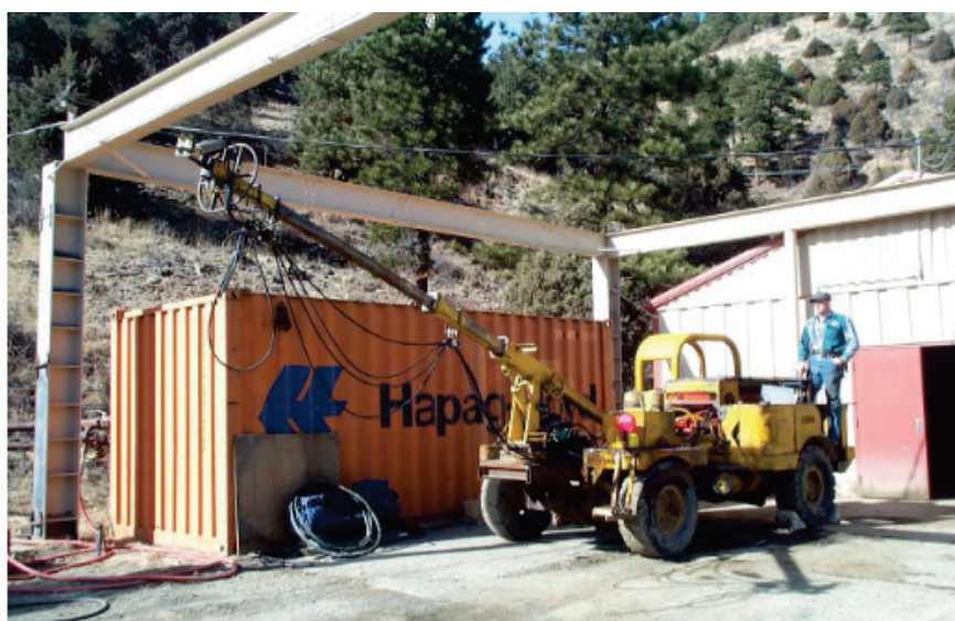
Figur 28. Bild från CSM på den ombyggda Emco lastbilen som användes för vattenskrotningen. 43
