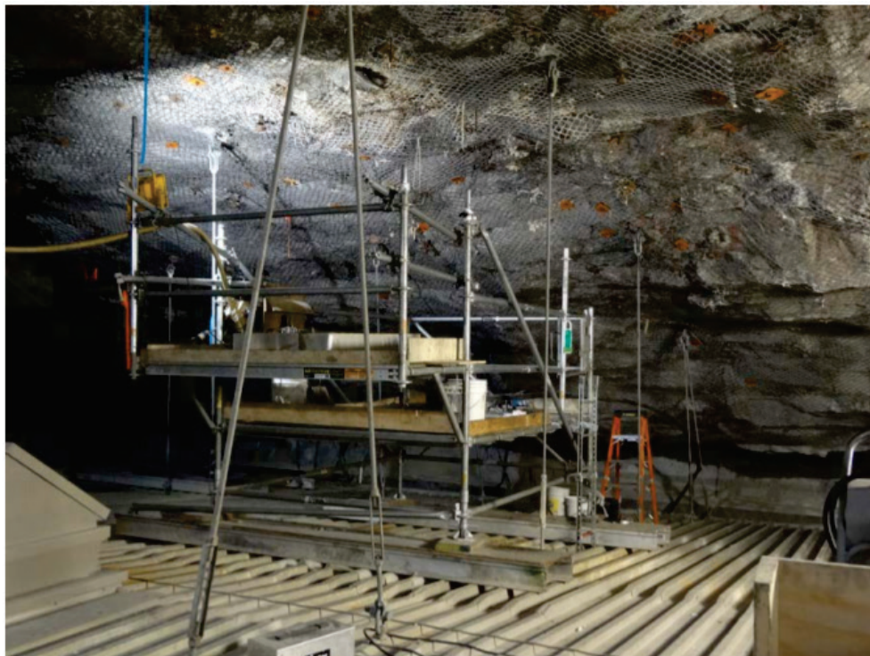
Figur 13. Bild från hydro Quebec på installerade ställningar i förberedelse för skrotning och bergförstärkning ovan skärmtak. 16
