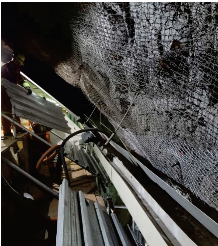
Figur 1. Demontering av skärmtak
