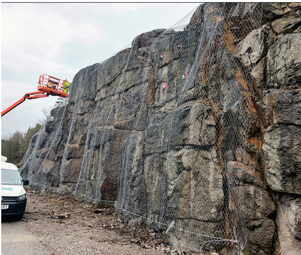
Figur 48. Exempel bild för installerat bergnät.
