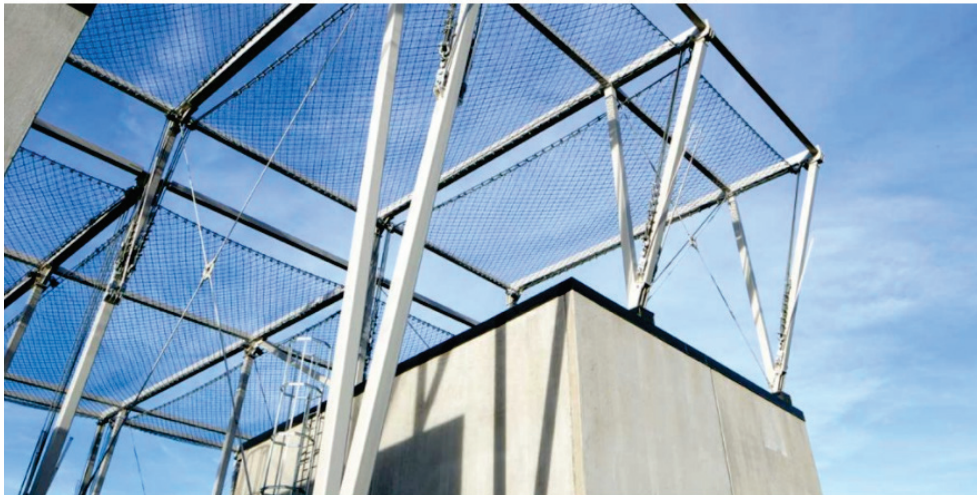
Figur 50. Från LKAB:s gruva Svappavaara där dessa skyddsnät installerades.
