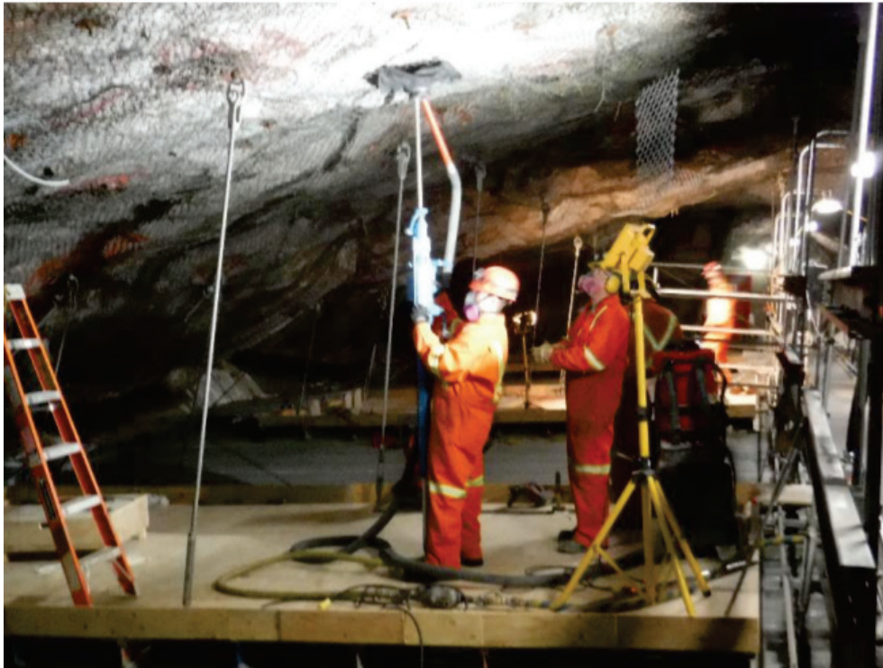
Figur 14. Från Hydro Québec med bultförankring från en fastsatt ställningsplattform 17 .
