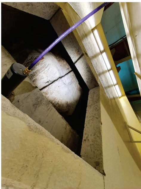
Figur 5. Berg bakom betonginklädnad från Krångede kraftstation.
