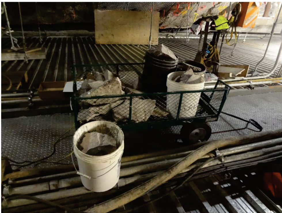
Figur 40. Transport av skrotat material ovan maskinsal och bakom skärmtak. 63
