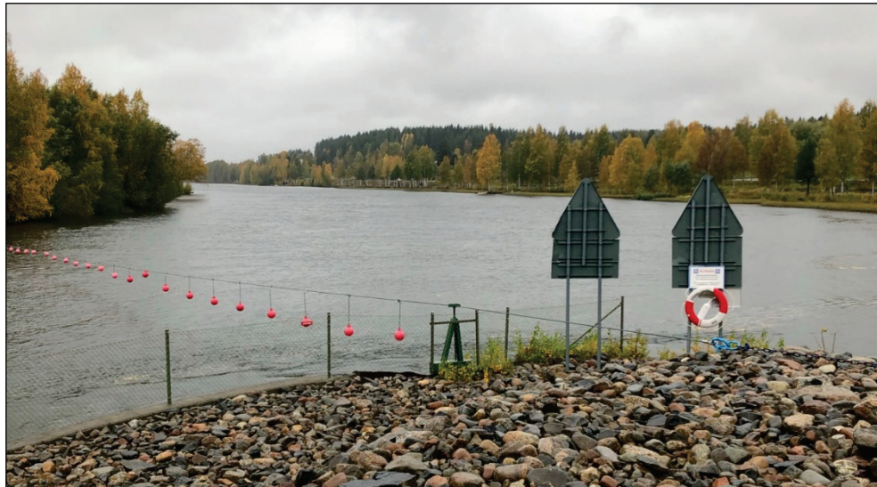
Figur 5. Säkerhetsvajer vid Bergsbyns regleringsdamm i Skellefteälven. Foto: Lisa Carlsson, Sweco.
