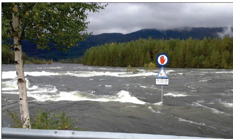
Figur 3. Samma plats som i bilden ovan men med öppna utskovsluckor vid den uppströmsliggande vattenkraftanläggningen. Foto: Ole Morten Egeland, Agder Energi Vannkraft. 16
