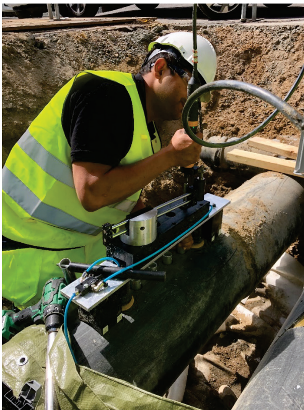
Figur 3: Mätning i fält med RISE pluggmetod
