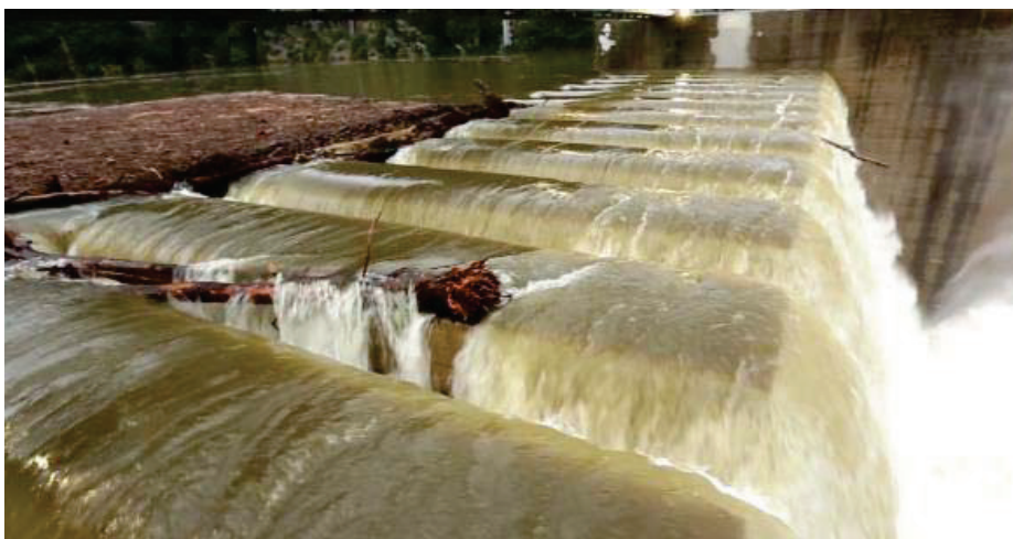
Figur 5.5 Beteenden av drivgods av träd vid pianotangentöverfall (Gebhardt et al. 2017).
