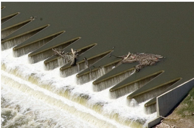
Figur 3.5 Labyrintöverfall vid Lake Brazos-dammen, Waco, Texas, USA. (a) modellförsök, (b) prototyp i drift (Crookston 2010).
