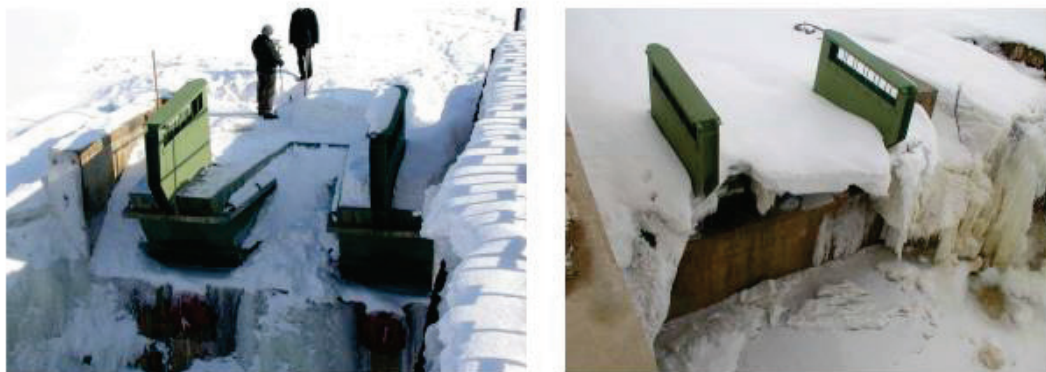
Figur 5.9 Istäcke över s.k. fuse gate (Chapuis 2018).
