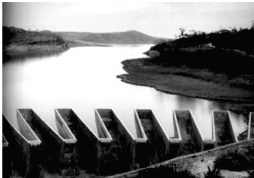
Figur 4.4 Pianotangentöverfall med uppströmsöverhäng vid Bakhada-dammen (45 m hög), Algeriet (Lempérière et al. 2011).
