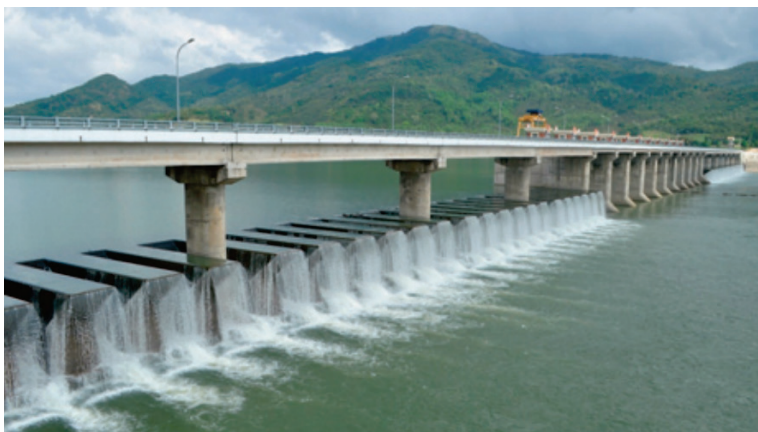
Figur 1.10 Ett långt pianotangentöverfall i Van Phon-dammen(foto VNCold).
