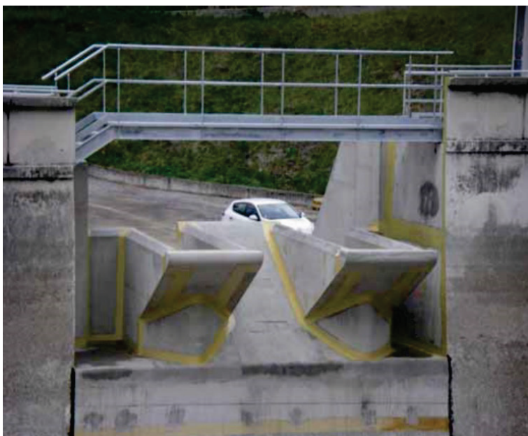
Figur 1.8 Pianotangentöverfall vid Gloriettes respektive Escouloubre-dammen, Frankrike (foto EDF respektiv S. Ercicum vid University of Liege).
