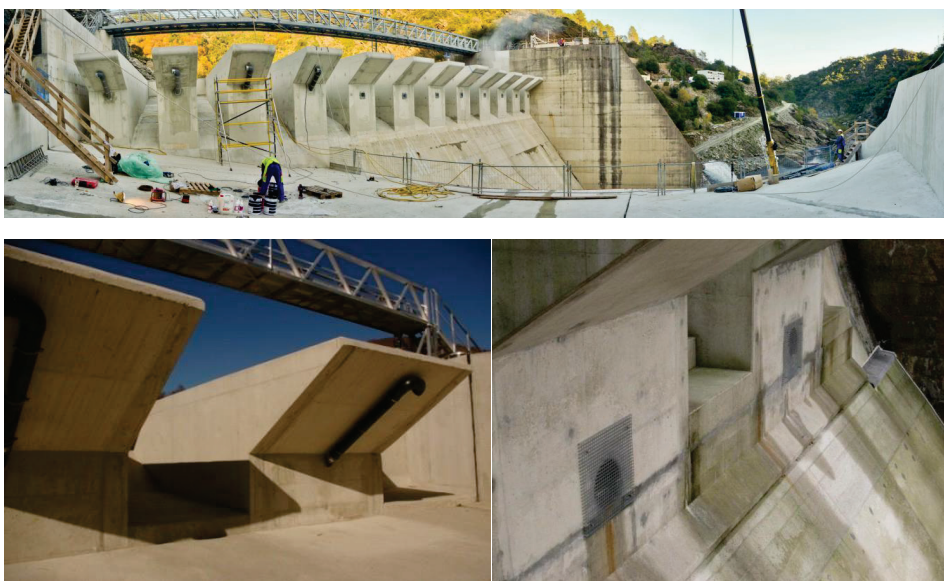
Figur 5.3 Luftningssystem för pianotangentutskov vid Malarce-dammen (Pinchard et al. 2013).
