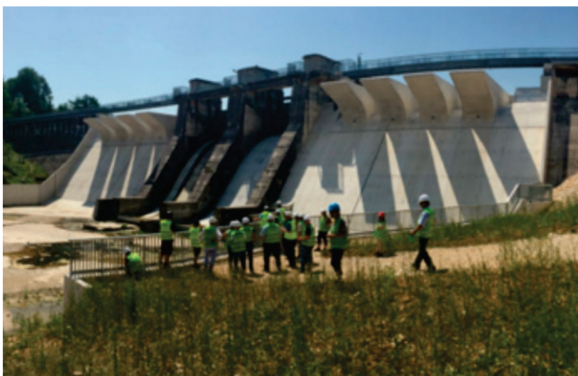
Figur 1.9 Pianotangentöverfall som EDF byggt på bägge sidorna av ett ytutskovsparti i befintlig Charmines-damm (foto EDF).
